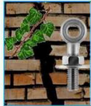
Schade aan gevel
