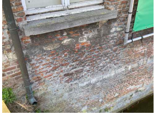
STERK VERVUILDE WITTE STEEN TER HOOGTE VAN HET WATER
