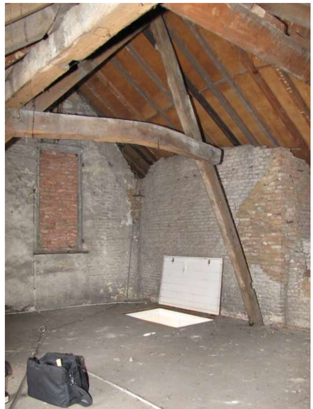
DE DAKSTRUCTUUR HEEFT EEN INDIFFERENTE WAARDE WEGENS DE VERSCHILLENDE AANPASSINGEN DOOR DE EEUWEN HEEN. (BRON: TRICONSLT NV)
