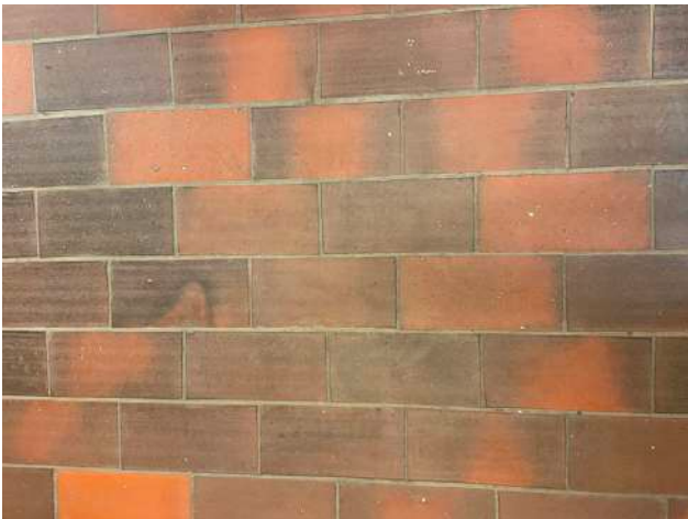
TEGELVLOER - RUIMTE 0.08 (SANITAIR)
