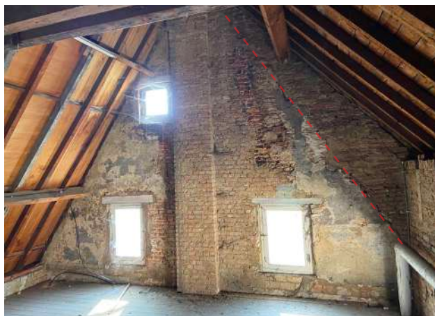
OP ZOLDER IS HET BOUWSPoor VAN DE OUDE HELLING ZICHTBAAR. DE TWEE RAAMOPENINGEN ONDERAAN ZIJN NOG ORIGINEEL. LANGS DE BUITENZIJDE ZIJN DE NEGBLOKKEN NOG AANWEZIG.
