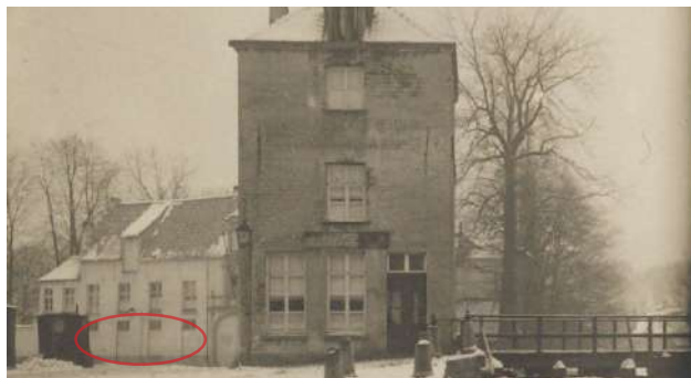
DE RAMEN VAN HET GELIJKVLOERS ZIJN ONDERAAN DICTGEMAAKT OMDAT HET GEBOUW TOEN GEBRUIKT WERD ALS KOETSHUIS. (BRON: BEELDBANK LIER)
