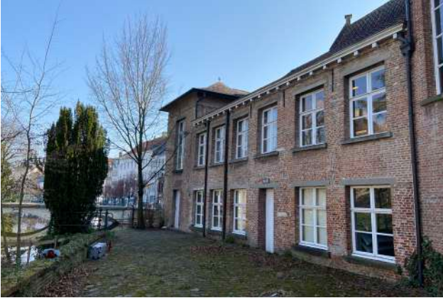
GEVEL BOUWFASE 4 IN BAKSTEENMETSSELWERK. ÉÉN ZANDSTEENBLOK IS NOG OVERGEBLEVEN IN DE GEVEL NAAST DE DEUROPENING.
