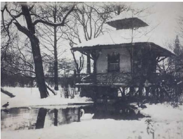
OP EEN FOTO VAN BEGIN 20STE IS HET EENDENPAVILJOEN NOG AANWEZIG (BRON: BEELDBANK LIER)
