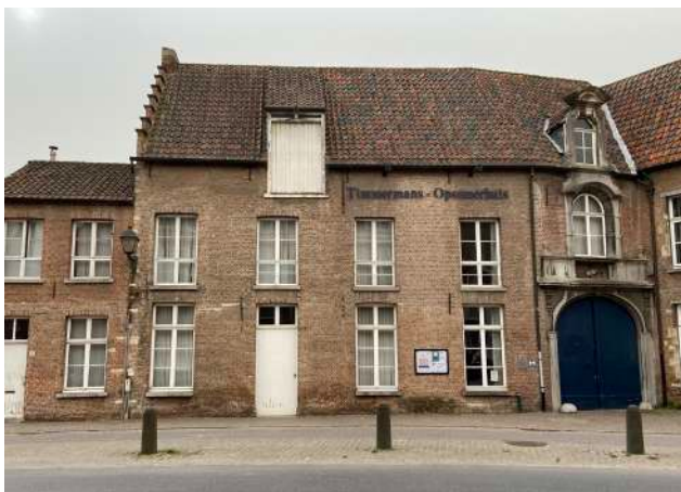
VOORGEVEL VAN DE TWEDE OUDSTE FASE IN BAKSTEENMETSSELWERK EN ZANDSTEEN. DE ZANDSTENEN ZIJN IN DE HOEKEN NOG ZICHTBAAR, NAAST DE VOORDEUR EN ONDER HET VIERDE RAAM
