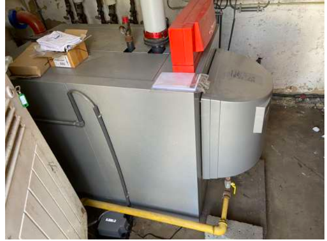
TEGELVLOER - RUIMTE 0.18 (TECHNISCHE RUIMTE)
