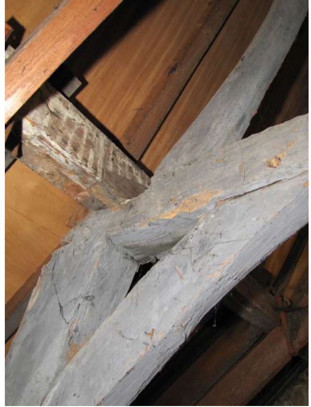
INSECTAANTASTING SPANTBEEN DAK 3 (GEBOUW A)
