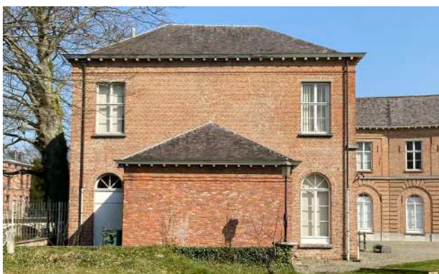
HUIDIGE SITUATIE HOOGSPANNINGSCABINE. DEZE IS GEBOUWD IN 1969 SAMEN MET HET ZWEMBAD.
