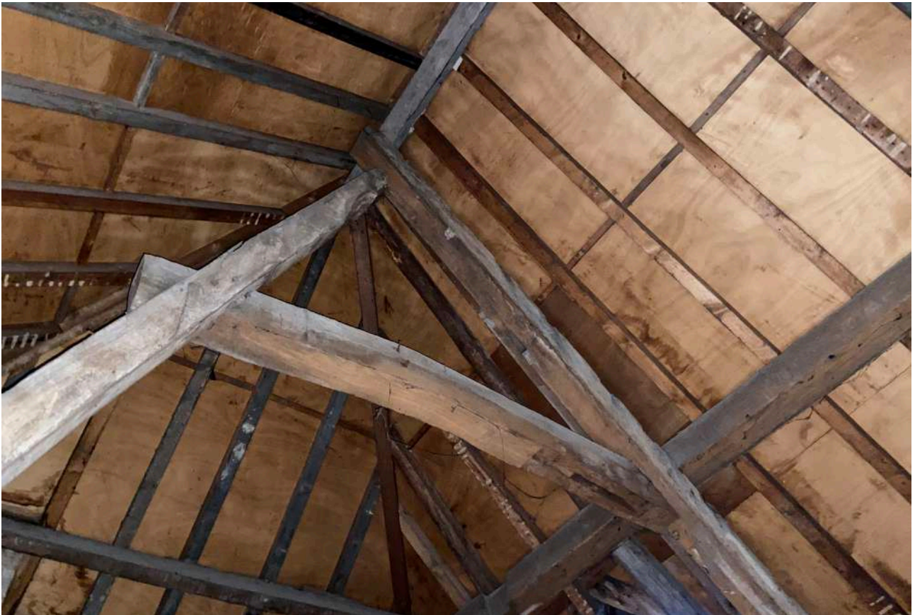
GEBRICOLEERDE DAKSTRUCTUUR VAN DAK 2 (GEBOUW C)
