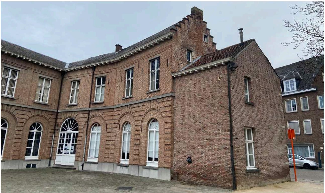
FOTO VAN DE HUIDIGE TUINGEVEL. HIER IS HET PLEISTERWERK AFGEKAPT EN ZIJN DE RAMEN VAN HET GELIJKVLOERS GELIJKAARDIG ALS DEZE VAN BOUWFASE 8 OOK DE RAMEN OP DE EERSTE VERDIEPING ZIJN WEER OPENGEMAAKT.
