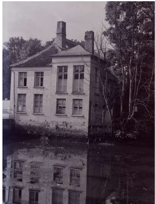
GEVEL VAN HET WATERPAVILJOEN OMSTREEKS BEGIN 20STE EEUW. HIER IS DE GEVEL NOG BEPLEISTERD EN ZIJN DE SCHOUWEN NOG AANWEZIG (BRON: BEELDBANK LIER)
