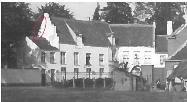
IN 1815 WERD DE OUDE TRAPGEVEL AANGEPAST NAAR EEN SCHUINE KANT. LATER WERD DIT OPNIEUW EEN TRAPGEVEL. (BRON: HUIS VAN OSCAR LIER)
