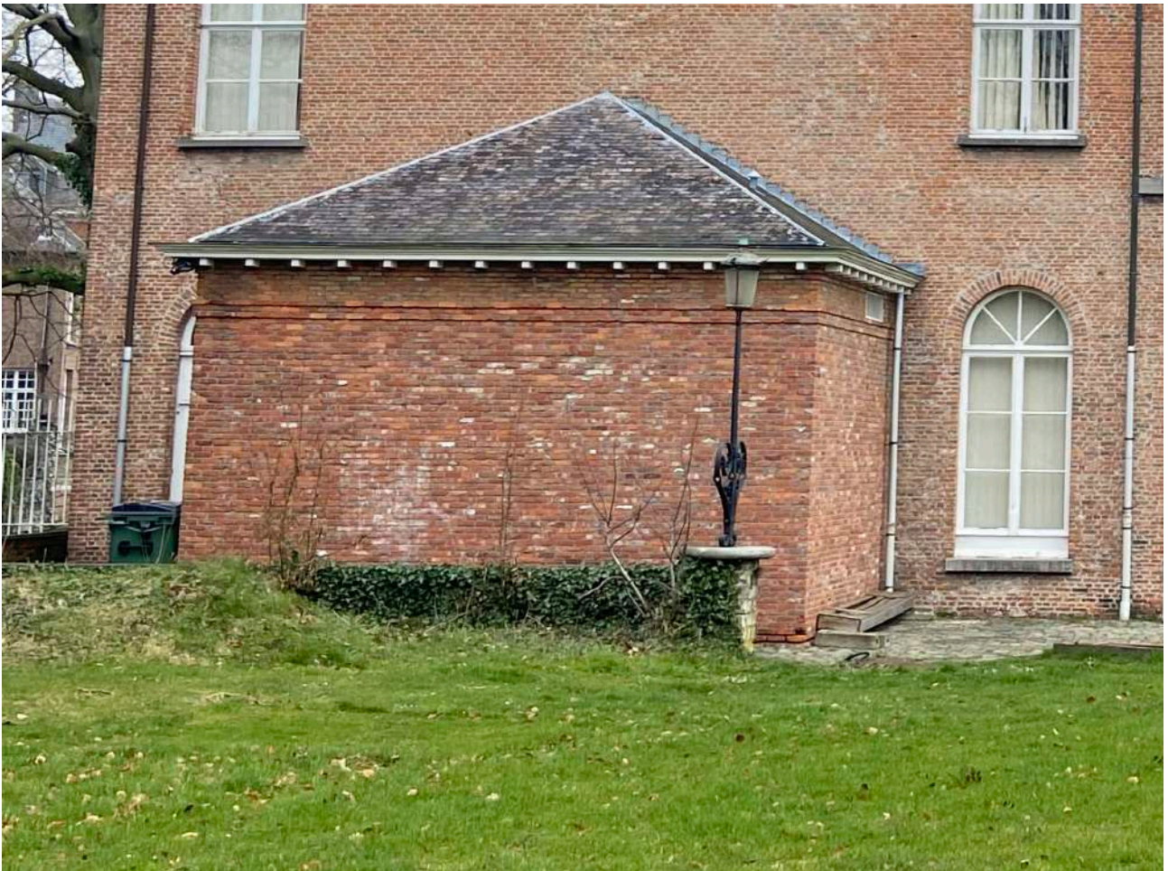
EXTERIEUR GEBOUW I - HOOGSPANNINGSCABINE
