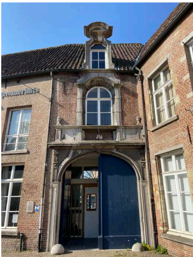
GEVEL BOUWFASE 5 MET POORTINGANG IN BLAUWE HARDSTEEN MET RÉGENCE EN BAROK KENMERKEN.
