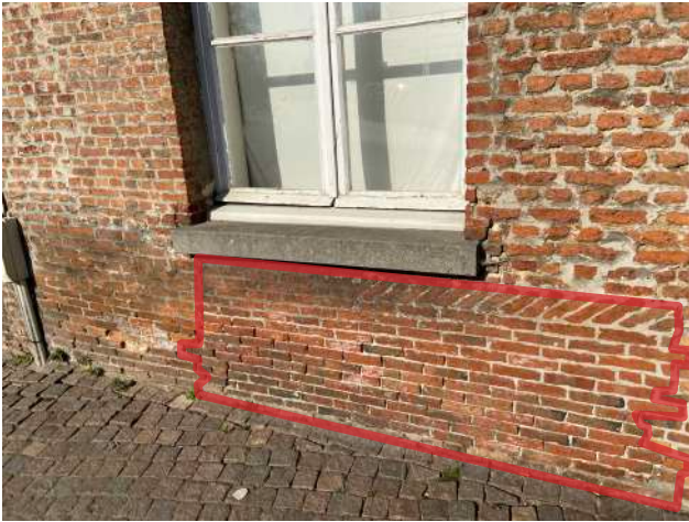
LATERE INVULLINGEN MET BAKSTEEN (AANGEDUID IN HET ROOD) VAN DE STRAATGEVEL VAN GEBOUW C. DEZE WAS NIET ZICHTBAAR ACHTER HET PLEISTERWERK
