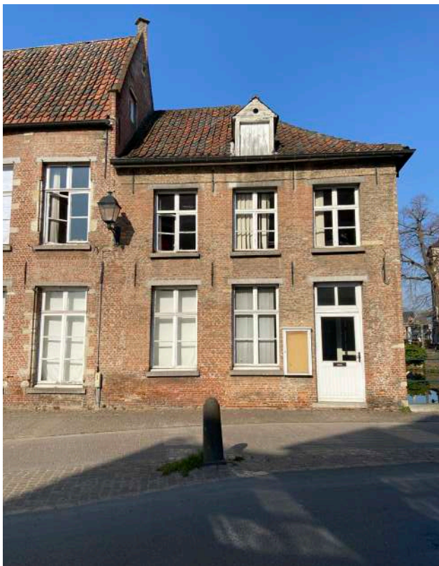
VOORGEVEL VAN DE DERDE FASE IN BAKSTEENMETSSELWERK EN HOEKSTENEN IN ZANDSTEEN. ONDER DE RAMEN IS INVULMETSSELWERK AANWEZIG VAN EEN OUDE DEUROPENING EN/OF KELDERGAT.
