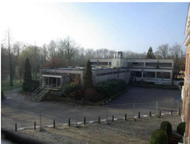
ZWEMBAD GEBOUWD IN 1969 IN VERVAL EN ALVORENS AFBRAAK IN 2011. ZICHT IS GENOMEN VANUIT HET MONUMENT. (BRON: BEELDBANK LIER)
