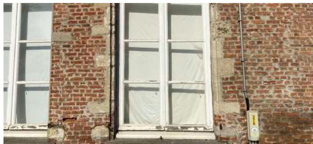
UITGEHOLDE NEGBLOKKEN LANGS DE RAMEN VAN DE EERSTE EN DERDE TRAVEE. HET MIDDELSTE TRAVEE HEEFT GEEN ORIGINELE NEGBLOKKEN IN KALKZANDSTEEN.
