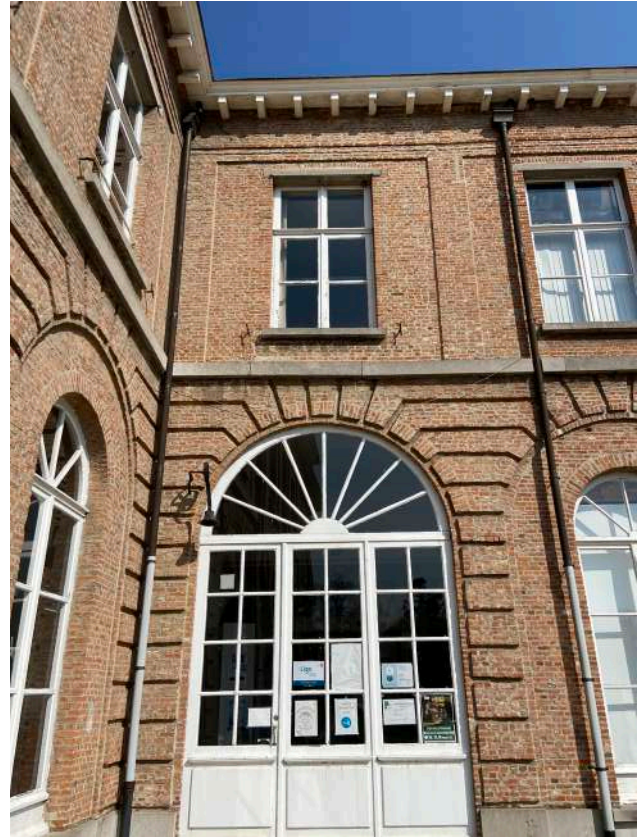
TWEE AFVOERBUIZEN VAN DE TUINGEVEL DEELS IN PVC
