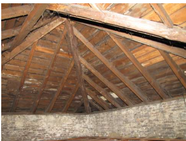
DE DAKSTRUCTUUR VAN HEEFT EEN HOGE MONUMENTENWAARDE
