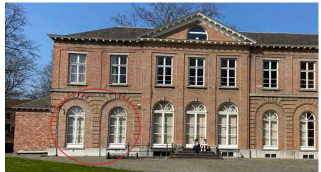
IN DE HUIDIGE SITUATIE ZIJN DE POORTEN VERVANGEN MET GELIJKAARDIGE RAMEN ALS DE ANDERE RAMEN VAN HET GELIJKVLOERS. OOK IS OP DEZE FOTO HET PLEISTERWERK EN DE LUIKEN VERDWENEN.
