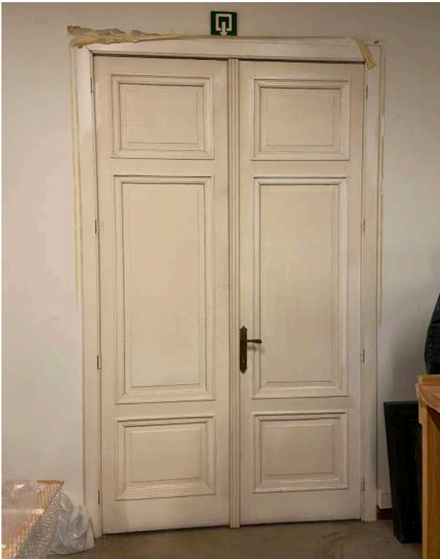
DE DUBBELE DEUR TUSSEN RUIMTE 0.03 EN 0.04 HEEFT EEN POSITIEVE MONUMENTENWAARDE
