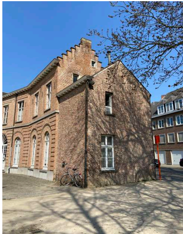
ZIJ- EN TUINGEVEL VAN DE ARBEIDERSWONING NA RENOVATIE. DE DEUR IN DE TUINGEVEL IS TIJDENS DE AANPAK VERDWENEN EN IN DE ZIJGEVEL IS EEN RAAM OP DE GELIJKVLOERSE VERDIEPING TOEGEVOEGD.
