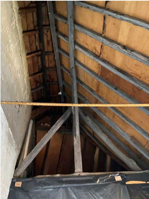
HET DAK VAN DE VERBINDENDE BOUWFASE IS OOK LATER VERHOOGD. DIT IS TE ZIEN AAN DE DAKSTRUCTUUR OP DE ZOLDER.
