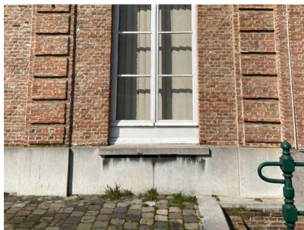
PLINT TUINGEVEL VERVUID DOOR UITLOPERS VAN DE DORPEL
