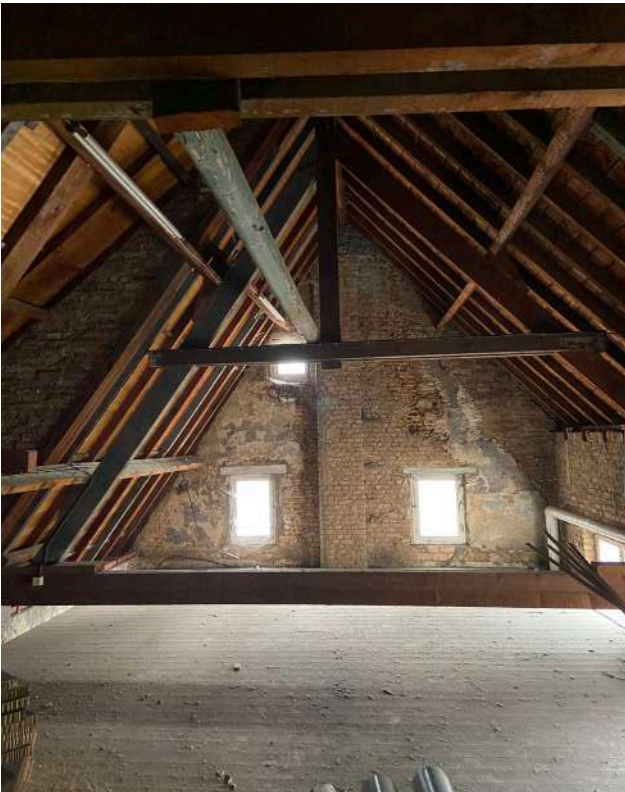
DAKSTRUCTUUR DAK 5 (GEBOUW B)
