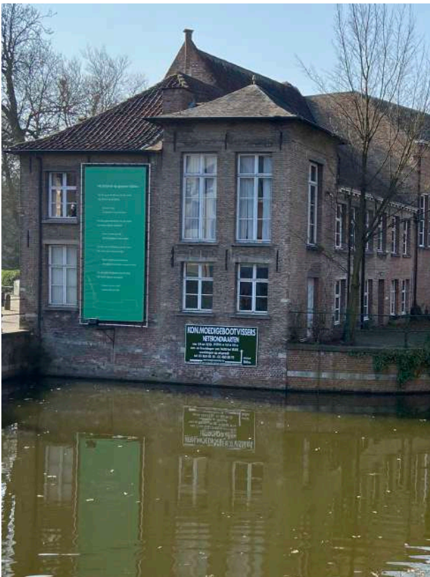
GEVEL VAN HET WATERPAVILJOEN, BOUWFASE 6.
