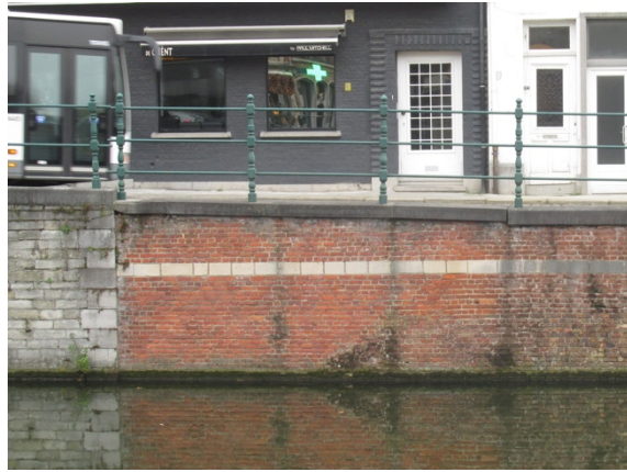
Afbeelding 79: Kademuur ter hoogte van gesupprimeerde trap naar de Nete
