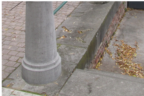
Afbeelding 75: Bevestigingsporen deksteen
