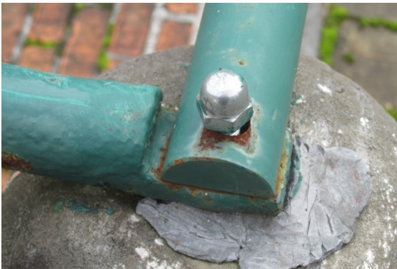
Afbeelding 88: Recente dopmoer en roestvorming ijzeren staven vismijn
