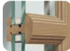
Afbeelding 113: Principetekening glasdelend kleinhout (Ewitherm)
