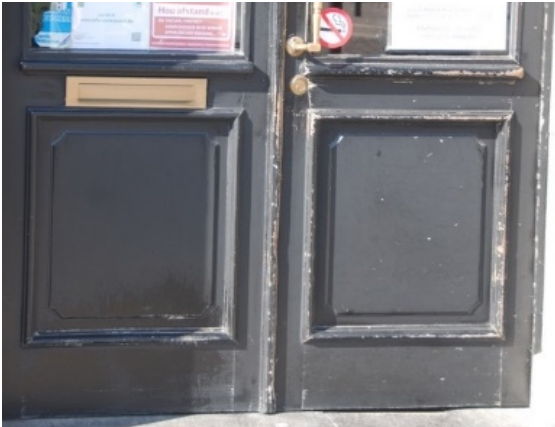
Afbeelding 53: Afschilfering van de verflaag, vergrijzing van de houtstructuur
