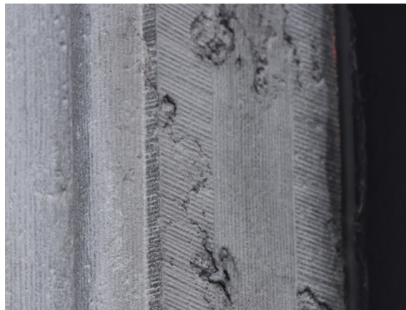
Afbeelding 50: Schilfvorming blauwe hardsteen
