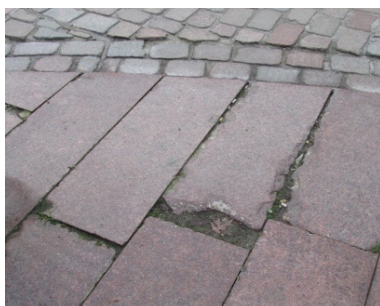
Afbeelding 96: Beschadigde stenen rode granietband
