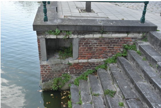
Afbeelding 74: Trap naar de Nete en verschoven deksteen
