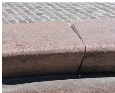
Afbeelding 97: Vershoven blok zitbank
