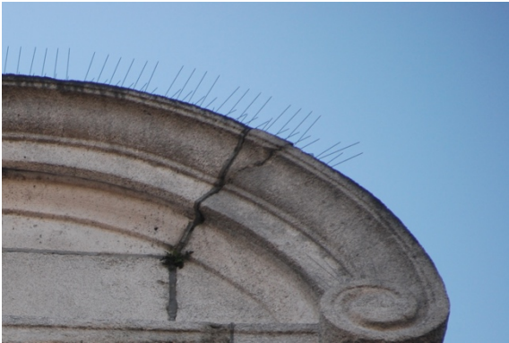
Afbeelding 47: Gescheurde en verweerde deksteen
