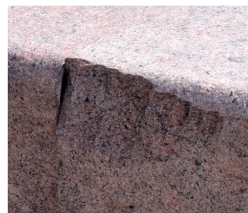
Afbeelding 98: Beschadiging zitbank
