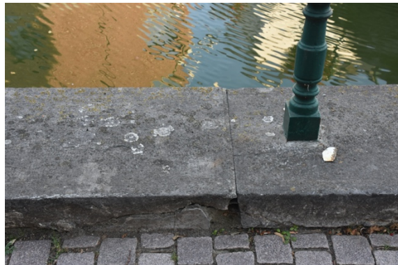
Afbeelding 77: Beschadigde dekstenen
