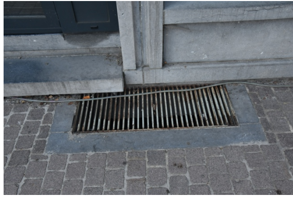
Afbeelding 143: Referentiebeeld afdekking keldergaten met smeedijzeren roostering
