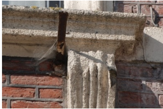
Afbeelding 48: Oppervlakte-erosie
