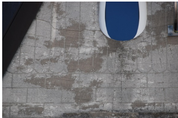
Afbeelding 52: Geërodeerde en gebarsten similibepleistering
