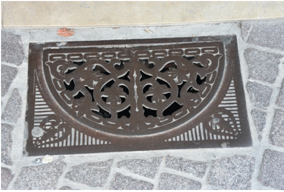
Afbeelding 142: Referentiebeeld afdekking keldergaten met figuratieve smeedijzeren roostering
