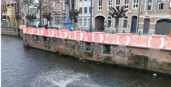
Afbeelding 156: Te verwijderen balustrade
