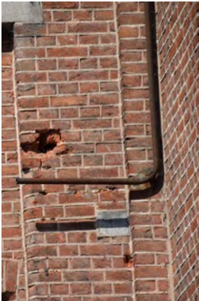
Afbeelding 345. De standpijp is verroest en één beugel is los.
