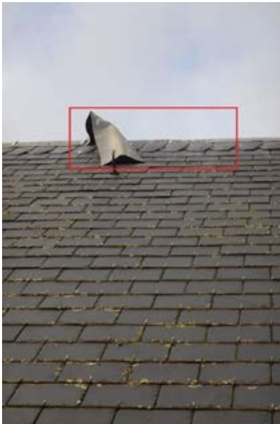
Afbeelding 336. Weinig duurzame kitopvulling. (Bron: verslag Monumentenwacht (12699/2019/B), p. 19)
