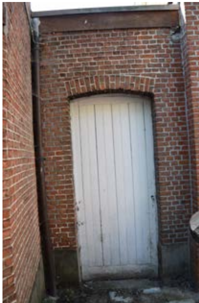
Afbeelding 186. De oorspronkelijke vensters en de deurtogang in de noordelijke gevel van de oostelijke aanbouw.
