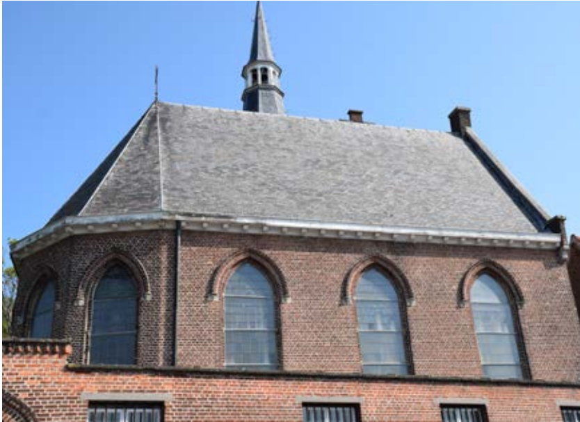
Afbeelding 171. Zicht op de oostelijke gevel van de kapel.
