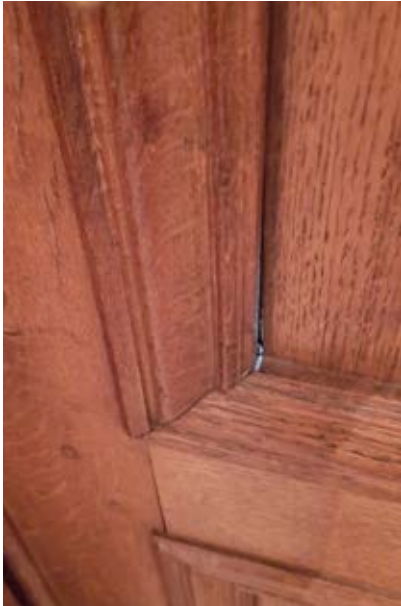
Afbeelding 395. De houten paneel is uitgezakt.
