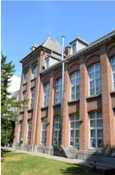
Afbeelding 152. Zicht op de zuidelijke gevel van vleugel B.
