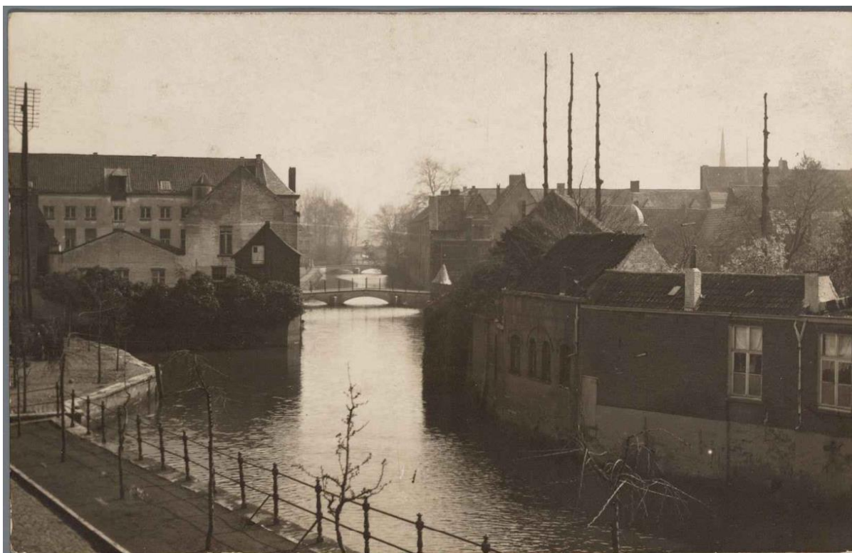
Zicht op verschillende werkplaatsen langs de Neteboord. Ca. 1920. SLI001002521
