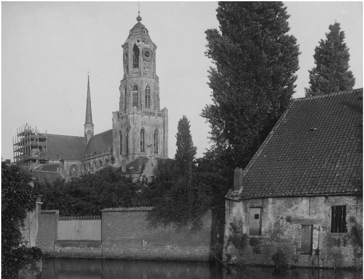
De Smidse heeft hier een kleine schoorsteen op de hoek en het venster is betralied. Het hekwerk aan het Hof van Lier is witgeschilderd. KIK-IRPA, Brussels (Belgium), cliché A016151, Bernard Janssens, Commissariaat Generaal voor 's Lands Wederopbouw.
