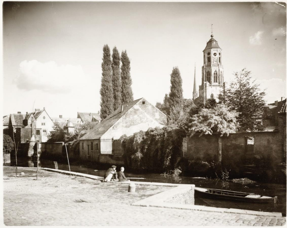
Zicht op de Smidse ca. 1914. De aftekening op de muur duidt op sporen van een schuin dak van een verdwenen werkplaats. De tuilmuren vertonen duidelijk openingen van voormalige poorten en deuren en zijn dus waarschijnlijk buitenmuren. Het primitief kadaster toont bovendien dat er in de negentiende eeuw meerdere werkplaatsen waren langs de Neteboord. SLI001000745
