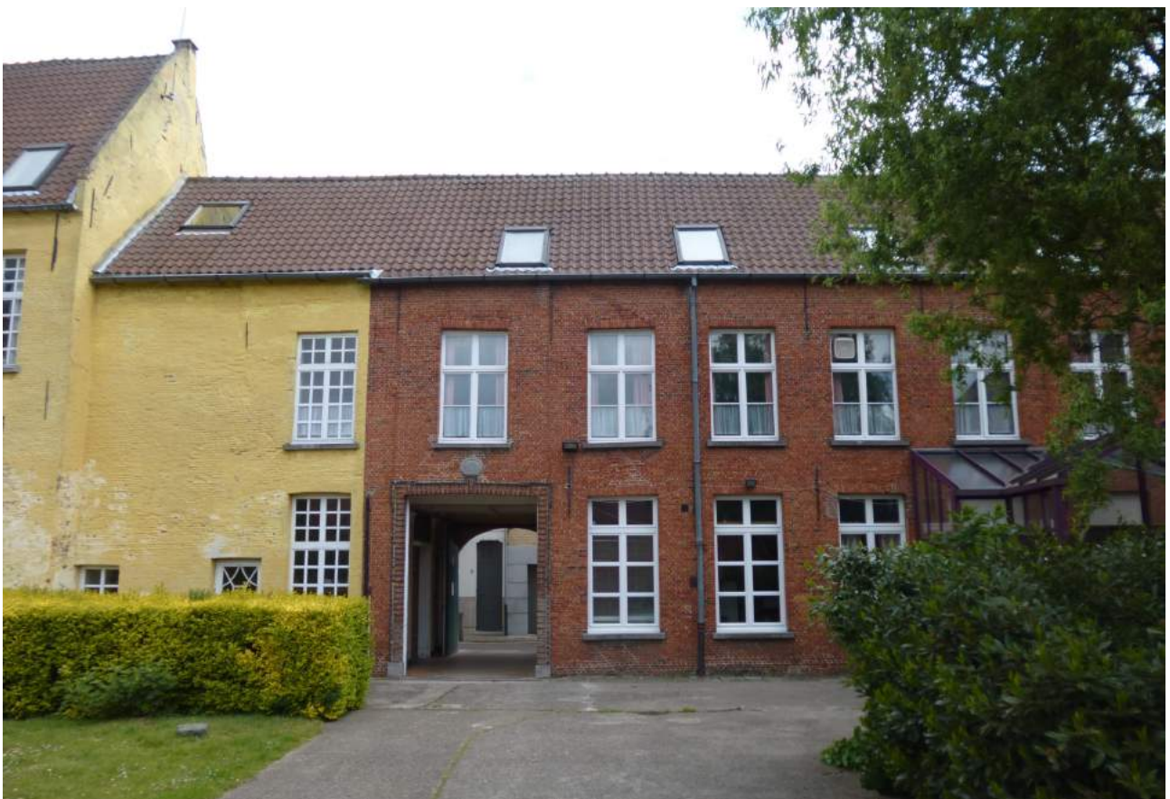
Figuur 5: lijstgevel aan het binnenplein van den Bril, bestaande toestand
