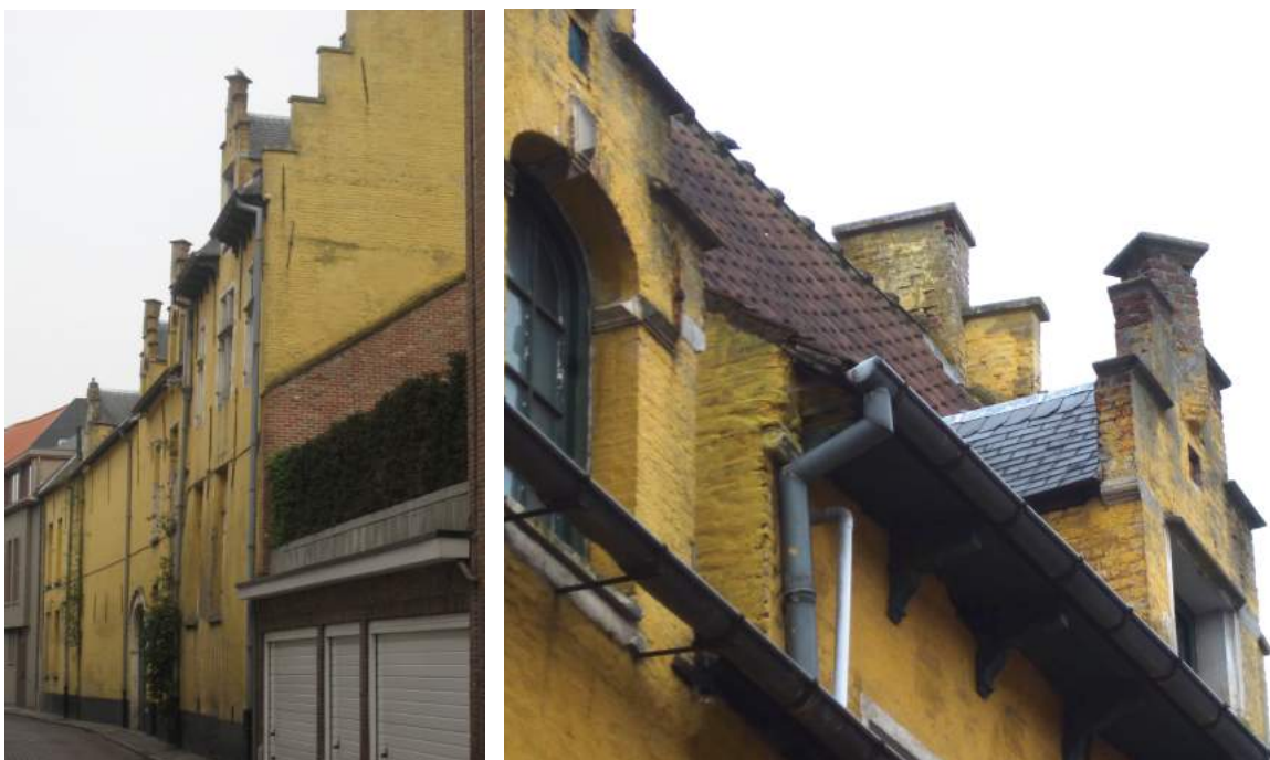
Figuur 24: voorgevel van den Brill; figuur 25: dakkapel in de voorgevel
