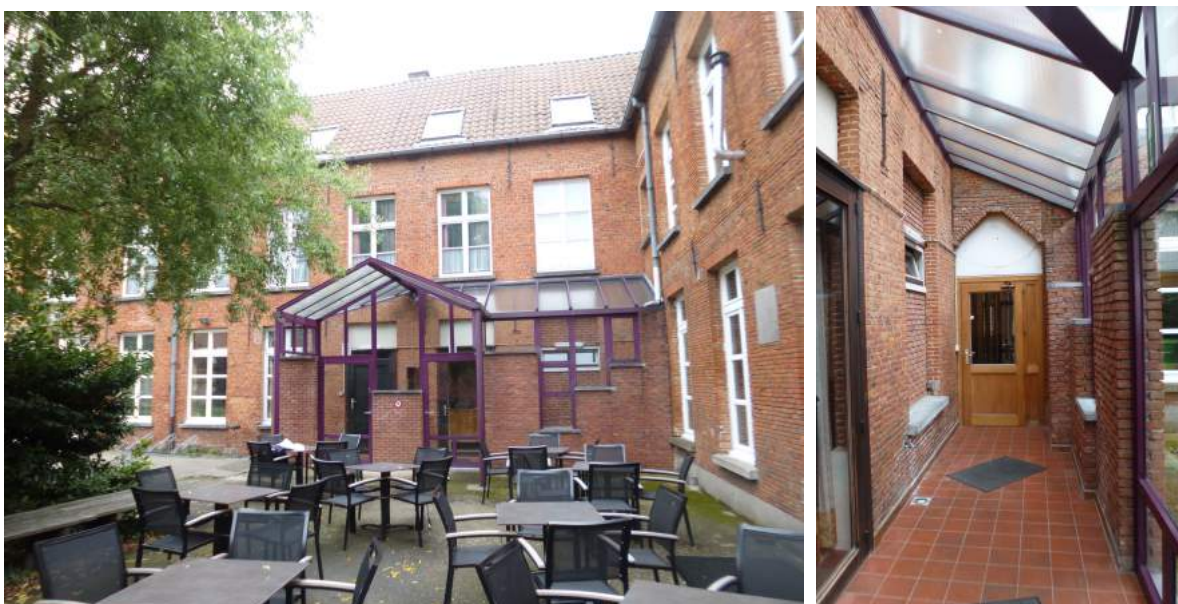
Figuur 26: glazen overkapping tegen de gevels; figuur 27: binnen de glazen overkapping
