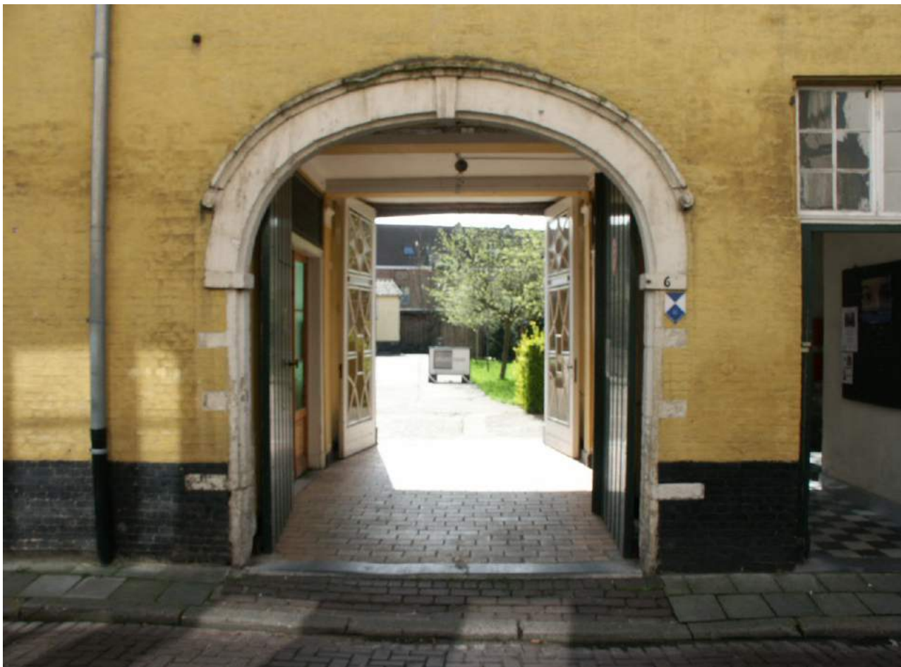
Figuur 6: korfboogpoort die de straat verbindt met de binnentuin, bestaande toestand.
