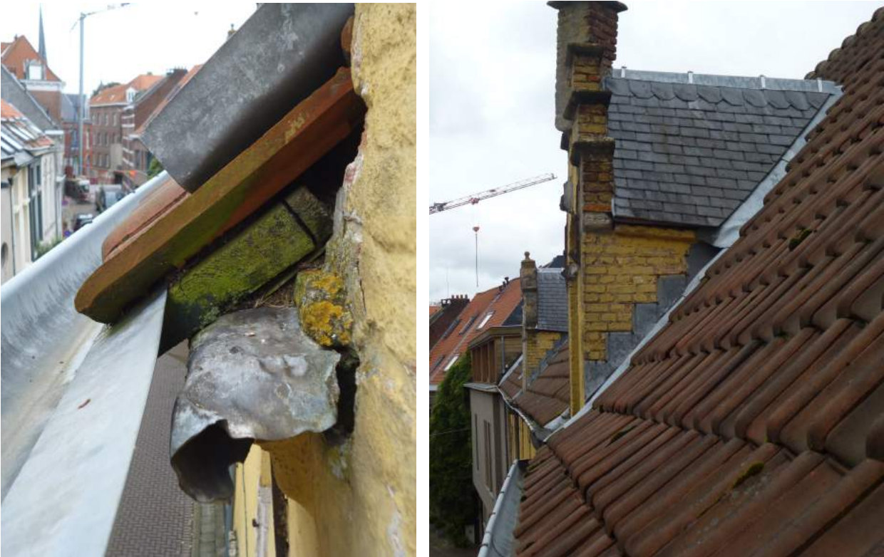
Figuur 36: zinken hanggoot; figuur 32: dakkapel en rode pannen
