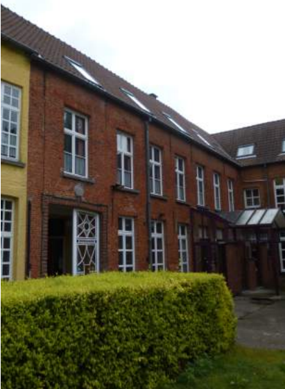
Figuur 31: niet gekaleide deel van de noordoostelijke gevel; figuur 32: geel gekaleid deel van de noordoostelijke gevel met lagere aanbouw tegen de noordwestelijke gevel
