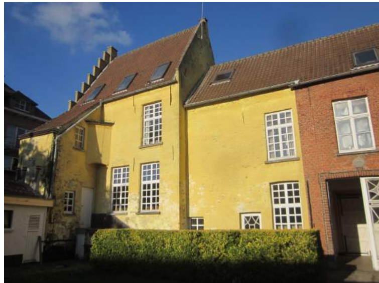
Figuur 31: niet gekaleide deel van de noordoostelijke gevel; figuur 32: geel gekaleid deel van de noordoostelijke gevel met lagere aanbouw tegen de noordwestelijke gevel
