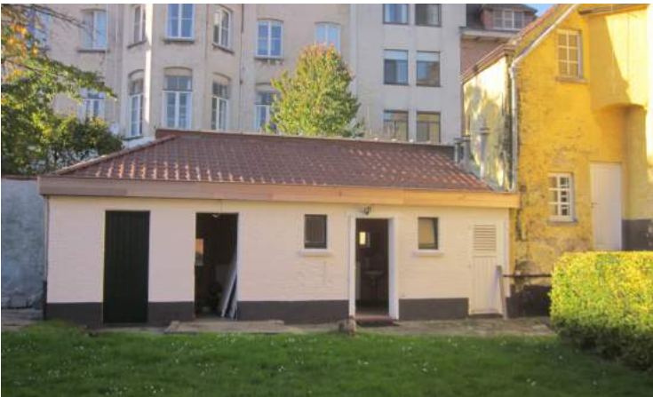
Figuur 35: vernieuwde aanbouw (2017)
