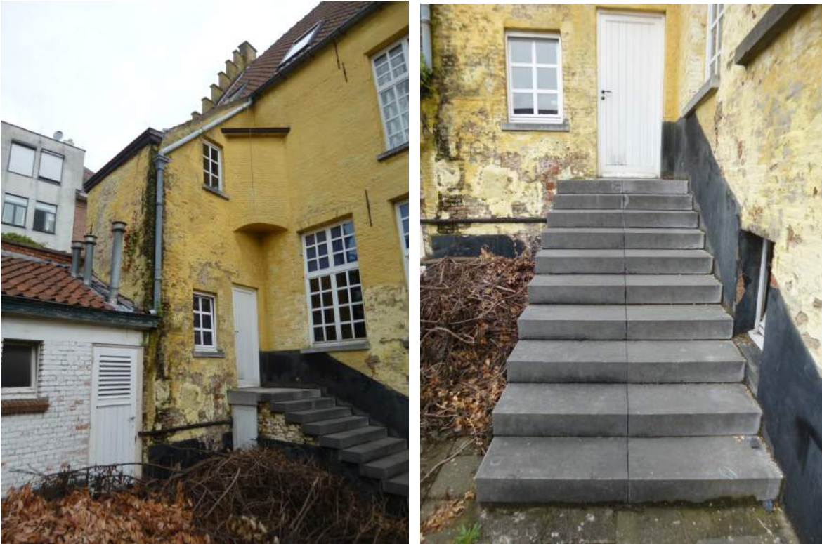
Figuur 33: overgang tussen beide volumes; figuur 34: recente trap uitblauwe hardsteen naast geteerde plint
