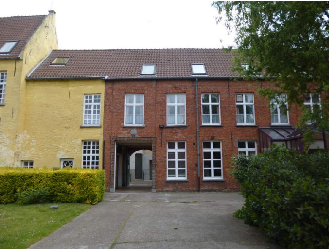
Figuur 30: noordoostelijke gevel – overgang tussen gekaleide en niet gekaleide deel, travée met poort
