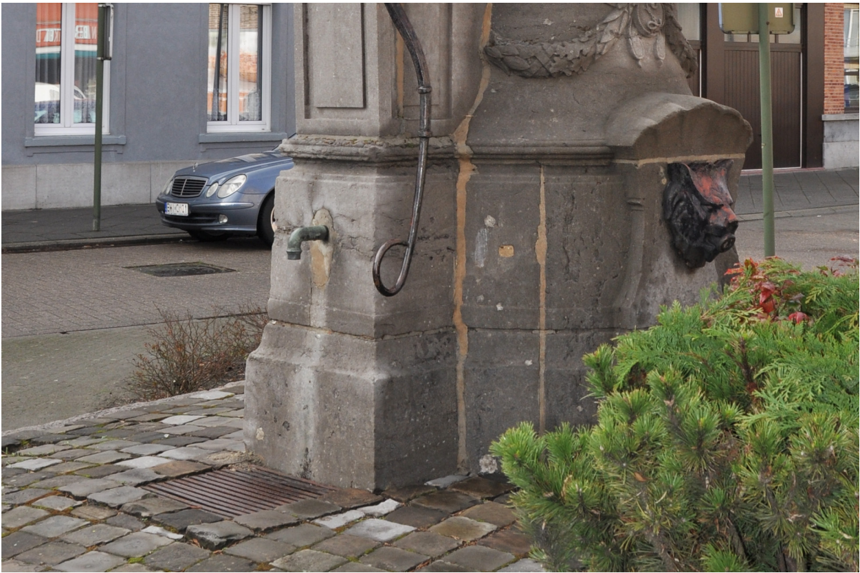
Afb. 20. detail pomphuis: uitloop en rooster, gekrulde pomparm
