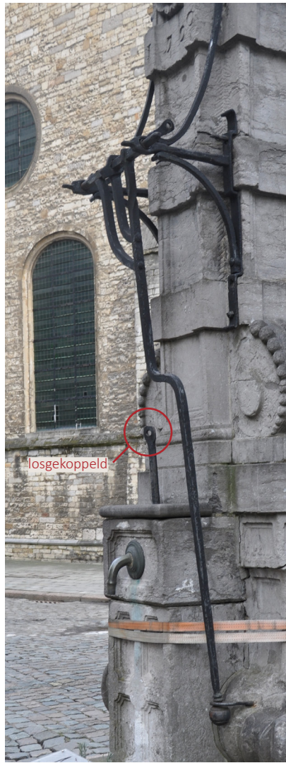
Afb. 14. zwengel van de stadspomp, niet meer verbonden met de pomp
