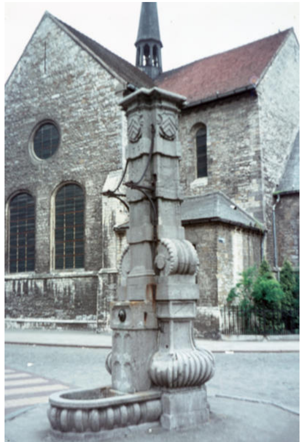
Afb. 22. de pomp met ontbrekende uitloop en zwengel [in de jaren 1960-1970]. Bron: Archief Lier, nr. SLI001032447, te raadplegen op www.kempenserfgoed.be
