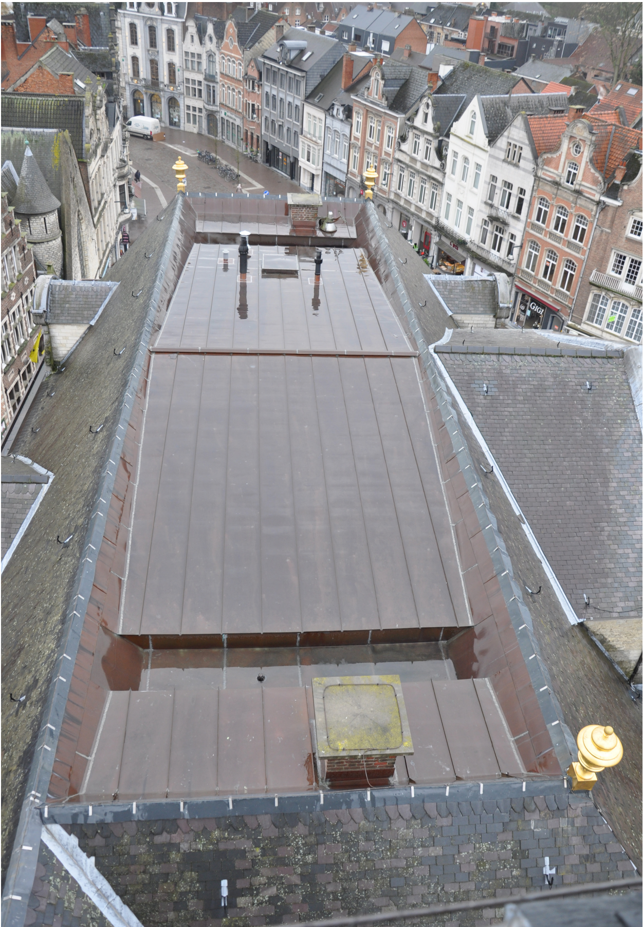
Afb. 22. Het afgeplatte schilddak.
