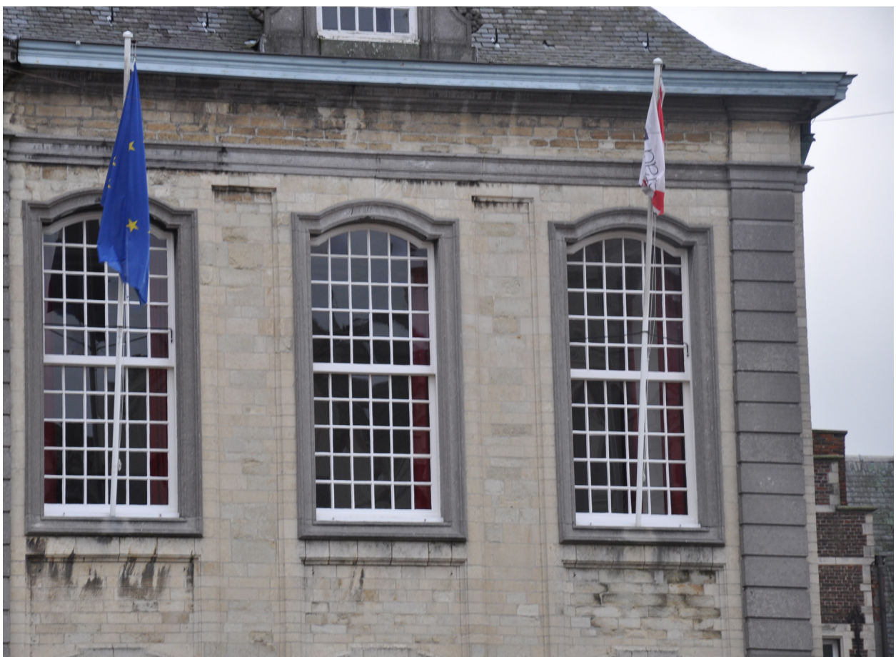
Afb. 28. Detail voorgevel (westgevel).
