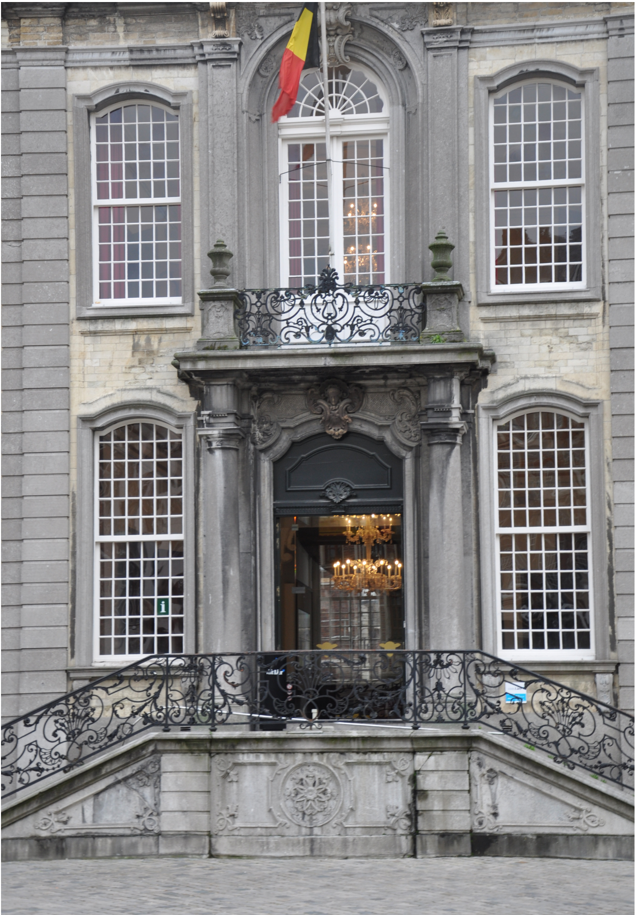
Afb. 29. Detail voorgevel, toegang tot het stadhuis.
