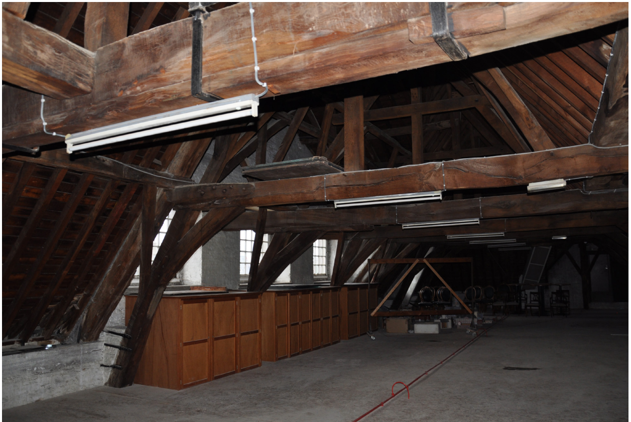
Afb. 16. De zolder van het stadhuis.
