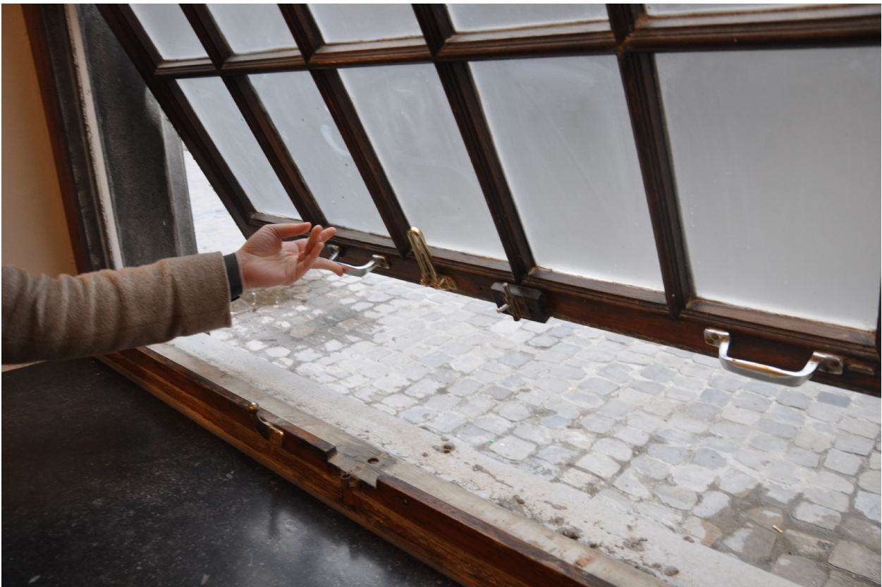
Afb. 49. Wachtzaal met lift en trappenhal, 18de-eeuws raam in achtergevel (11).
