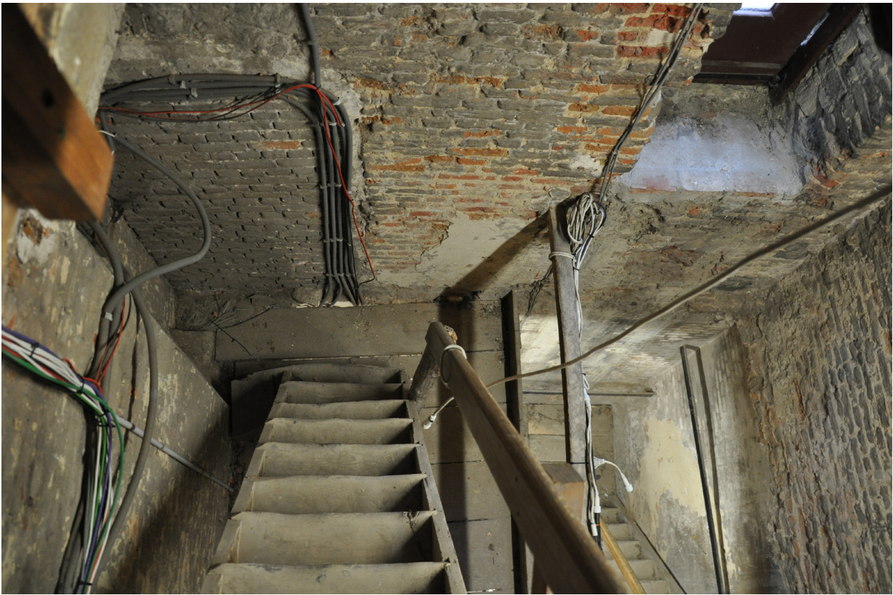
Afb. 67. De houten trappen in het belfort.
