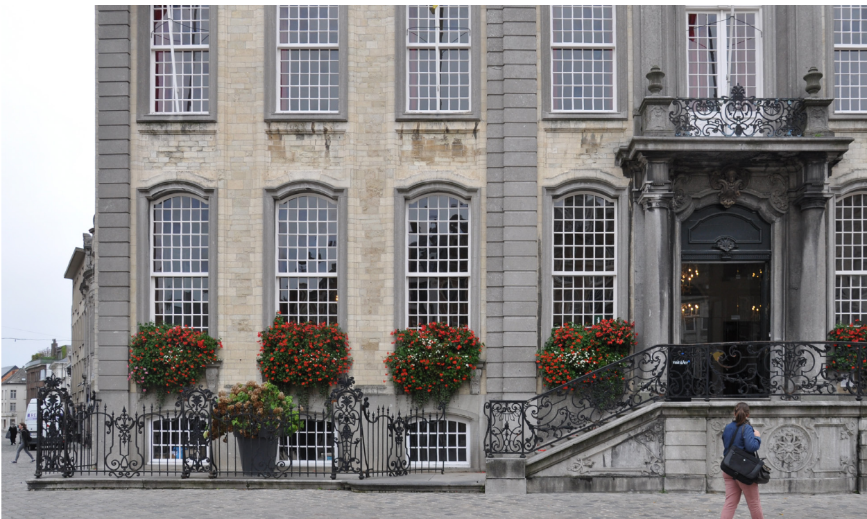
Afb. 26. Detail voorgevel (westgevel).
