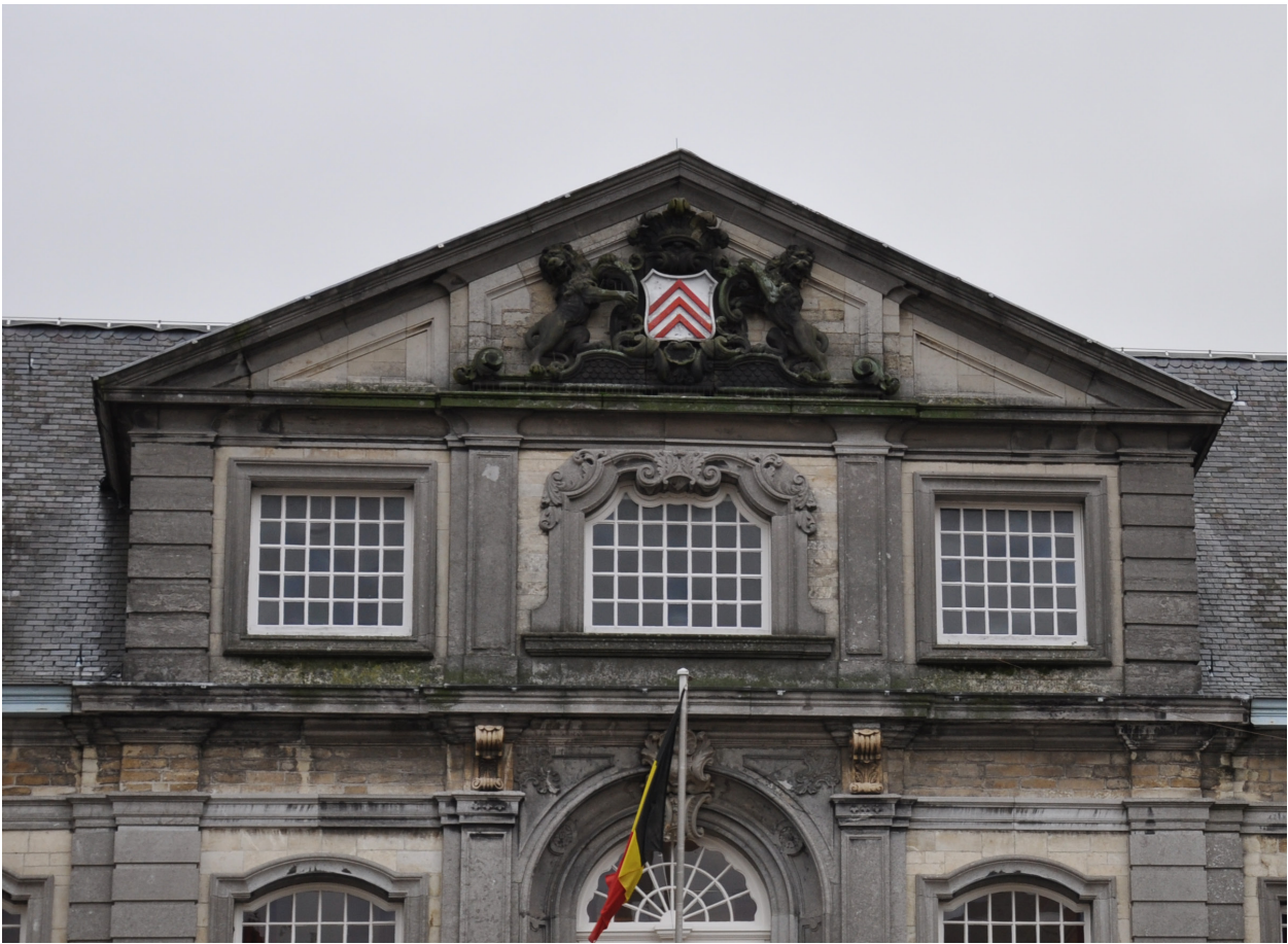
Afb. 30. Detail voorgevel (westgevel).
