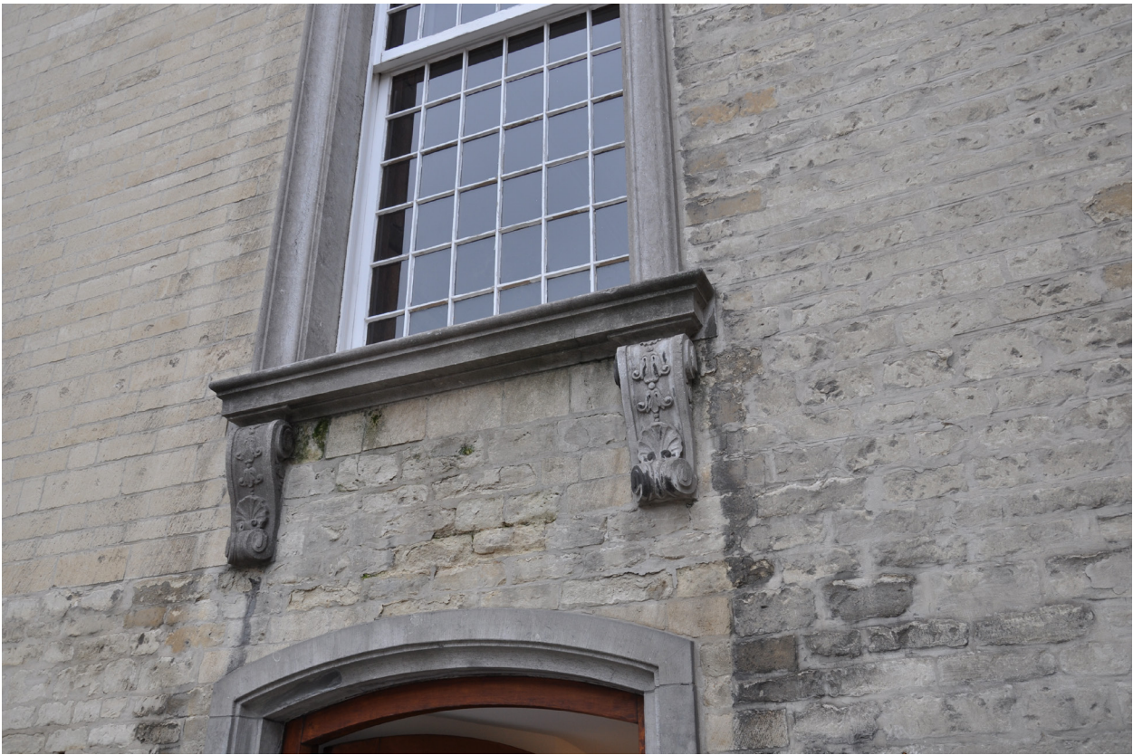
Afb. 35. Detail zuidelijke zijgevel.
