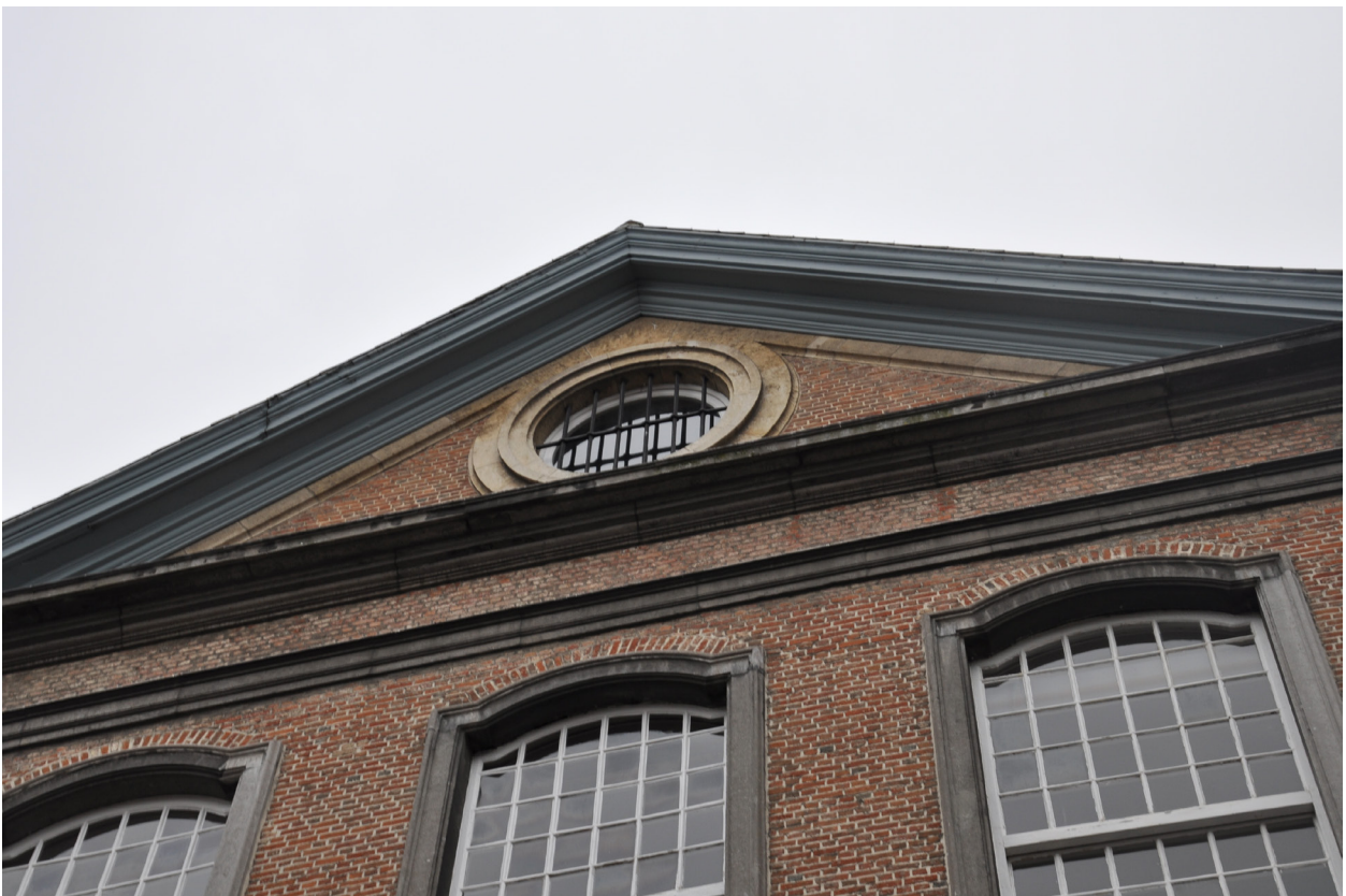
Afb. 33. Detail achtergevel, middenrisaliet zolderverdieping.
