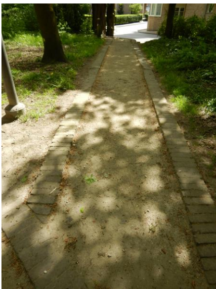
Fig. 3.102: Secundair pad - Verharding dolomiet met kleiklinkers
