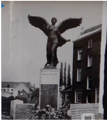
Fig. 2.26: Originele standplaats aan hoek Vismarkt – Hoge Brug – Ergens tussen 1927 en 1967 (Infopaneel monument)
