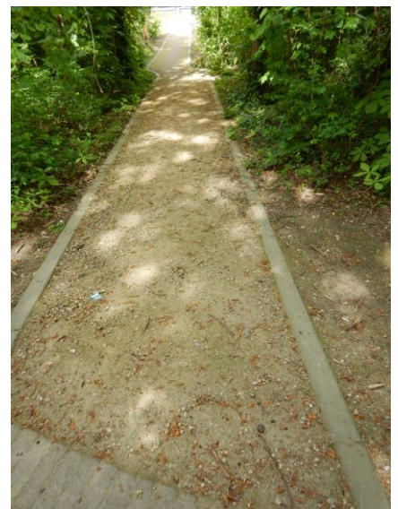
Fig. 3.103: Secundair pad - Verharding dolomiet met boordsteen
