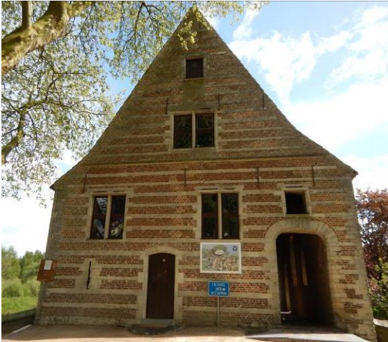
Fig. 3.62: Spui vanop Spuivest gezien
