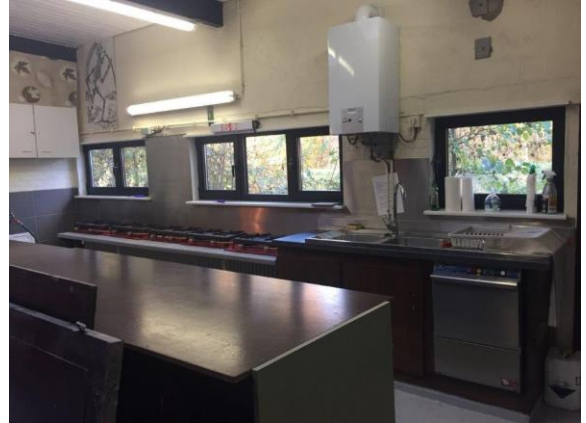
Fig. 3.84: Keuken in aanbouw van de bunker
