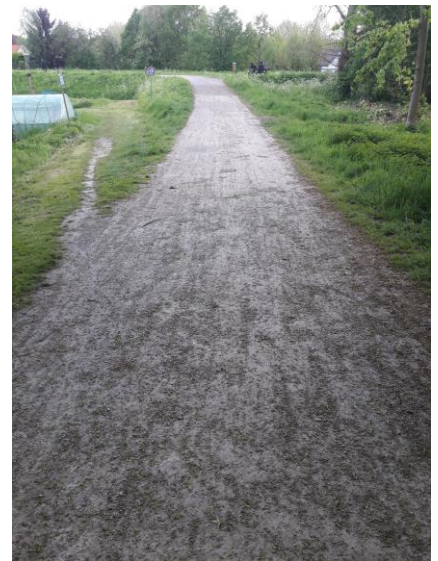
Fig. 3.101: Secundair pad - Verharding dolomiet
