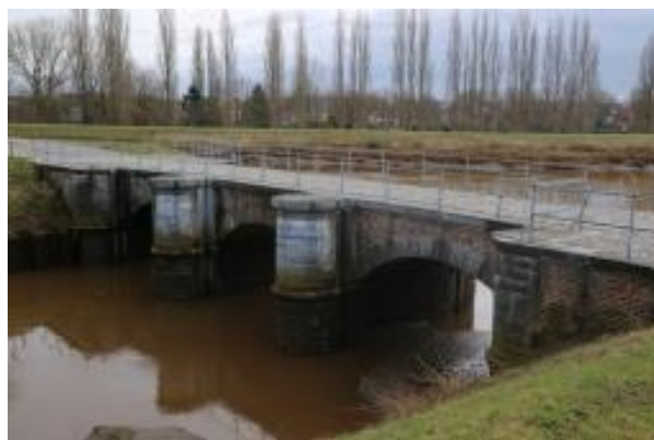
Fig. 3.82: Boogbrug over de Nete
