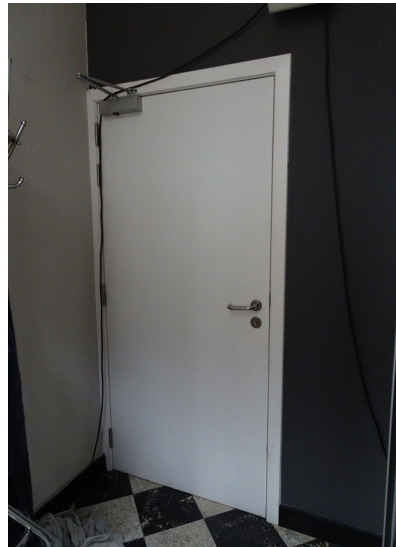
Afbeelding 142. Deur naar de conciërgewoning (eerste verdieping).
