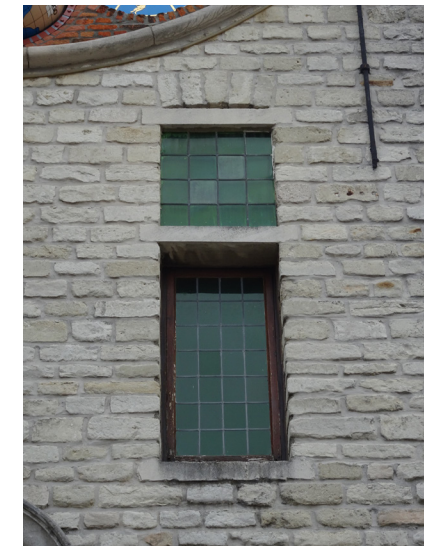
Afbeelding 58. Kloosterkozijn in de noordwestgevel.
