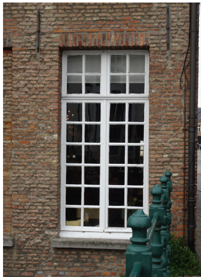
Afbeelding 133. Raam met 24-delige kleinhoutverdeling en vast bovenlicht (8-delig).
