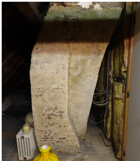
Afbeelding 244. Beschadigde bepleistering.
