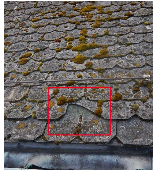
Afbeelding 185. Afgebroken lei. (bron: verslag Monumentenwacht, 2018, p. 7)
