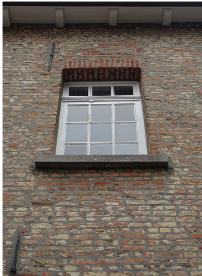
Afbeelding 121. Raam met 9-delige kleinhoutverdeling en vast bovenlicht.
