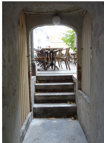
Afbeelding 71. Toegang tot kelder onder de steektrap.
