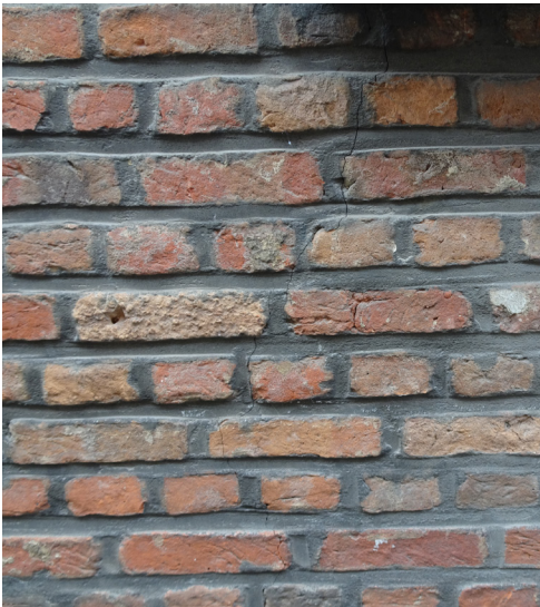
Afbeelding 231. De voegen zijn opgevoegd met een cementmortel.
