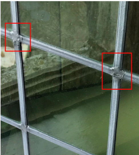
Afbeelding 211. Scheurtjes in het loodnet.
