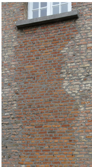
Afbeelding 125. Eén van de bouwsporen in de noordwestgevel.
