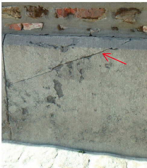
Afbeelding 235. Gescheurde plint. (bron: verslag Monumentenwacht, 2019, p. 17)
