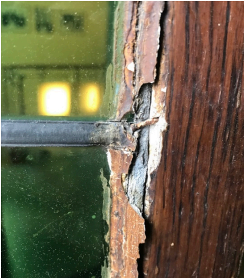
Afbeelding 207. Verbrokkelde mastiek.
