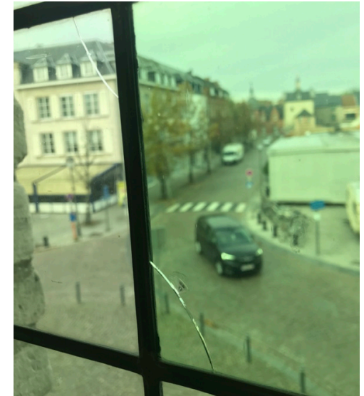
Afbeelding 210. Gebroken glasplaatje.
