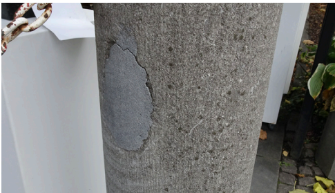
Afbeelding 195. Onvakkundige herstelling. (bron: verslag Monumentenwacht, 2018, p. 16)
