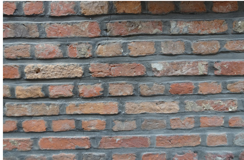
Afbeelding 117. Cementvoegen.
