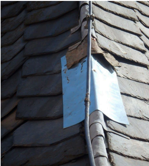
Afbeelding 223. Slecht herstelde hoekkeper. (bron: verslag Monumentenwacht, 2019, p. 10)
