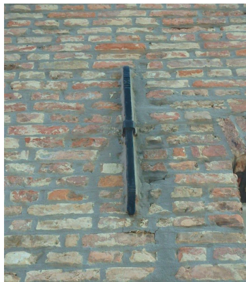
Afbeelding 236. De muurankers zijn over het algemeen in goede staat. (bron: verslag Monumentenwacht, 2019, p. 19)
