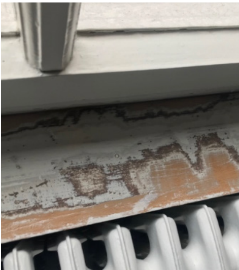
Afbeelding 241. Verschraald schilderwerk.
