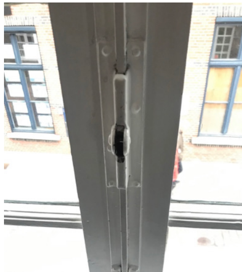
Afbeelding 242. Ontbrekend sluitwerk.
