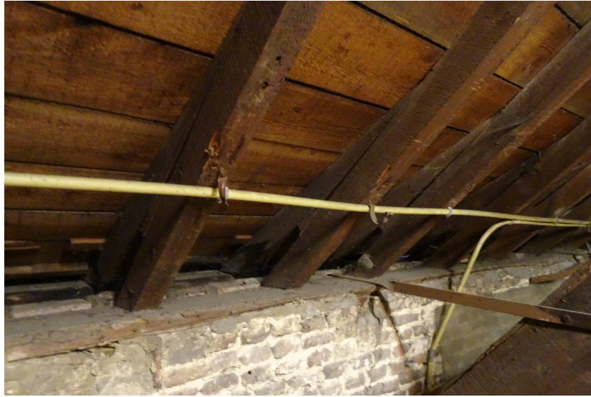
Afbeelding 150. Dakstructuur met kepers, springkepers en bebording.
