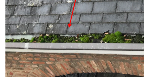
Afbeelding 190. Spuwer bij het dak boven de toegangsdeur en mosbegroeiing in de goot.
