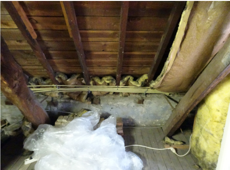
Afbeelding 152. Het dak is deels geïsoleerd met minerale wol.
