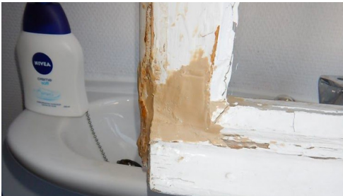
Afbeelding 239. Herstellingen met houtpasta. (bron: verslag Monumentenwacht, 2019, p. 20)
