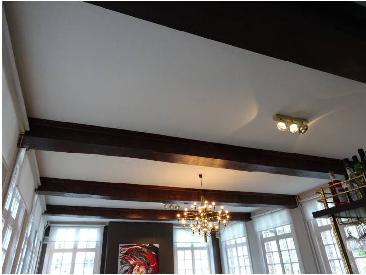
Afbeelding 137. Structuur van moerbalken zichtbaar in de verbruikszaal.
