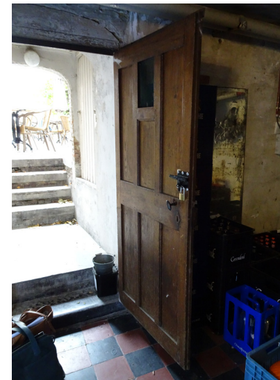
Afbeelding 72. Toegangsdeur tot de kelder.
