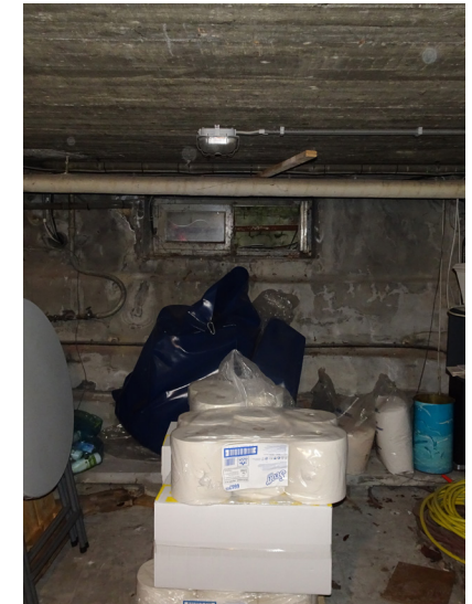
Afbeelding 173. Kelderverdieping van het Zimmerpaviljoen.
