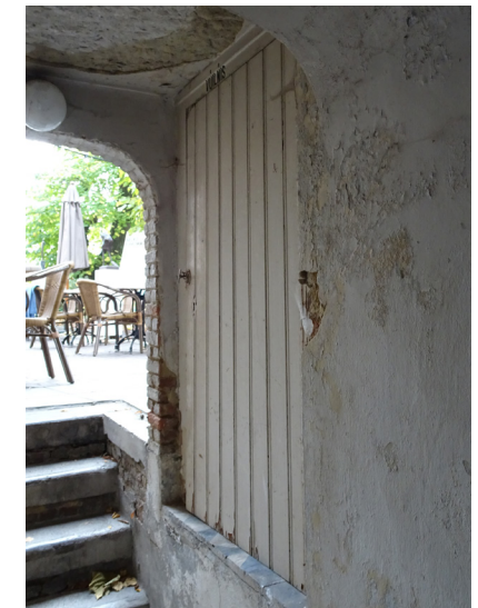
Afbeelding 73. Opgeklampde deur van één van de twee bergruimtes.
