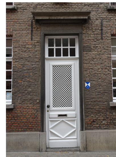
Afbeelding 130. Toegangsdeur tot het Schippershuis.
