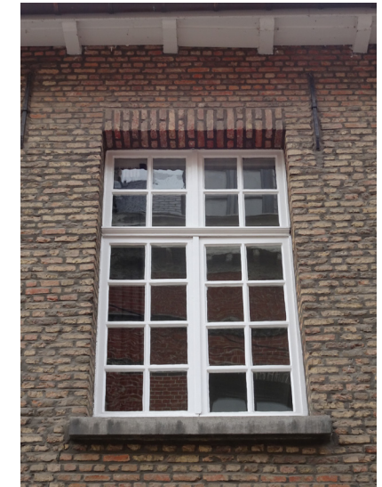
Afbeelding 118. Rechthoekige raamopeningen met kleinhoutverdeling.
