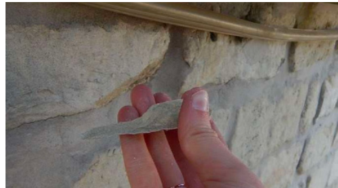
Afbeelding 192. Niet compatibel voegwerk (cementmortel). (bron: verslag Monumentenwacht, 2018, p. 15)
