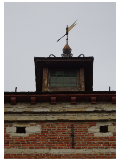
Afbeelding 53. De dakkapel aan de zuidoostzijde van het dak.
