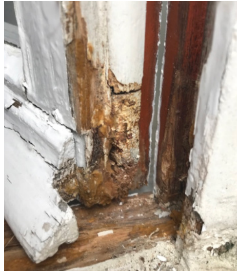
Afbeelding 240. Ingerot houtwerk.
