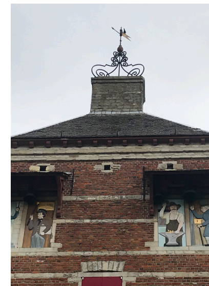
Afbeelding 52. Het dak van de Zimmertoren met centrale schoorsteen.
