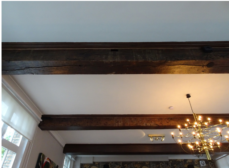
Afbeelding 141. Structuur van moerbalken zichtbaar in de verbruikszaal.
