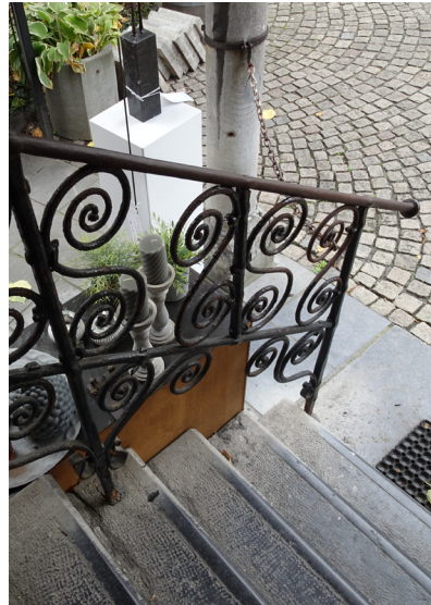
Afbeelding 67. Sierlijk uitgewerkte, smeedijzeren balustrade van de trap.
