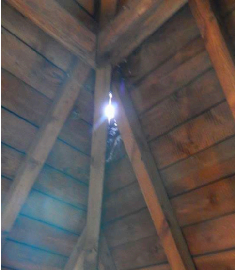
Afbeelding 179. Aangetaste dakstructuur. (bron: verslag Monumentenwacht, 2018, p. 9)
