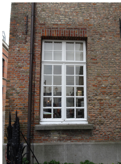
Afbeelding 128. Raam met 20-delige kleinhoutverdeling en vast bovenlicht (8-delig).
