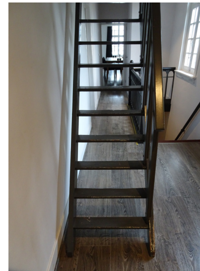
Afbeelding 147. Trap naar de zolderverdieping.
