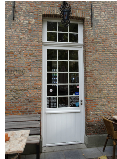
Afbeelding 123. Paneel deur (15-delig) me vast bovenlicht.
