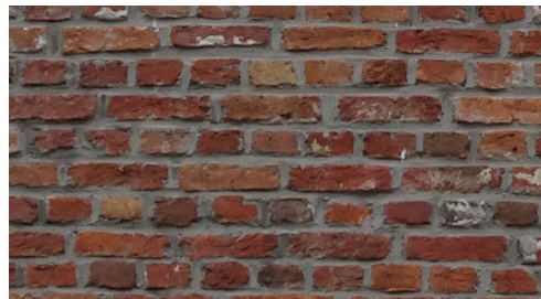
Afbeelding 188. Verweerd voegwerk van de schoorsteen. (bron: verslag Monumentenwacht, p. 10)
