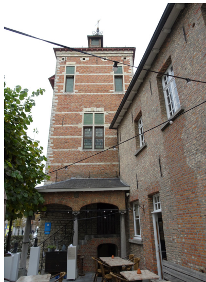
Afbeelding 64. De zuidoostgevel van de Zimmertoren met hoofdtoegang.
