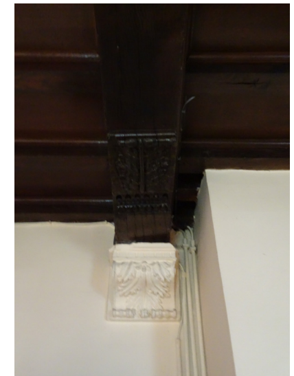
Afbeelding 89. Decoratief uitgewerkte moerbalksleutel en console.
