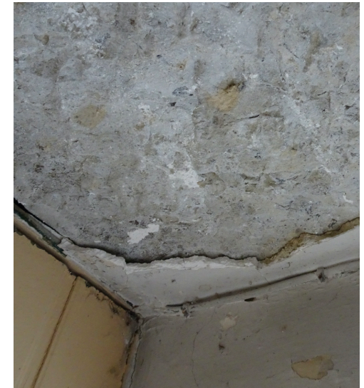
Afbeelding 202. Verweerde bepleistering.
