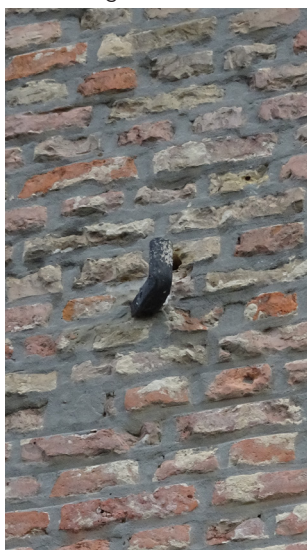
Afbeelding 126. Luikduim in de noordwestgevel.
