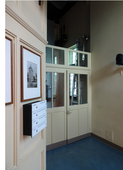
Afbeelding 98. Houten wand met glas op de tweede verdieping.
