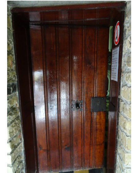
Afbeelding 69. Toegangsdeur tot de Zimmertoren.
