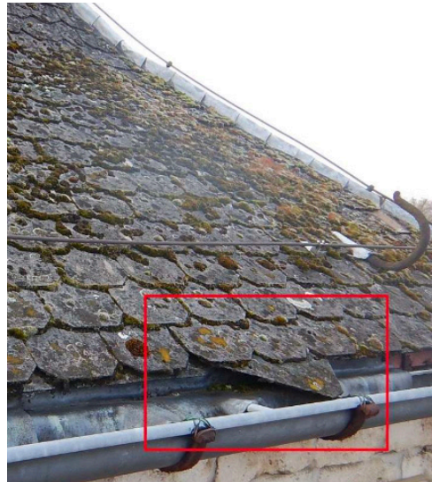
Afbeelding 184. Weggeschoven lei. (bron: verslag Monumentenwacht, 2018, p. 7)
