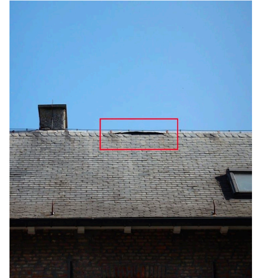
Afbeelding 222. Opgewaaid noklood. (bron: verslag Monumentenwacht, 2019, p. 10)
