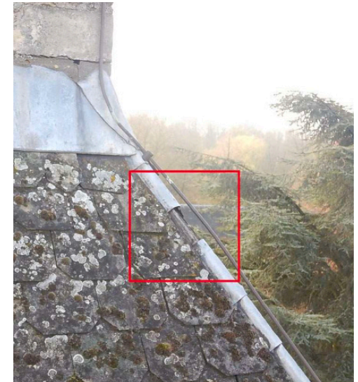
Afbeelding 186. Ontbrekend loodloket. (bron: verslag Monumentenwacht, 2018, p. 8)
