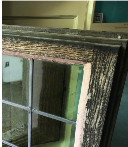
Afbeelding 208. Vervangen mastiek.
