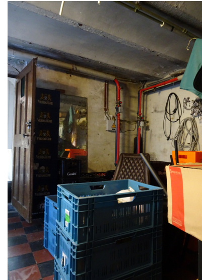
Afbeelding 109. Overzichtsfoto van de kelderverdieping.
