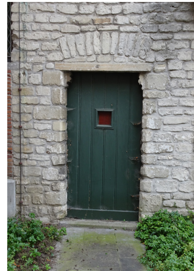
Afbeelding 62. Rechthoekige deuropening met opgeklampte deur.
