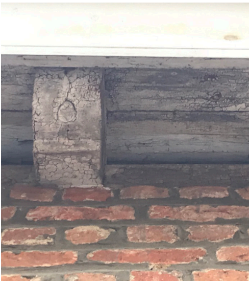
Afbeelding 191. Verschaalde bakgoot.
