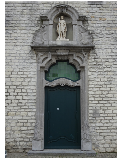
Afbeelding 57. Deur met omlijsting in rococo-stijl.
