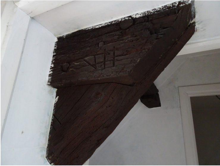
Afbeelding 149. Telmerken op de spantstructuur.
