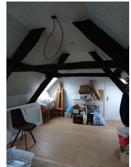
Afbeelding 148. Zolderverdieping met zichtbare spantstructuur.
