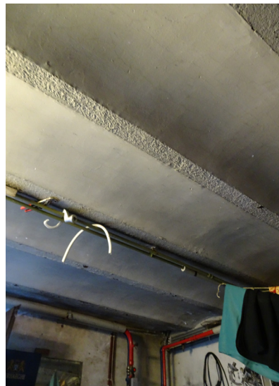
Afbeelding 112. Troggewelvenplafond op de kelderverdieping.
