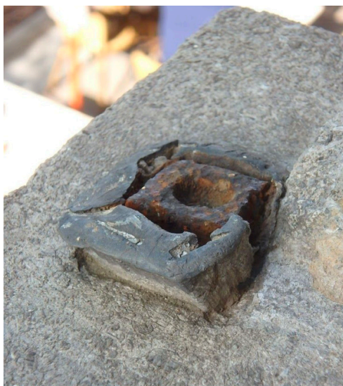
Afbeelding 237. Verroeste verankering. (bron: verslag Monumentenwacht, 2019, p. 19)
