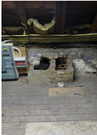
Afbeelding 153. Aanzet schouwkanaal.
