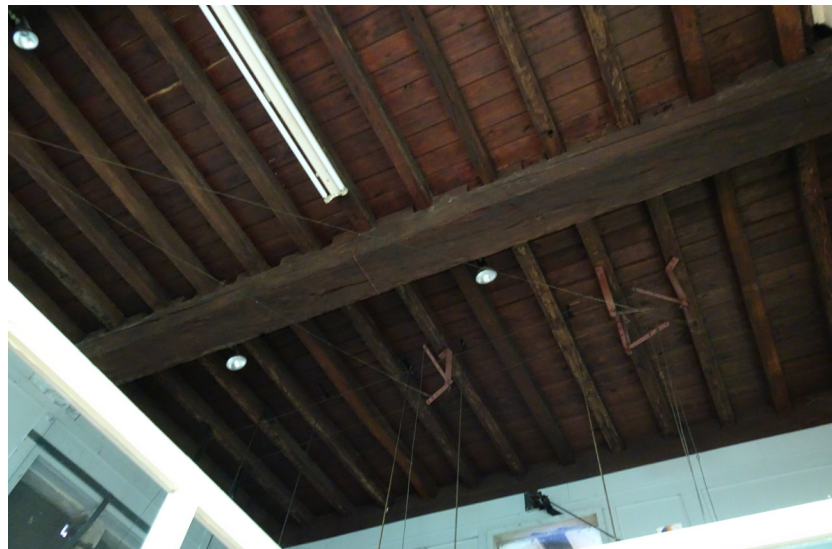
Afbeelding 107. De plafondaferwerking op de tweede verdieping.
