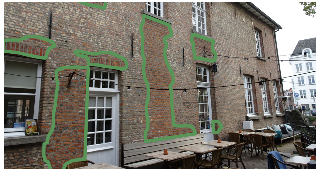
Afbeelding 269. Bouwsporen in de noordwestgevel.
