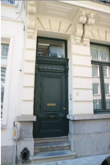
Deur met bovenlicht Sint-Gummarusstraat 7
