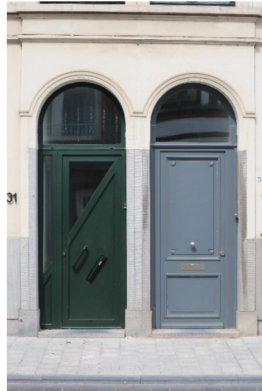
Deuren met bovenlicht. Links aangepaste deur, rechts mogelijk authentiek volgens bouwplan Sint-Gummarusstraat 31-33
