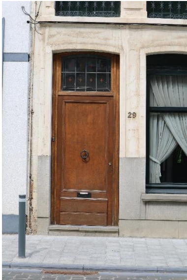
Deur met bovenlicht Sint-Gummarusstraat 29
