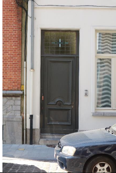
Deur met bovenlicht Sint-Gummarusstraat 5
