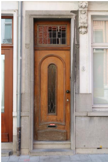
Deur met deurlicht en bovenlicht
