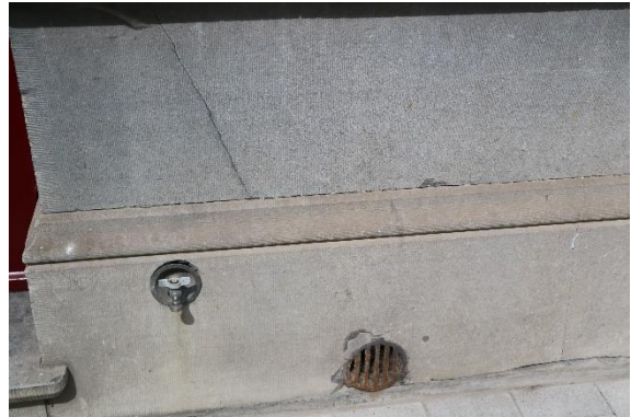
Aansluiting van waterkraan en afdichting keldergat Sint-Gummarusstraat 23
