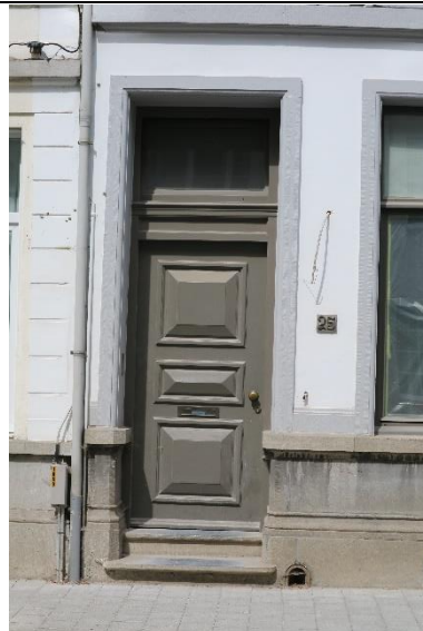
Deur met bovenlicht Sint-Gummarusstraat 25
