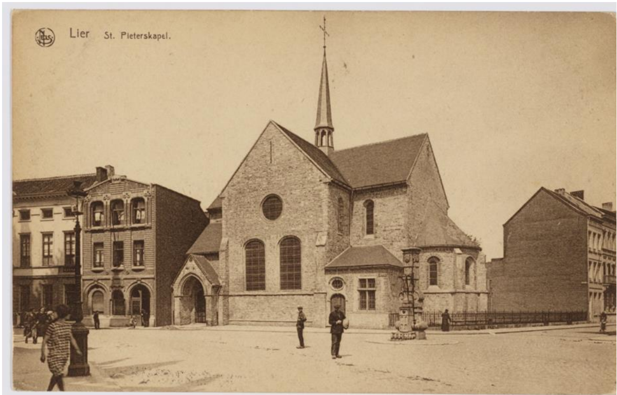
Gereneveerde Sint-Pieterkapel naar ontwerp van R. Lemaire en Sint-Gummarusstraat. Tussen 1925 en 1931, de vleugel aan de straatkant werd pas in 1931 gebouwd. Bron: SLI001002191
