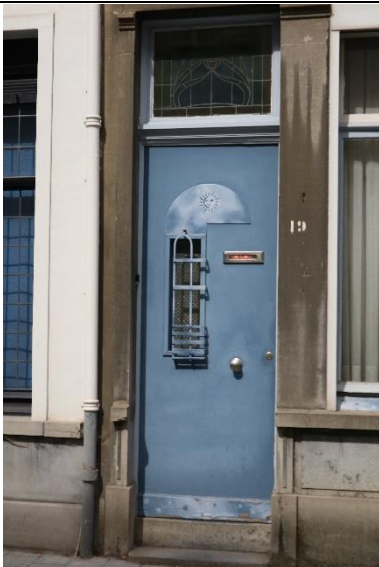
Deur met deurlicht en bovenlicht Sint-Gummarusstraat 19
