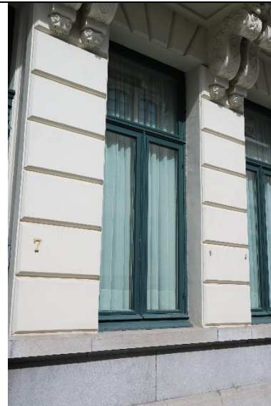
T-Ramen in rechthoekige vensteropeningen Sint-Gummarusstraat 7
