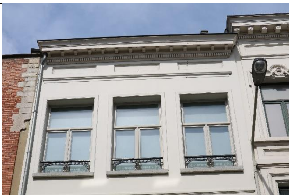
T-Ramen in rechthoekige vensteropeningen Sint-Gummarusstraat 5
