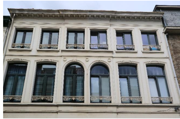
Mengeling T-ramen en tweevlakkige ramen in rechthoekige, steekbogige en rondbogige vensteropeningen Sint-Gummarusstraat 31-33
