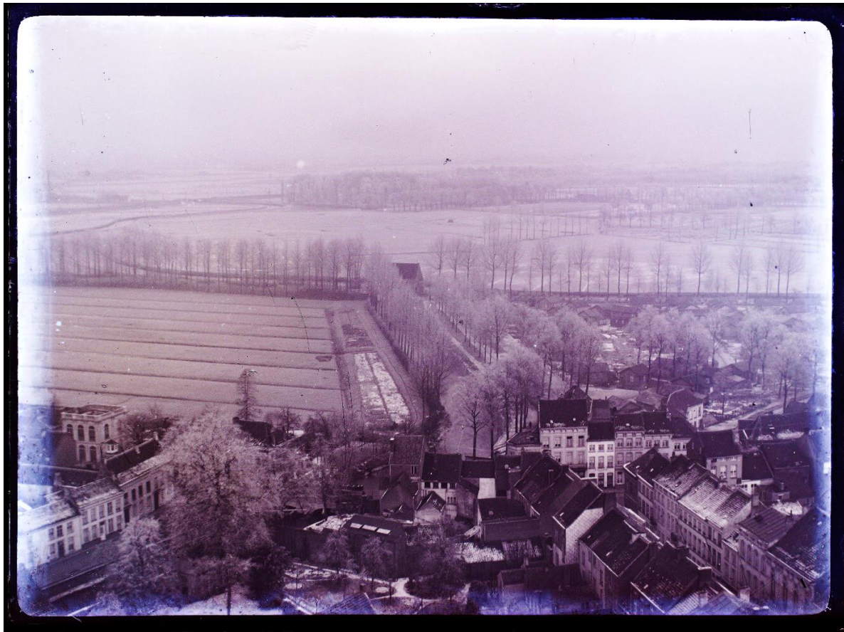
Panoramafoto richting het Spuihuis en de oever. De bedaking van de Sint-Gummarusstraat is goed zichtbaar. Datering vermoedelijk tijdens of net na WO I, aangezien er een aantal houten noodwoningen op staan op de Oever. Bron: SLI001011296
