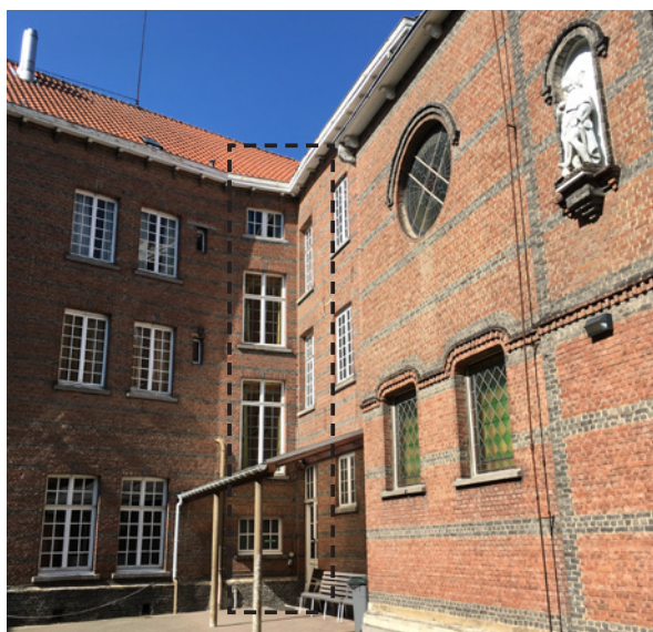
afb. 67: In de hoek van de kloostervleugels aan de tuinzijde duidt een afgeschuinde hoek met verspringende ramen op het achterliggende trappenhuis. De originele ramen werden hier vervangen (foto rechts genomen door ARAT in mei 2019). ©Archief Onroerend Erfgoed
