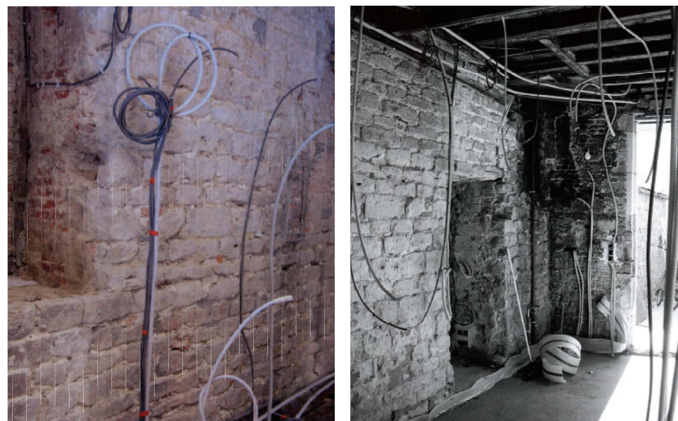
afb. 34: Tijdens de verbouwingen van woning op nummer 68 konden de originele buitenmuren worden blootgelegd. Rechts zien we een deel van de zuidgevel met één van de toegangsdeuren. ©Publicatie Open Monumentendag Het Donderhuys
