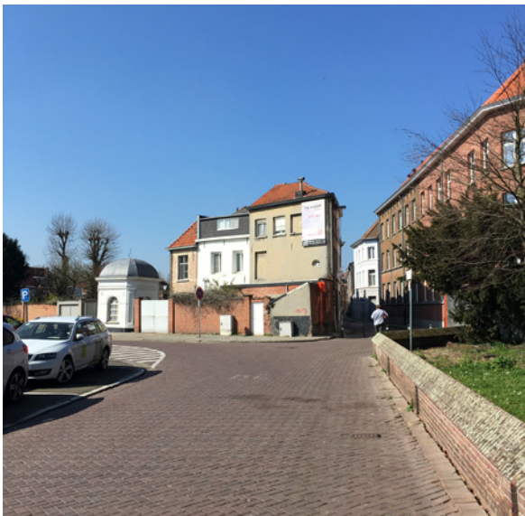
afb. 140: Zicht op de gevels zijde Gasthuisvest.
