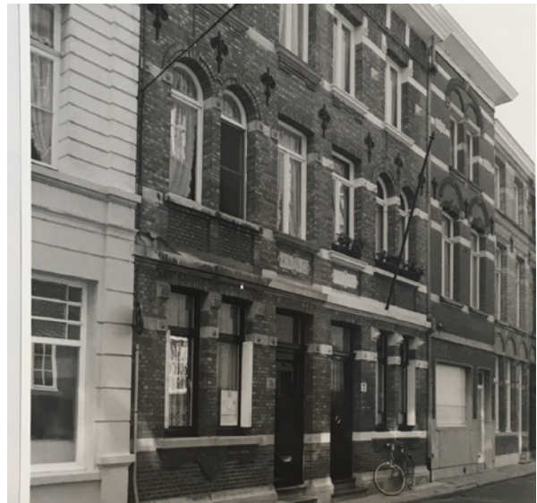
afb. 82: Foto van de voorgevels van nummers 5-7, genomen in 1987 ©Archief Agentschap Onroerend Erfgoed
