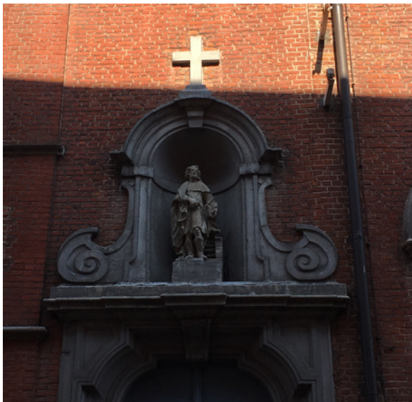
afb. 108: Beeltenis van de Heilige Alexius in de ingangstravee, patroon van de cellebroeders. Detail van het verschil in voegwerk onder en boven de waterlijst aan de straatzijde van de kapel.
