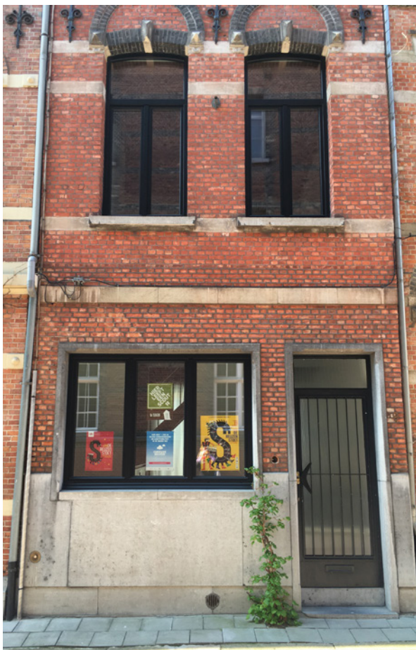
afb. 76: Aangepaste pui bij nummer 9 met harde cementvoegen en opgetrokken plint.
