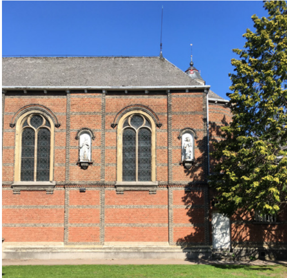
afb. 113: Zicht op de noordgelegen kapel met rechts de lage sacristie.
