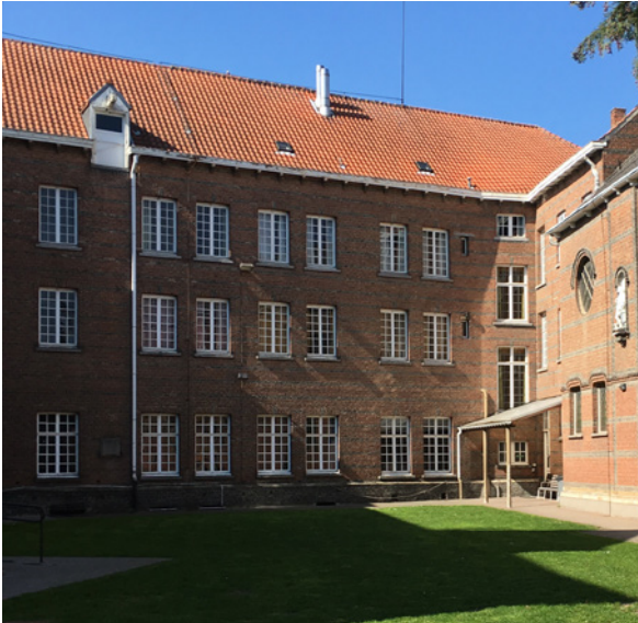
afb. 116: L-vormige tuingevel met afgesneden hoek. Aansluiting met nieuwe vleugel die midden twintigste eeuw werd aangebouwd.
