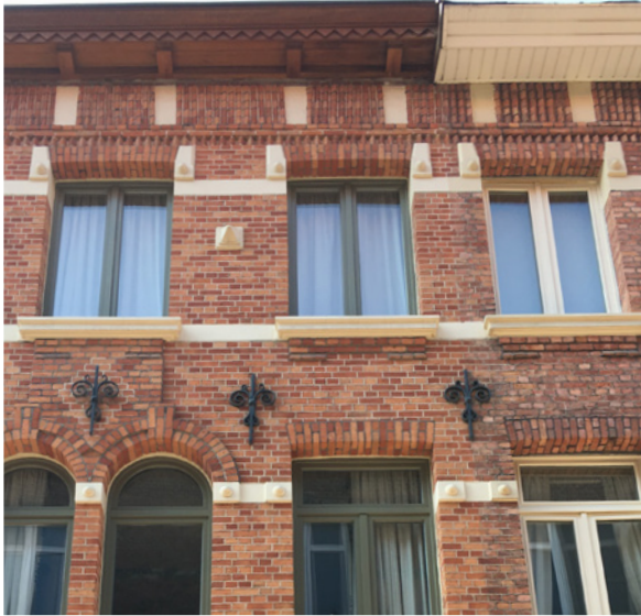
afb. 129: De lijstgevels werden rijkelijk gedecoreerd door de vele verwerkingen van het bakstenen metselwerk.
