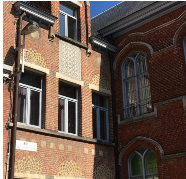
afb. 111: Bovenaan de afgesneden gevel is de lijst gedeeltelijk weggevallen. Aansluiting met de naastgelegen stadswoning.
