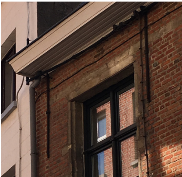
afb. 137: Sporen van een wigvormig ontlastingssysteem boven de vensters op de eerste verdieping. Achtergevel gezien vanuit de private tuin.
