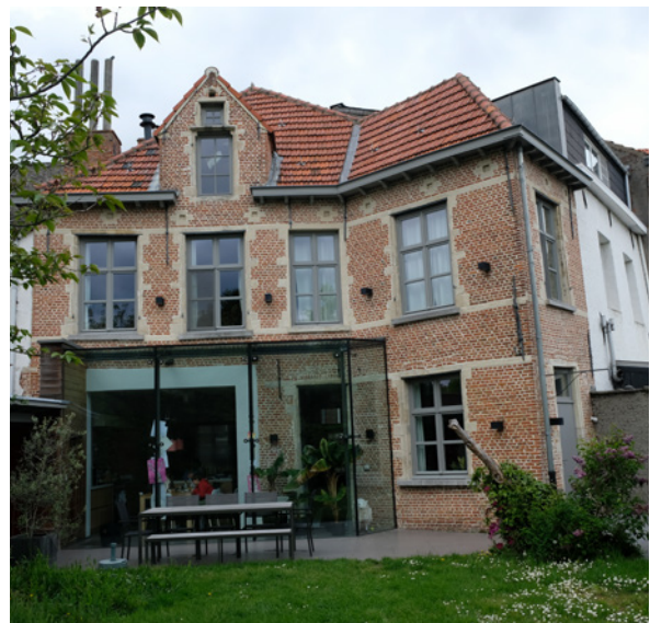
afb. 137: Sporen van een wigvormig ontlastingssysteem boven de vensters op de eerste verdieping. Achtergevel gezien vanuit de private tuin.
