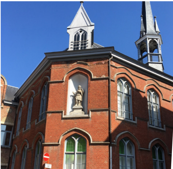
afb. 111: Bovenaan de afgesneden gevel is de lijst gedeeltelijk weggevallen. Aansluiting met de naastgelegen stadswoning.
