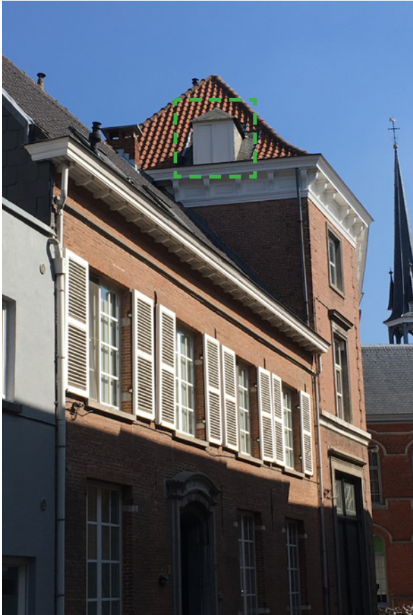
afb. 148: De dakkapel met leibedekking in de zijgevel van De Posthoorn. Rechts de verspringende arduinen plint bij nr. 9.
