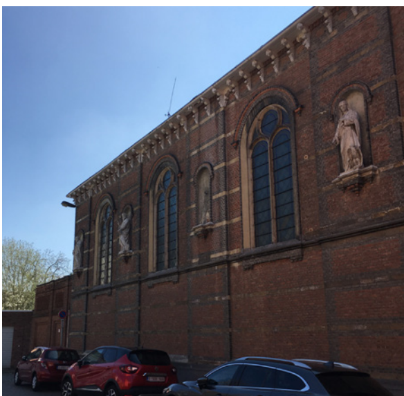
afb. 115: Zicht op de straatgevel van de kapel met tuinmuur.
