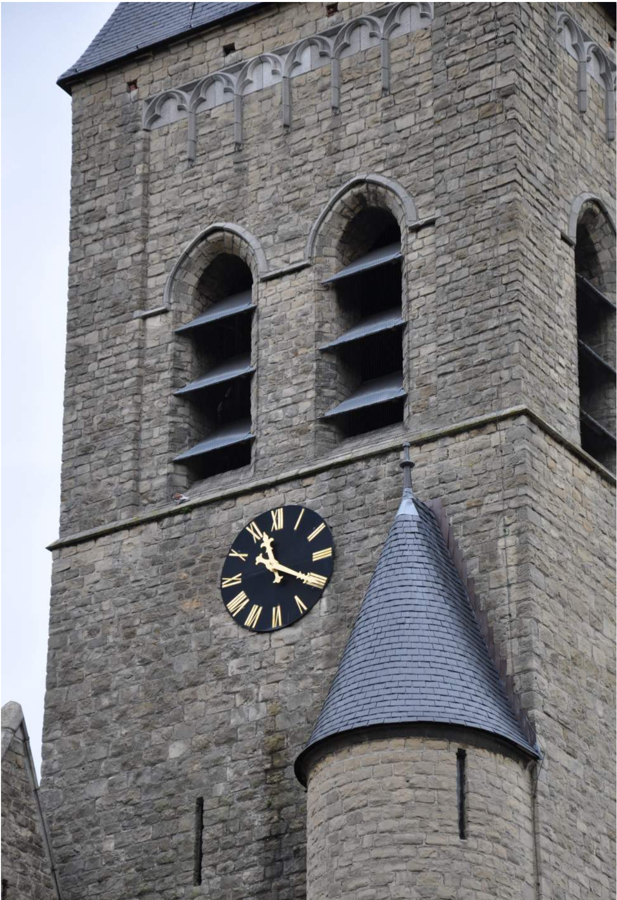
Afb. 40. De galamberden in de toren.
