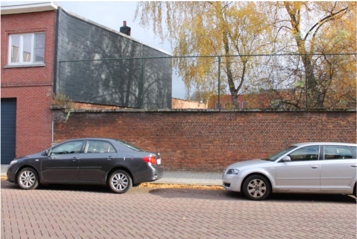
Afb. 84. De bastenen tuinmuur met natuurstenen dekstenen.
