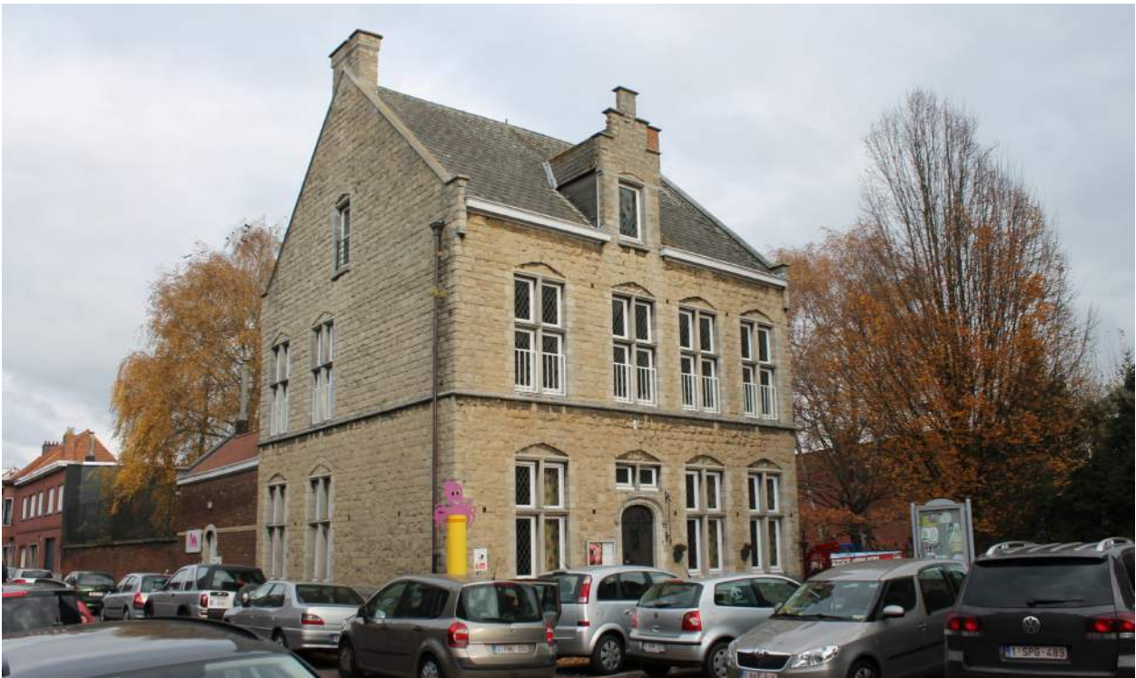
Afb. 86. De vanaf de straat zichtbare gevels van de pastorie.
