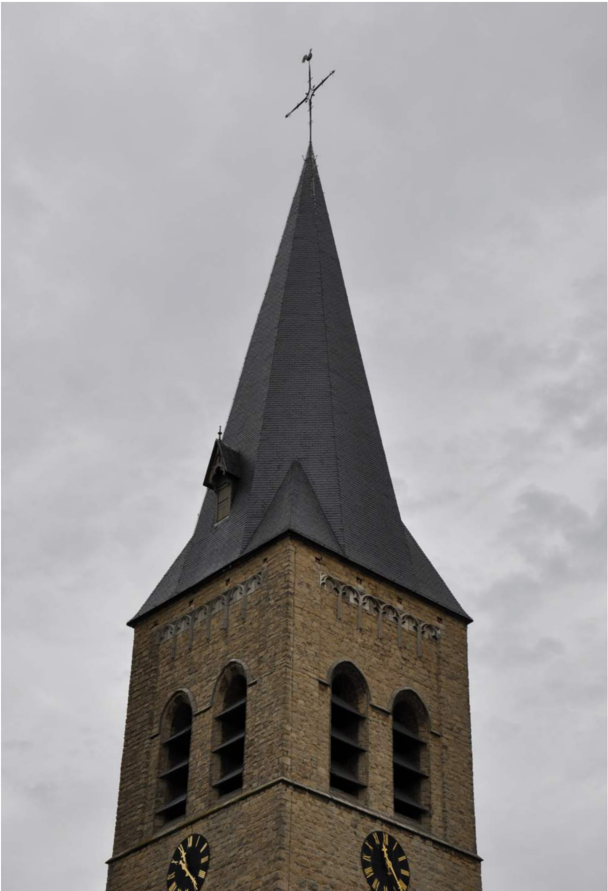
Afb. 26. Het dak van de toren.
