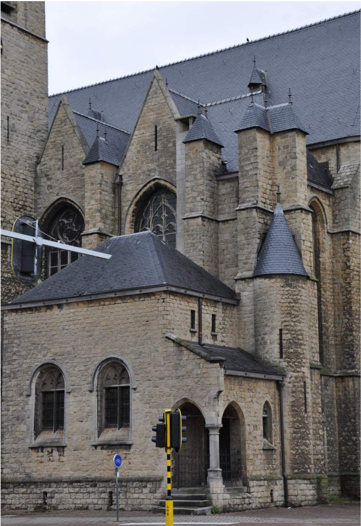
Afb. 36. Het dak van de sacristie.
