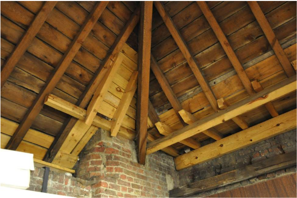
Afb. 77. De dakstructuur van de zolder boven de sacristie.
