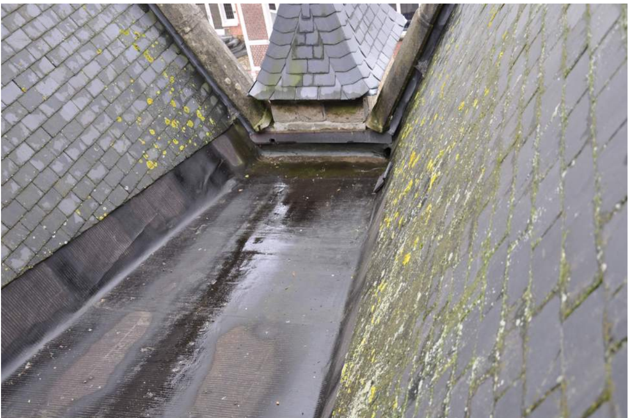
Afb. 31. Een van de daken van de zijbeuk.
