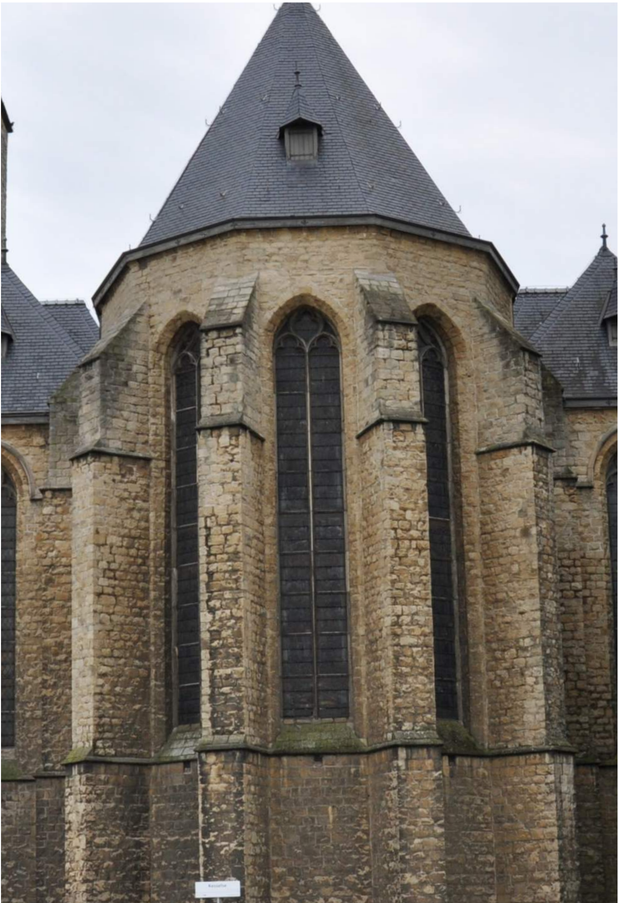
Afb. 42. Het buitenschrijnwerk in het koor: de spitsboogvensters, dakkapellen en boordplanken aan de dakgoten.
