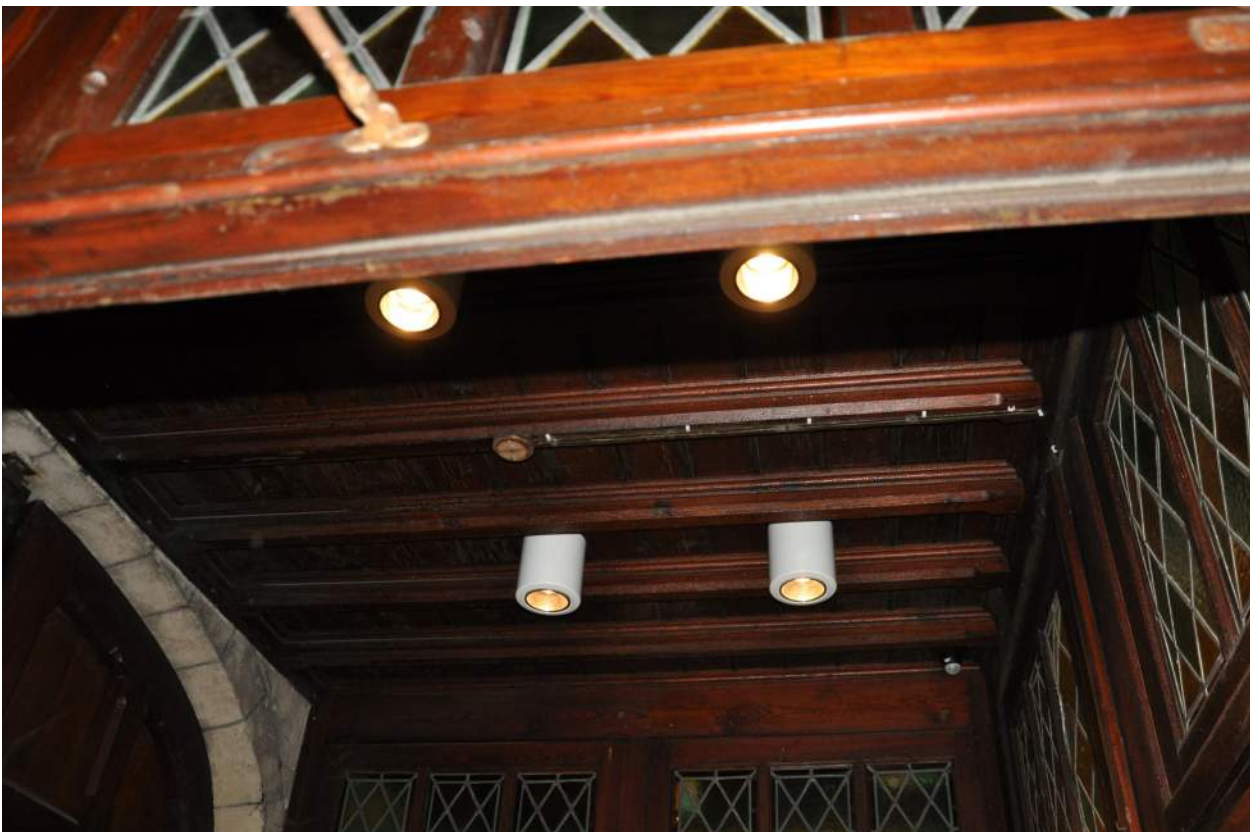
Afb. 49. Het plafond van het houten tochtportaal.
