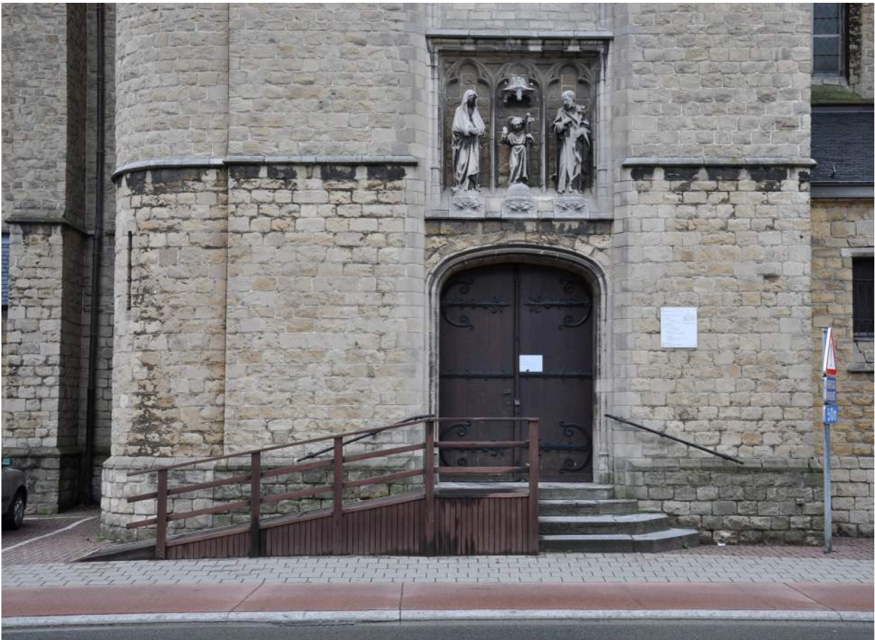
Afb. 38. De zuidelijke toegangspoort in de onderste geleding van de toren.
