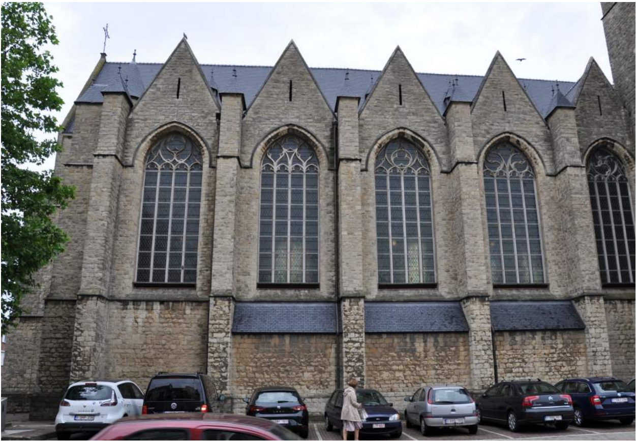
Afb. 16. De haaks gepositioneerde zijkapellen, aan de zuidzijde van het schip.
