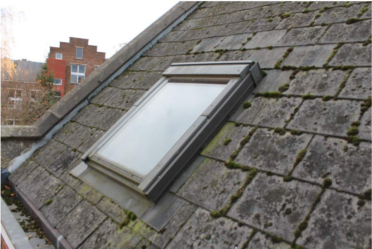
Afb. 88. Grijs vezelcementleien bedekken het dak van de hoofdbouw.
