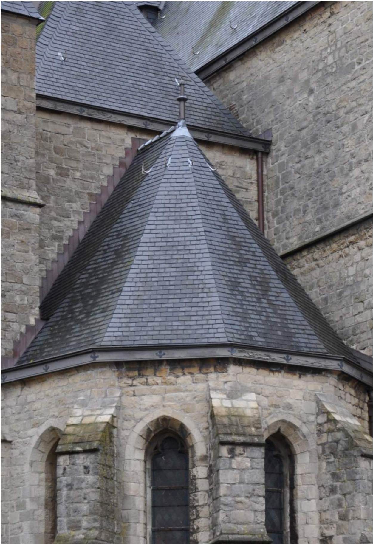
Afb. 35. Het dak van de doopkapel.
