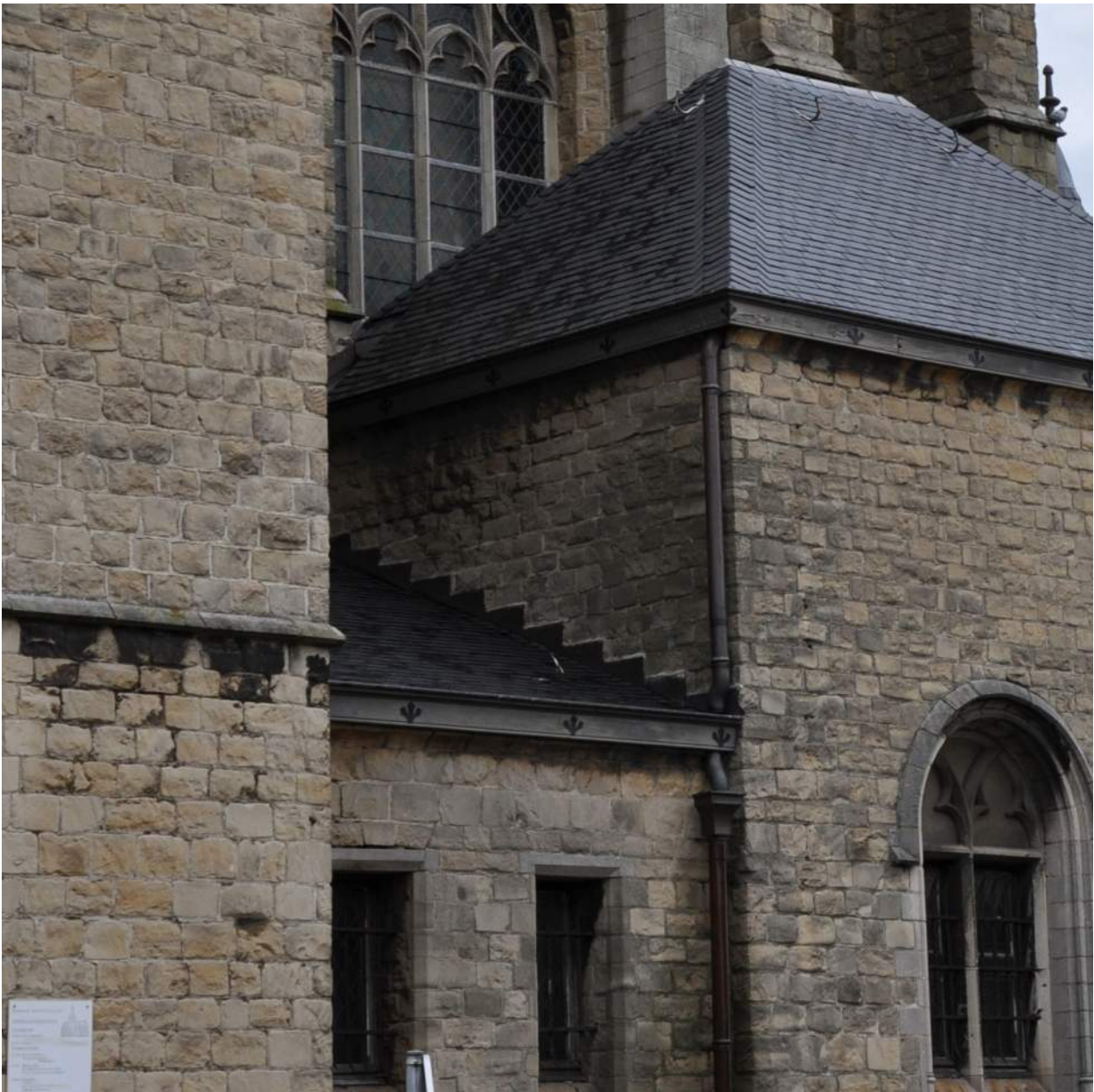
Afb. 37. Het dak van de berging naast de sacristie.
