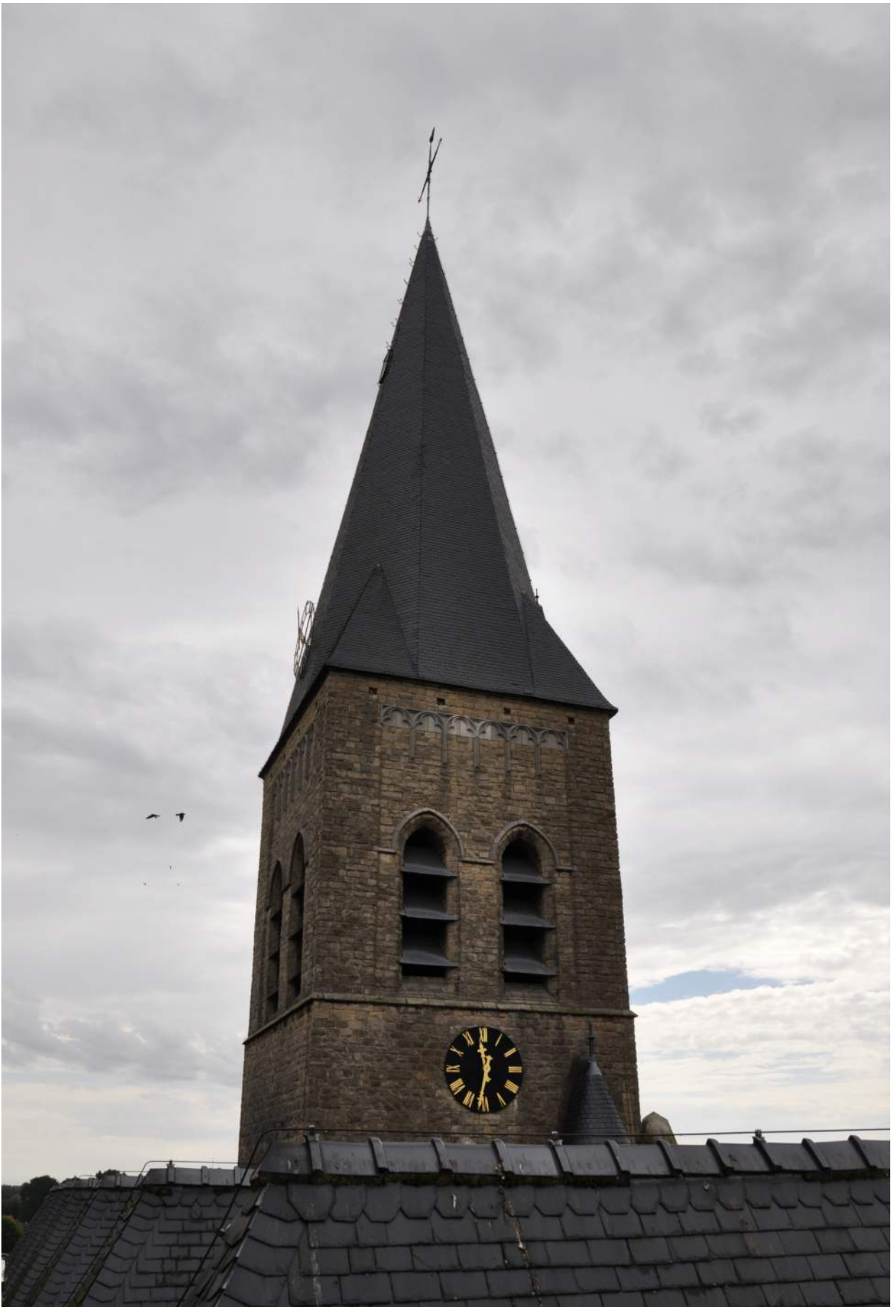
Afb. 15. De westzijde van de toren.
