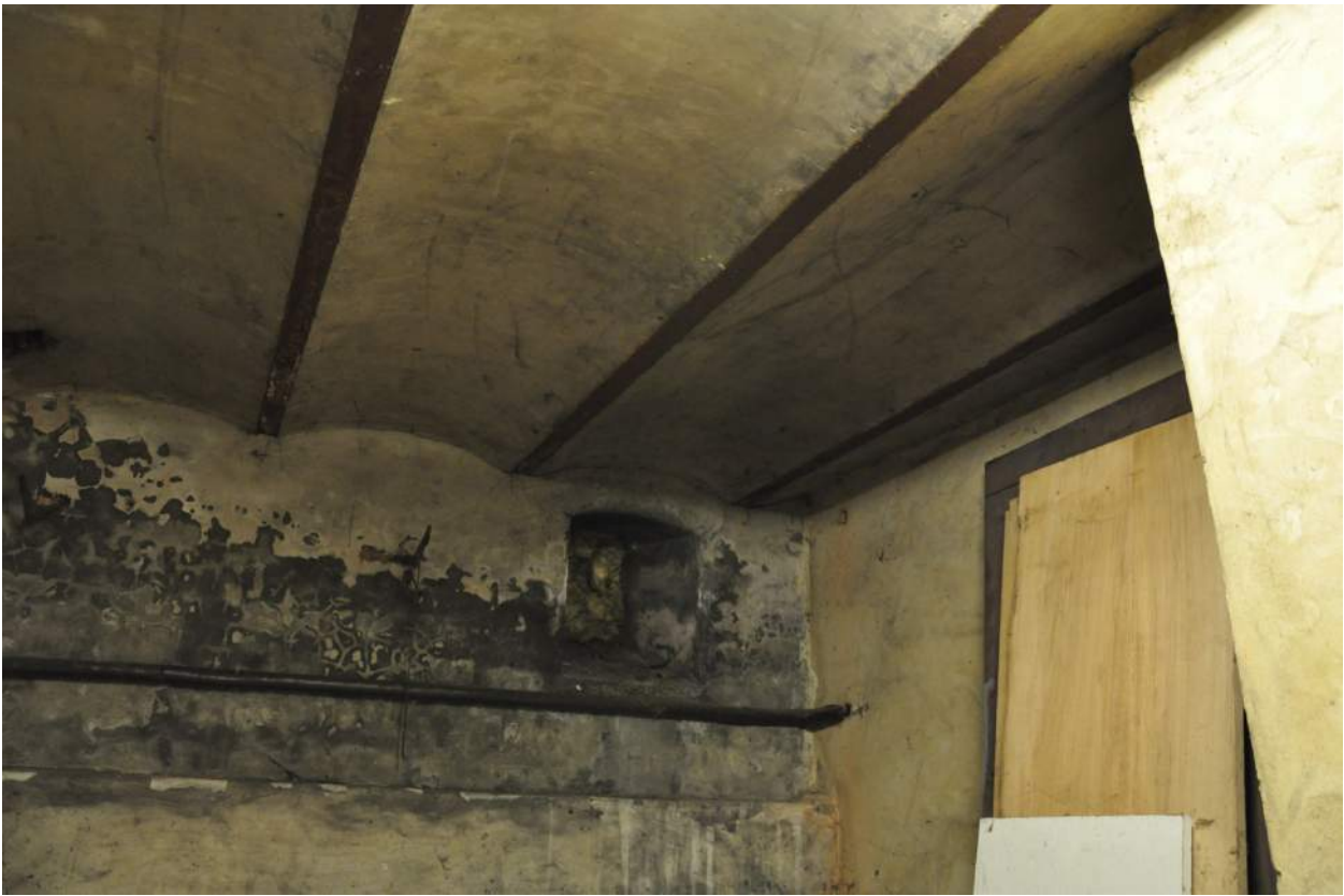
Afb. 45. Troggewelven in de kelder van de sacristie
