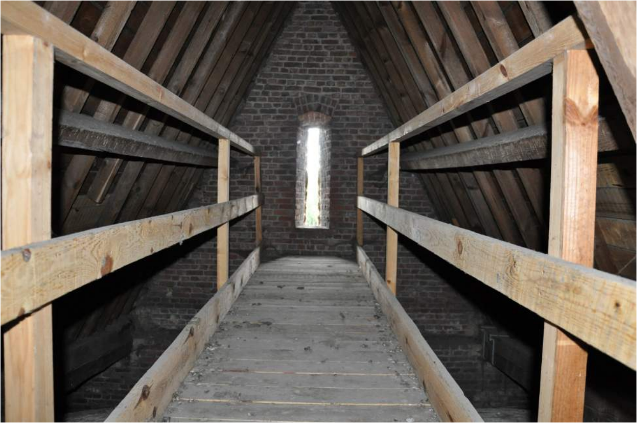
Afb. 76. Een van de zolders boven de zijbeuken.
