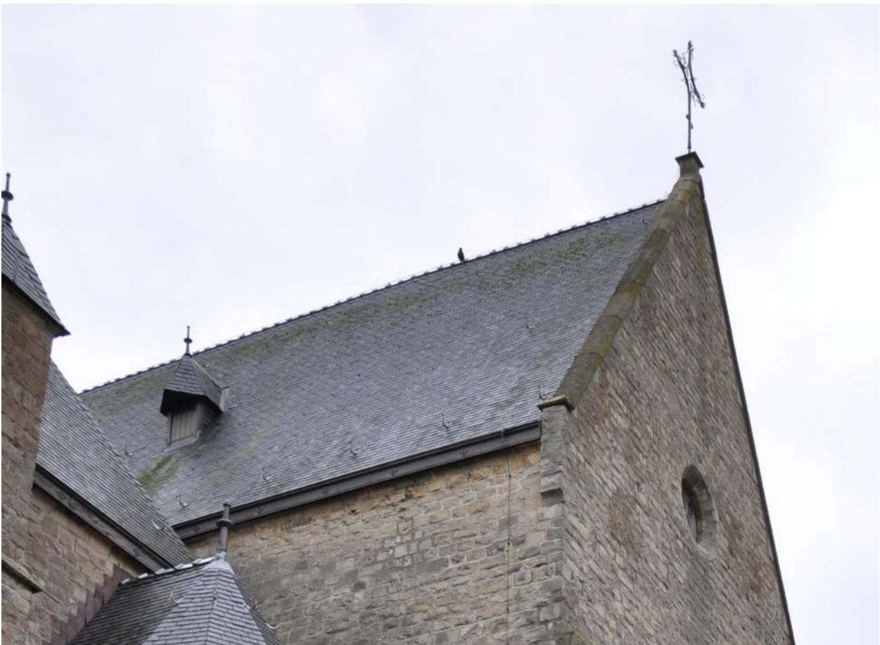
Afb. 27. Het noordelijke dakvlak van het schip.
