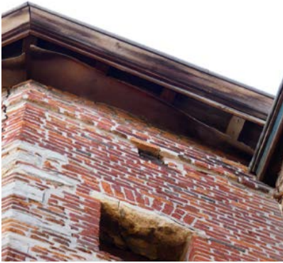
TYPISCHE SCHADEBEELD REGENWATERAFVOEREN ACHTERGEVEL VAN GEBOUW A
