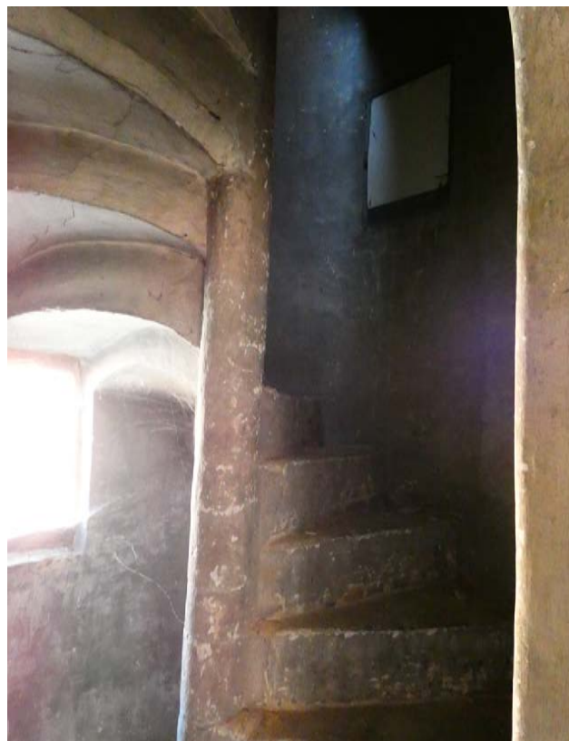
STENEN SPILTRAP 15DE EEUWSE TRAPTOREN_BRON: KARUURARCHITECTEN
