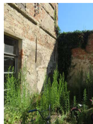
BOUWSPOR VAN EEN LESSENAARSDAK DOORHEEN EÉN VAN DE KRUISVENSTERS VAN DE ACHTERBOUW - BRON: KARUUR ARCHITECTEN
