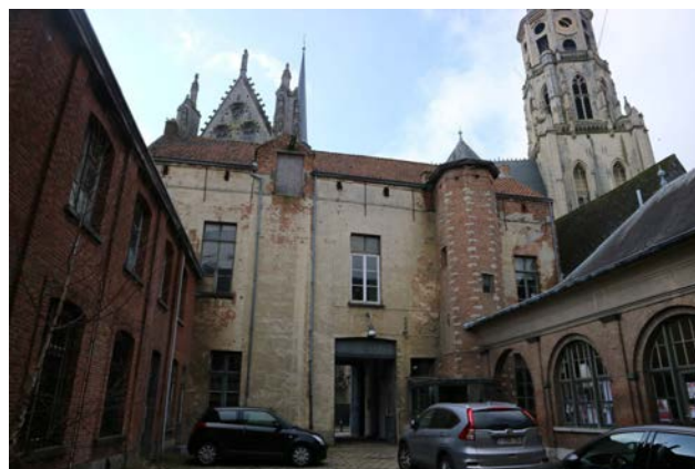
ZICHT OP DE ACHTERGEVEL VAN DE VOORBOUW VANOP DE EERSTE BINNENPLAATS_BRON: BEELDBANK.ONROERENDERFGOED.BE
