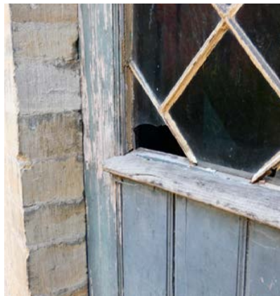
TYPISCHE SCHADEBEELD HOUTEN SCHRIJNWERK ACHTERGEVEL VAN GEBOUW A
