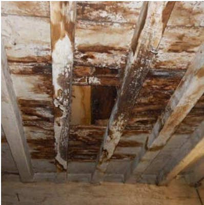
TYPISCH SCHADEBEELD HOUTEN VLOERSTRUCTUREN GEBOUW C_BRON; MONUMENTENWACHT INSPECTIERAPPORT 2019
