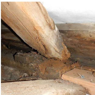
TYPISCH SCHADEBEELD AAN KAPCONSTRUCTIE GEBOUW C _ BRON; MONUMENTENWACHT INSPECTIERAPPORT 2019
