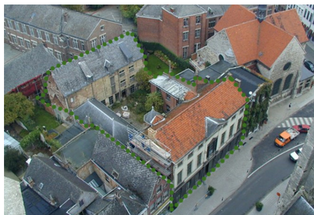
LUCHTFOTO VAN DE SITE _ BRON: STAD LIER
