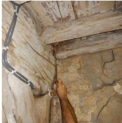
TYPISCH SCHADEBEELD HOUTEN VLOERSTRUCTUREN GEBOUW C_BRON; MONUMENTENWACHT INSPECTIERAPPORT 2019
