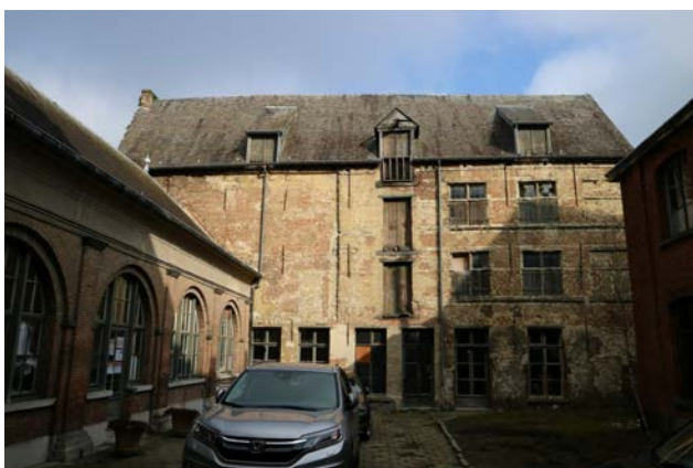
ZICHT VANOP DE EERSTE BINNENPLAATS OP DE VOORGEVEL VAN DE ACHTERBOUW_BRON: BEELDBANK.ONROERENDERFGOED.BE
