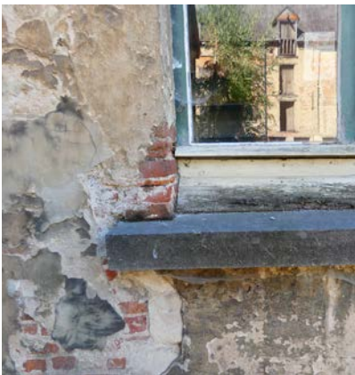
TYPISCHE SCHADEBEELD BAKSTEEN EN NATUURSTEEN ACHTERGEVEL VAN GEBOUW A
