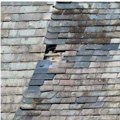
TYPISCH SCHADEBEELD LEIEN DAKBEDEKKING GEBOUW C
