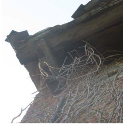
TYPISCH SCHADEBEELD DAKOVERSTEEK ACHTERGEVEL GEBOUW C
