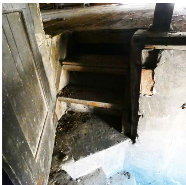
DRIE HOUTEN TREDEN OM HET NIEUWE NIVEAUVERSCHIL MET DE ORIGINELE TRAP TE KUNNEN OVERBRUGGEN_BRON: KARUUR ARCHITECTEN
