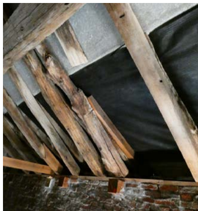
TYPISCHE SCHADEBEELD REGENWATERAFVOEREN ACHTERGEVEL VAN GEBOUW A
