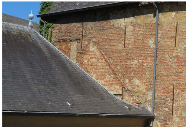
OP DE ZUIDGEVEL VAN DE ACHTERBOUW VINDEN WE SPOREN TERUG VAN EEN DAK MET HETZELFDE VERLOOP EN HELLING ALS HET ORIGINELE DAK UIT 1803_BRON: KARUURARCHITECTEN
