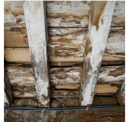
TYPISCH SCHADEBEELD HOUTEN VLOERSTRUCTUREN GEBOUW C_BRON; MONUMENTENWACHT INSPECTIERAPPORT 2019
