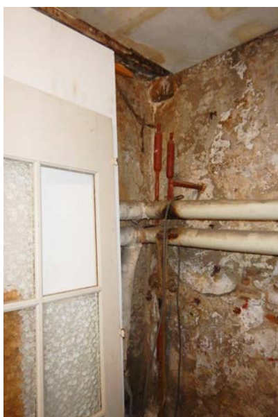
OVERZICHT VAN ASBESTHOUDENDE MATERIALEN OP DE H.GEESTSITE
