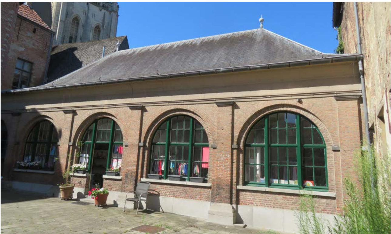
BINNENPLAATSGEVEL VAN GEBOUW B
