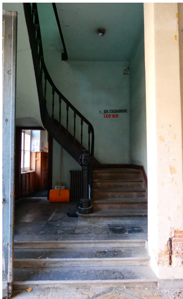
FOTO VAN DE NOG ORIGINELE 19DE EEUWSE TRAP VAN DE VOORBOUW. BRON: KARUUR ARCHITECTEN
