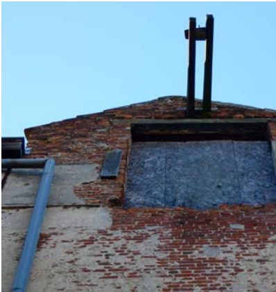
TYPISCHE SCHADEBEELD HOUTEN EN IJZEREN ONDERDELEN ACHTERGEVEL VAN GEBOUW A
