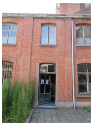
AANWEZIGHEID VAN NOG ORIGINELE PIJLERS VAN DE INITIËLE OOSTVLEUGEL - BRON: KARUUR ARCHITECTEN
