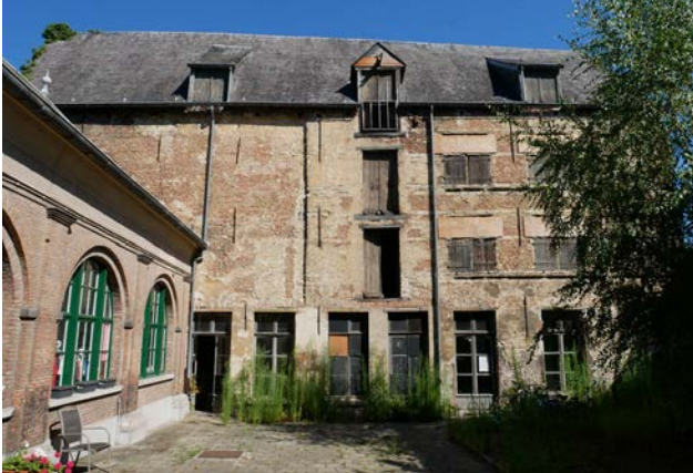
BIJDEBINNENPLAATSGEVEL VAN DE ACHTERBOUW BLEVEN VERSCHILLENDE 17DE EEUWSE ELEMENTEN BEWAARD_BRON: KARUURARCHITECTEN
