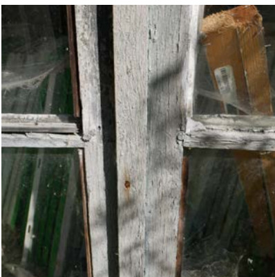
TYPISCH SCHADEBEELD SCHRIJNWERK GEBOUW C
