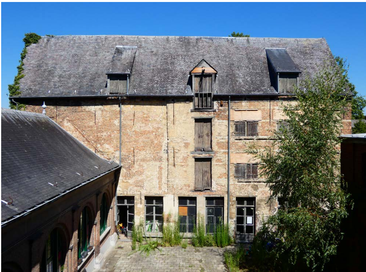
BINNENPLAATSGEVEL VAN GEBOUW C
