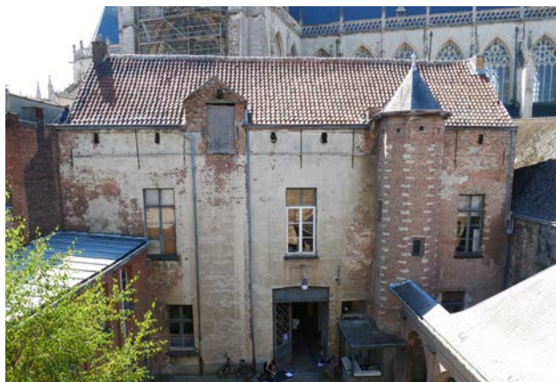
ACHTERGEVEL VOORBOUW MET BOVENAAN UITSTEKENDE BAKSTENEN LIJST DIE VERWIJST NAAR 15DE EEUWSE BOUWHOOGTE_BRON: KARUURARCHITECTEN
