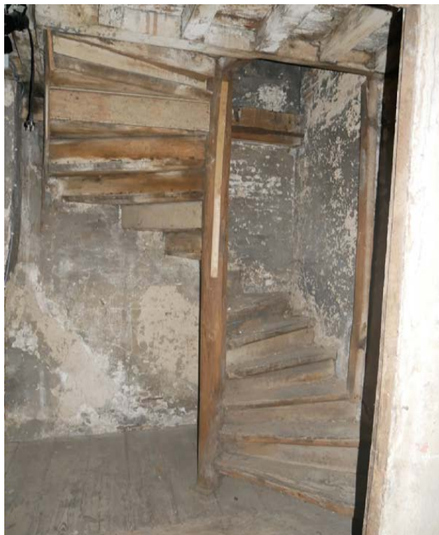
17DE EEUWSE SPILTRAP TUSSEN TWEDE VERDIEPING EN ZOLDER VAN DE ACHTERBOUW_BRON: KARUURARCHITECTEN
