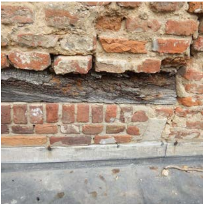
TYPISCH SCHADEBEELD HOUTEN- EN IJZEREN ONDERDELEN GEBOUW C_BRON; MONUMENTENWACHT INSPECTIERAPPORT 2019
