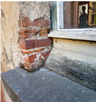
TYPISCHE SCHADEBEELD HOUTEN SCHRIJNWERK ACHTERGEVEL VAN GEBOUW A
