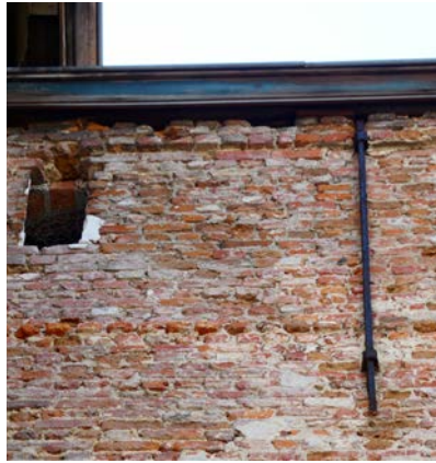
TYPISCHE SCHADEBEELD REGENWATERAFVOEREN ACHTERGEVEL VAN GEBOUW A
