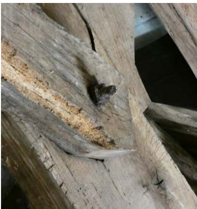
TYPISCHE SCHADEBEELD KAPCONSTRUCTIE GEBOUW A
