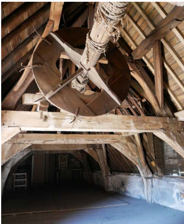
ORIGINELE HIJSRAD OP DE ZOLDER VAN DE ACHTERBOUW_BRON: KARUURARCHITECTEN
