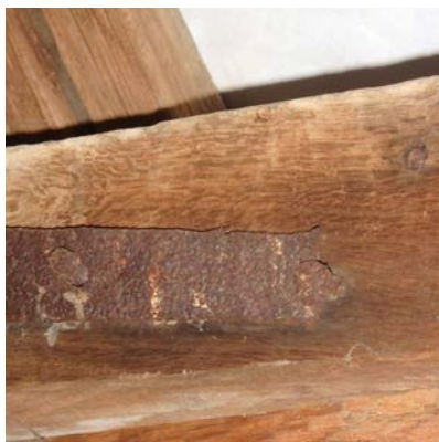
TYPISCH SCHADEBEELD AAN KAPCONSTRUCTIE GEBOUW C _ BRON; MONUMENTENWACHT INSPECTIERAPPORT 2019
