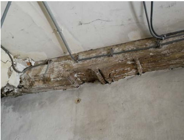
BALKSLEUTEL MET DATUM 1608 IN HET LINKERDEEL VAN HET HUIDIGE ACHTERBOUW_BRON: KARUURARCHITECTEN
