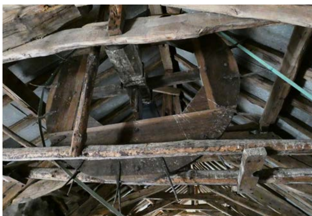
NOG ORIGINEEL 15DE EEUWS HIJSRAD OP ZOLDER BEWAARD_BRON: KARUURARCHITECTEN
