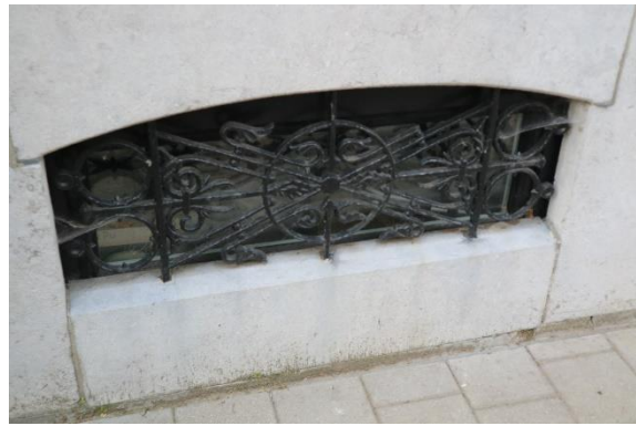
Kelderrooster De Heyderstraat 18
