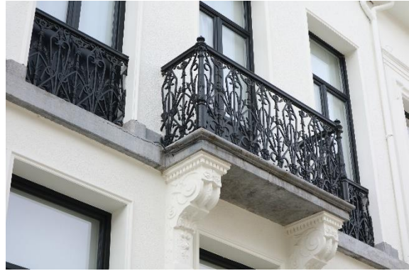
Balustrade De Heyderstraat 18
