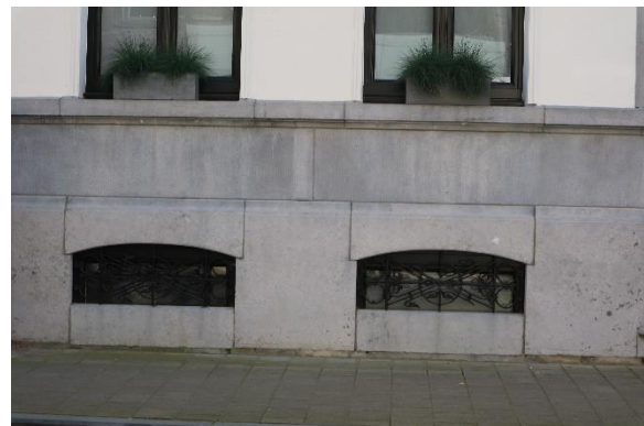
Detail van verhoogde hardstenen sokkel bij nummer 18
