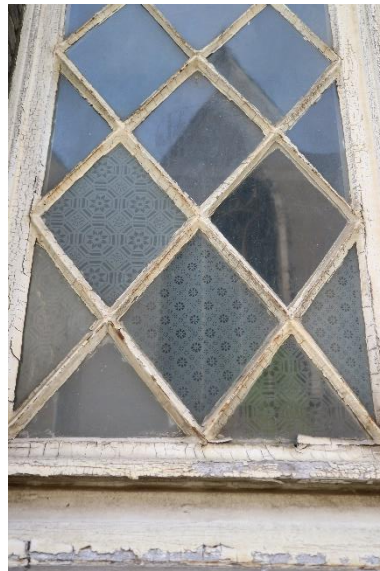
Detail van het glaswerk
