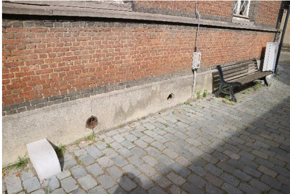
Het predikherenklooster met hardstenen plint en keldergaten
