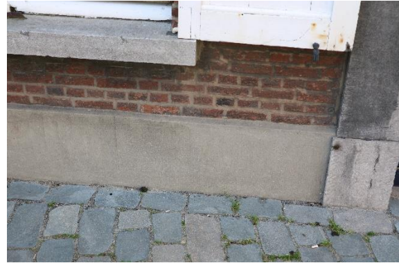
Hardstenen sokkel bij de pastorie.
