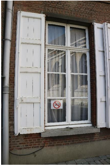
Ramen van de pastorij onderste bouwlaag
