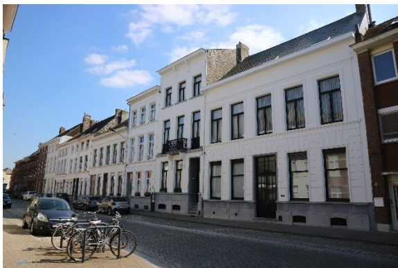
Zicht op de doorlopende verhoogde hardstenen sokkels in de De Heyderstraat
