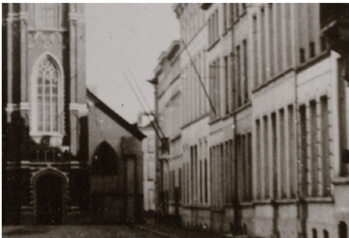
De woningen op nummers 38-42 zijn nog niet verbouwd. Eén van de woningen heeft een balkon. Bron: SLI001000441. Auteur: Bernard Janssens
