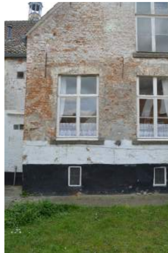
Fig.02. Achtergevel met houten schrijnwerk
