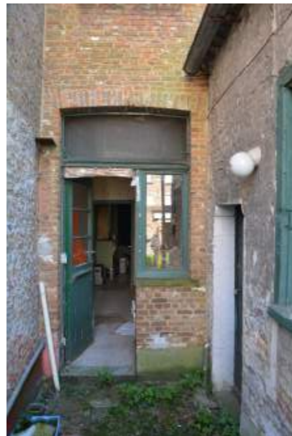
Fig.06. Zicht achtergevel met aanbouw
