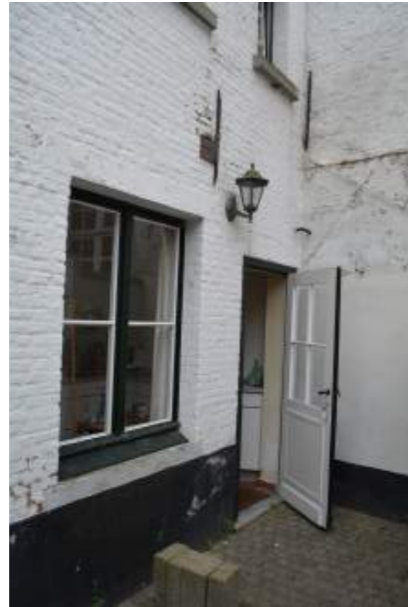
Fig.09. Zijgevel aan binnenkoer
