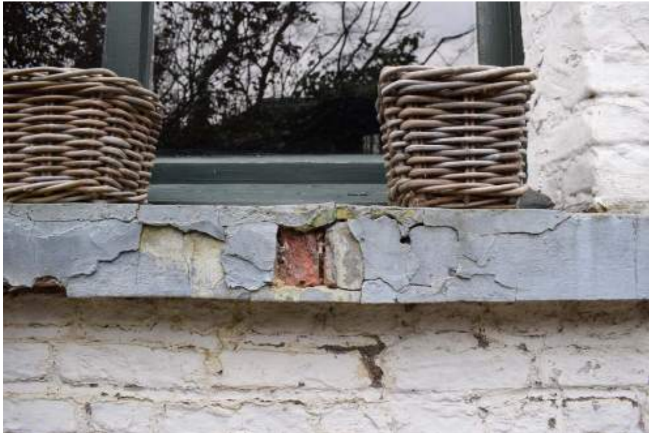
Fig.06. Detail aanbouw: raamdorpel in baksteen en pleisterwerk
