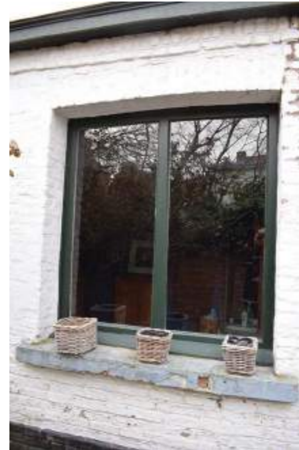
Fig.07. Detail aanbouw: schrijnwerk in hout
