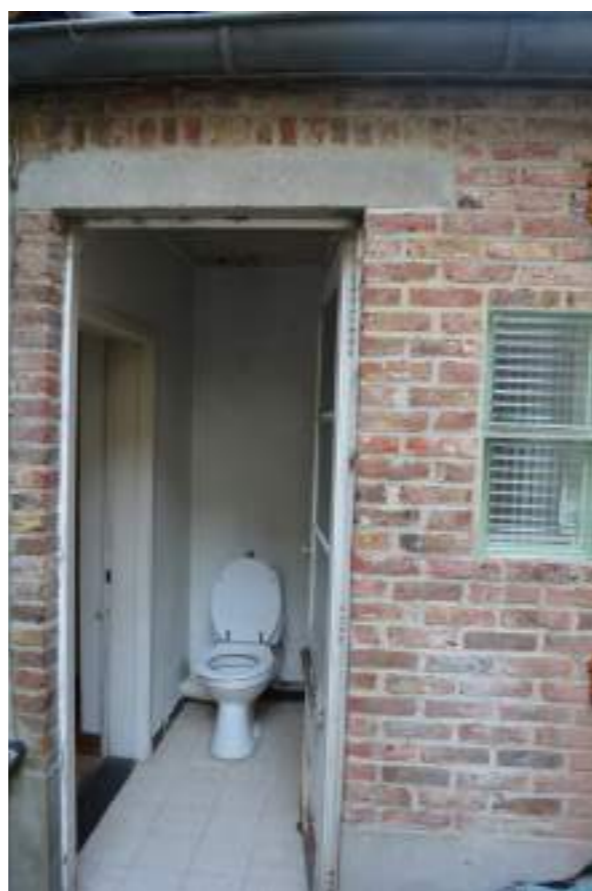
Fig.04. Aanbouw in metselwerk
