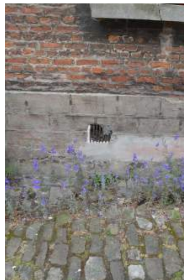
Fig.04. Gecementeerde plint met ventilatie-rooster
