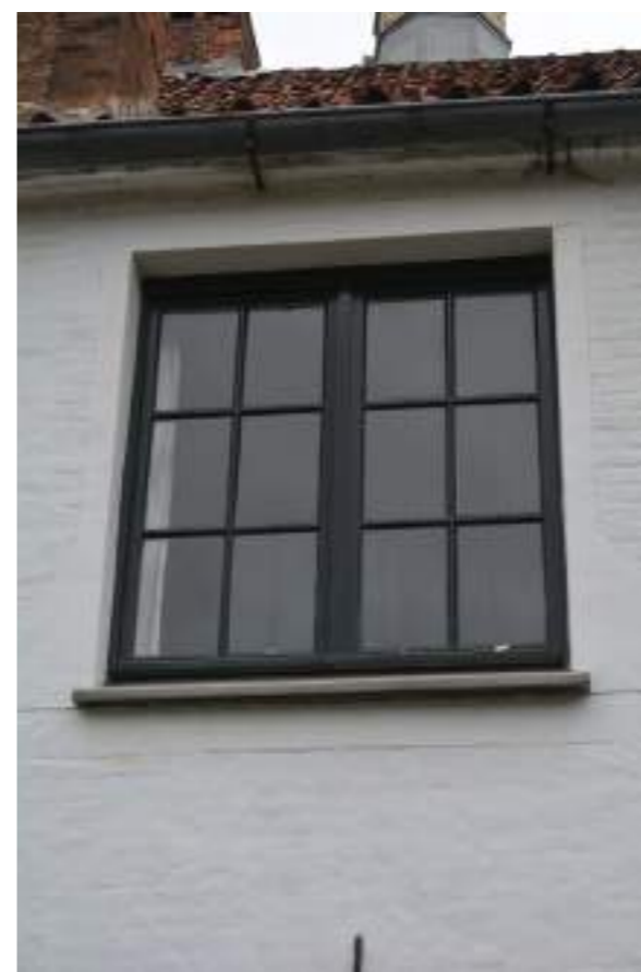
Fig.03. Detail raam eerste verdieping achtergevel
