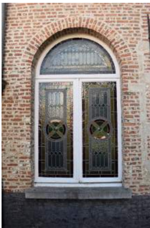
Fig.04. Zijgevel met houten schrijnwerk
