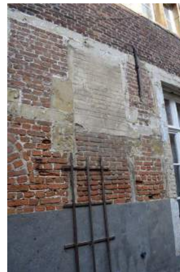
Fig.05. Detail gevelmetselwerk en gesloten raamopening
