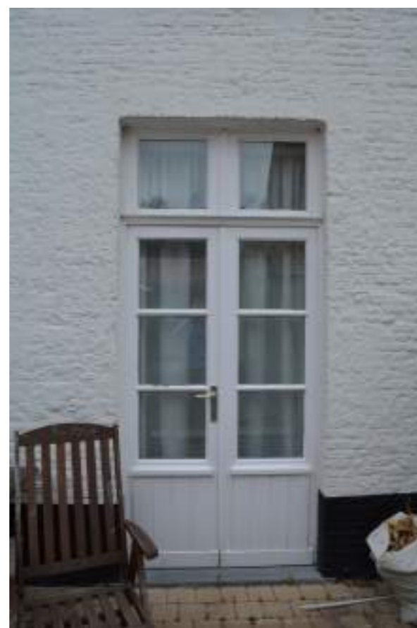
Fig.09. Detail houten schrijnwerk in achtergevel
