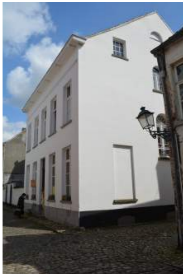
Fig.01. Voorgevel en zijgevel aan de Bodegemstraat
