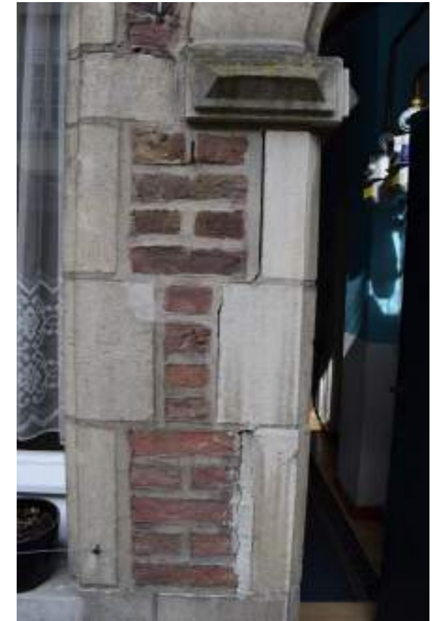
Fig.04. Detail metselwerk voorgevel
