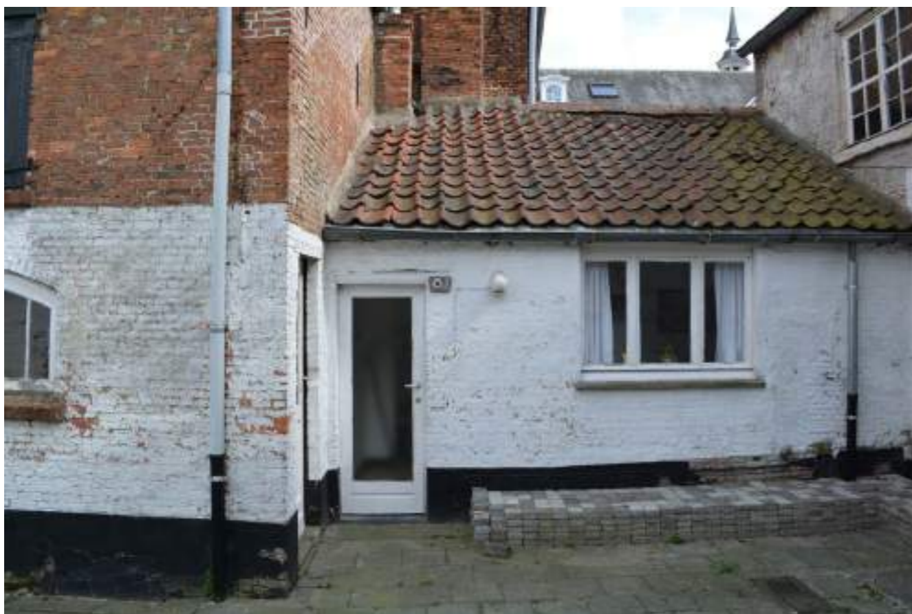
Fig. 09. Bijgebouw met houten schrijnwerk
