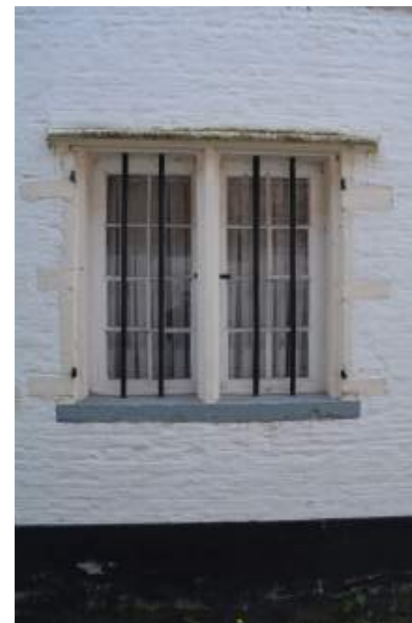
Fig.06. Detail houten schrijnwerk
