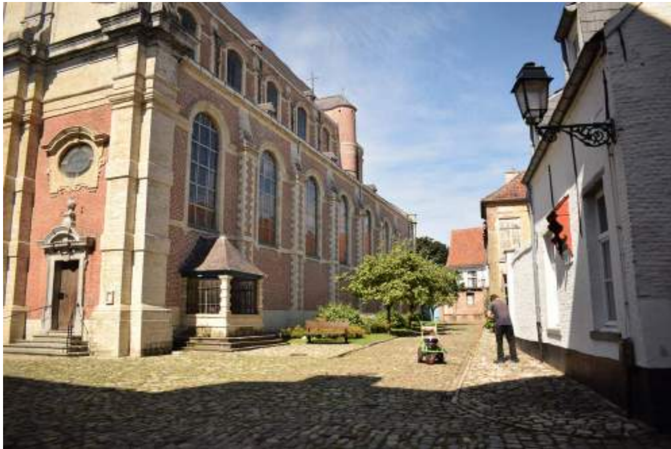
Fig.07. Zicht zijgevel vanuit kapel Infirmierie
