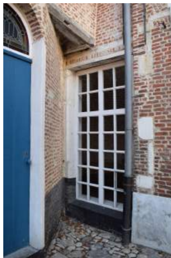
Fig.05. Houten schrijnwerk in voorgevel
