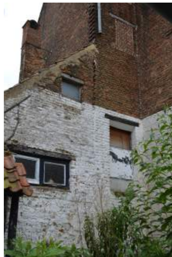
Fig.09. Zicht op zijgevel achterbouw vanuit koer OK03
