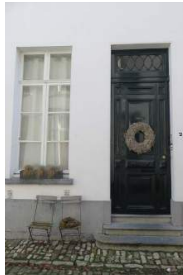
Fig.02. Voorgevel met houten voordeur
