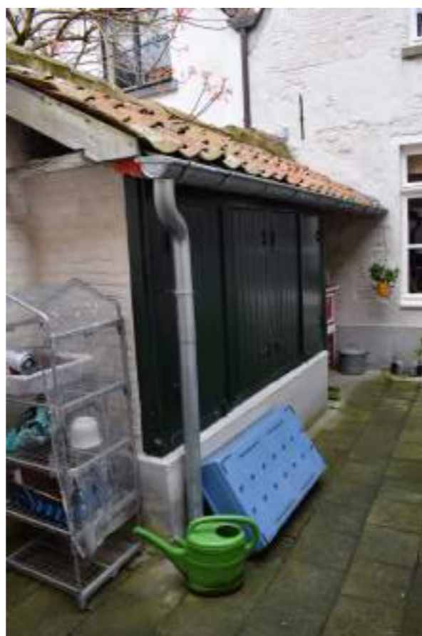
Fig.04. Aanbouw met pannendak
