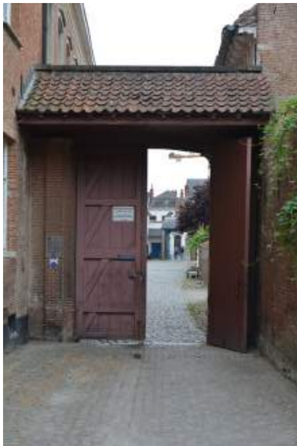
Fig. 5 'Bruine Poort' tussen infirmerie en 'Oude Pastorij' 2017
