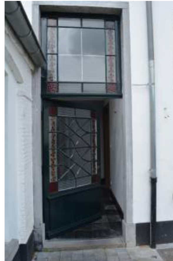
Fig.02. Houten deur in achtergevel
