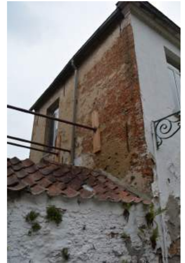
Fig.02. Zijgevel met muurankers
