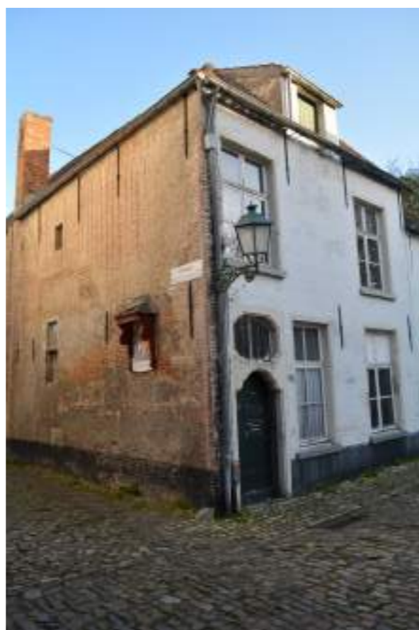
Fig.04. Hoek straatgevel met zijgevel
