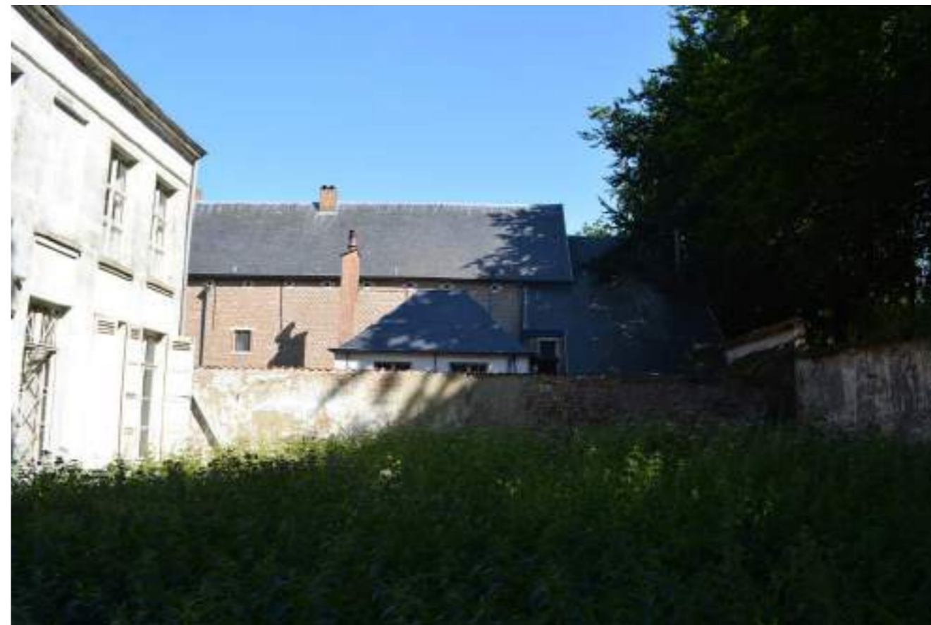
Fig.02. Tuin met ommuring, zicht op achtergevel SM20
