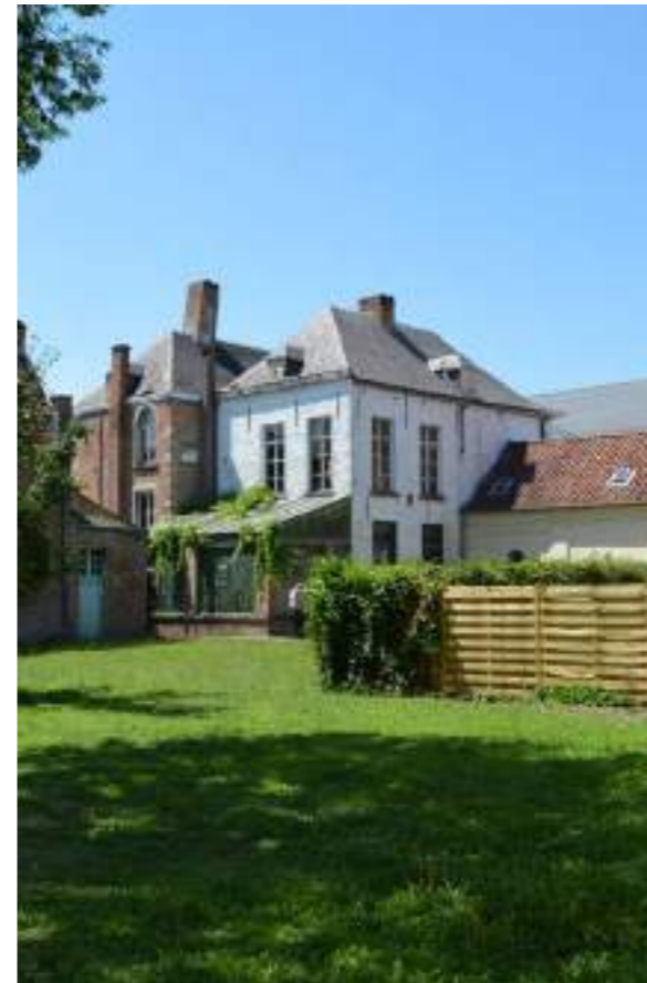
Fig.01. Zicht op achtergevel aan binnentuin
