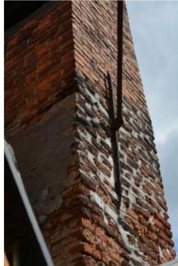
Fig.06. Detail achtergevel: schouw en verankering niv +2
