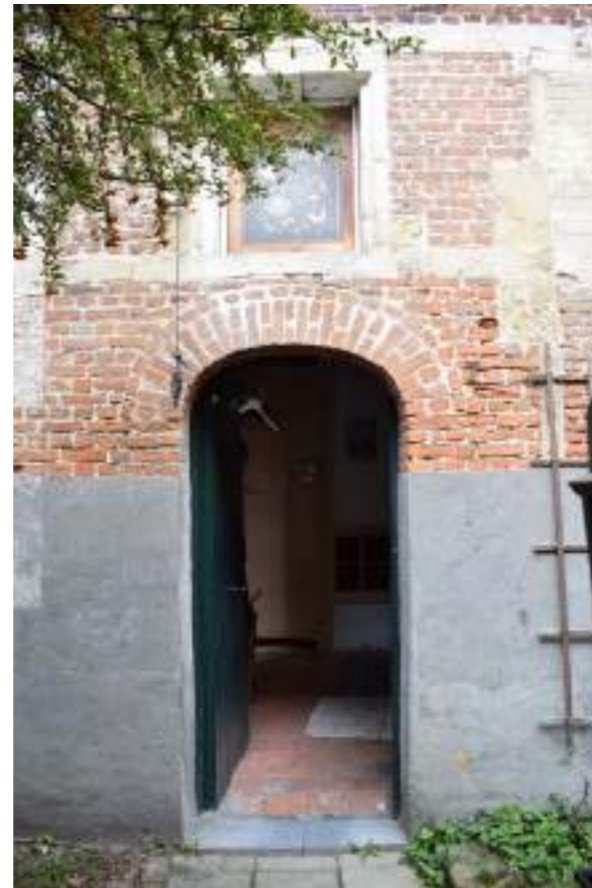
Fig.06. Detail voordeur met boog in metselwerk
