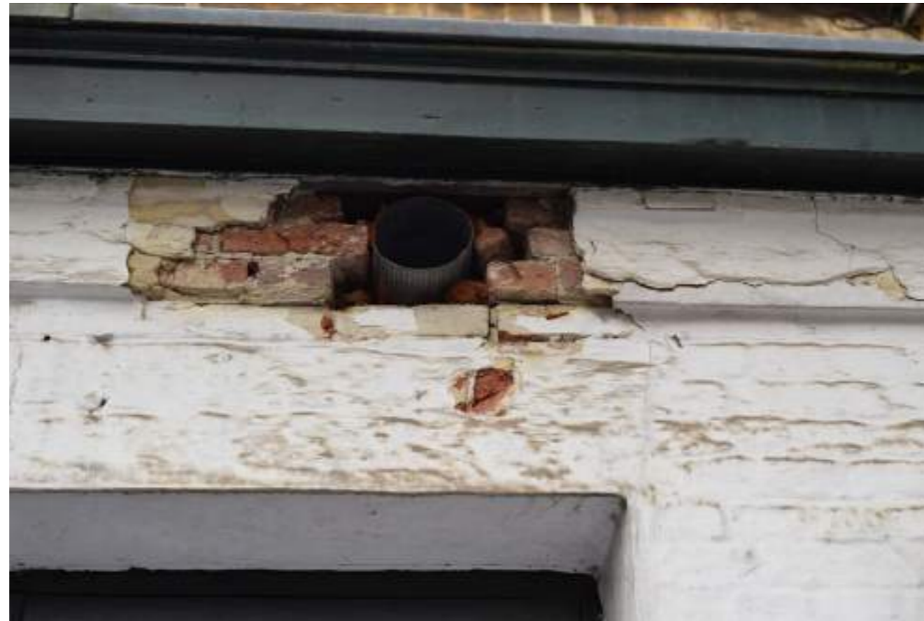
Fig.05. Detail aanbouw: doorsteek verluchtungskanaal
