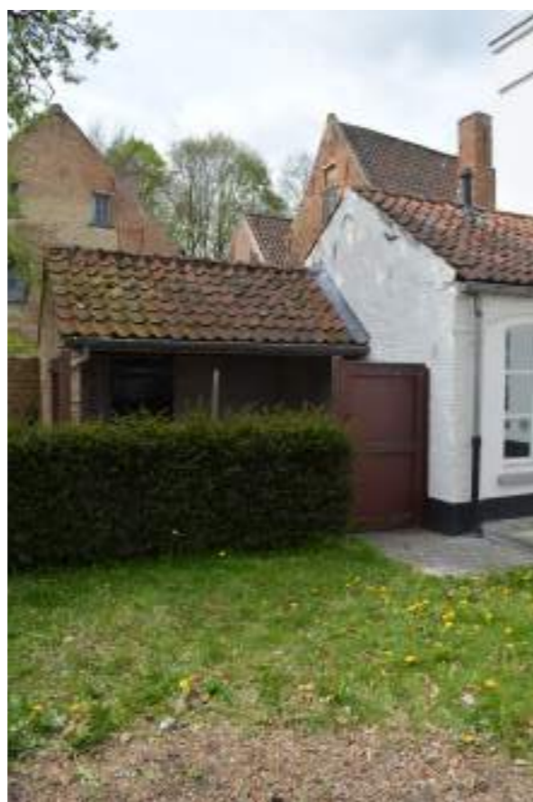
Fig.04. Aanbouw in metselwerk
