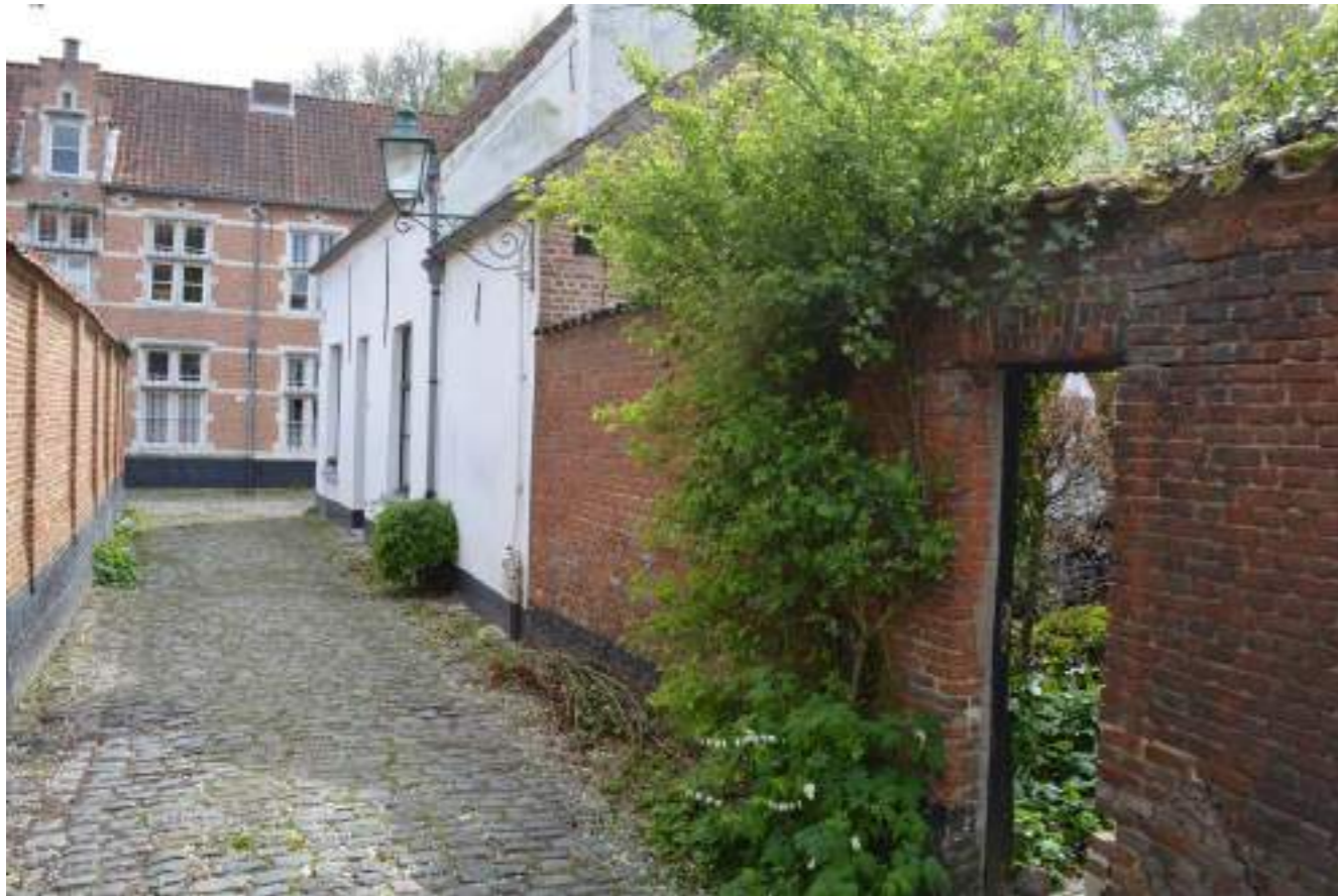
Fig.06. Voorgevel en ommuring koer vanuit Bodegemstraat
