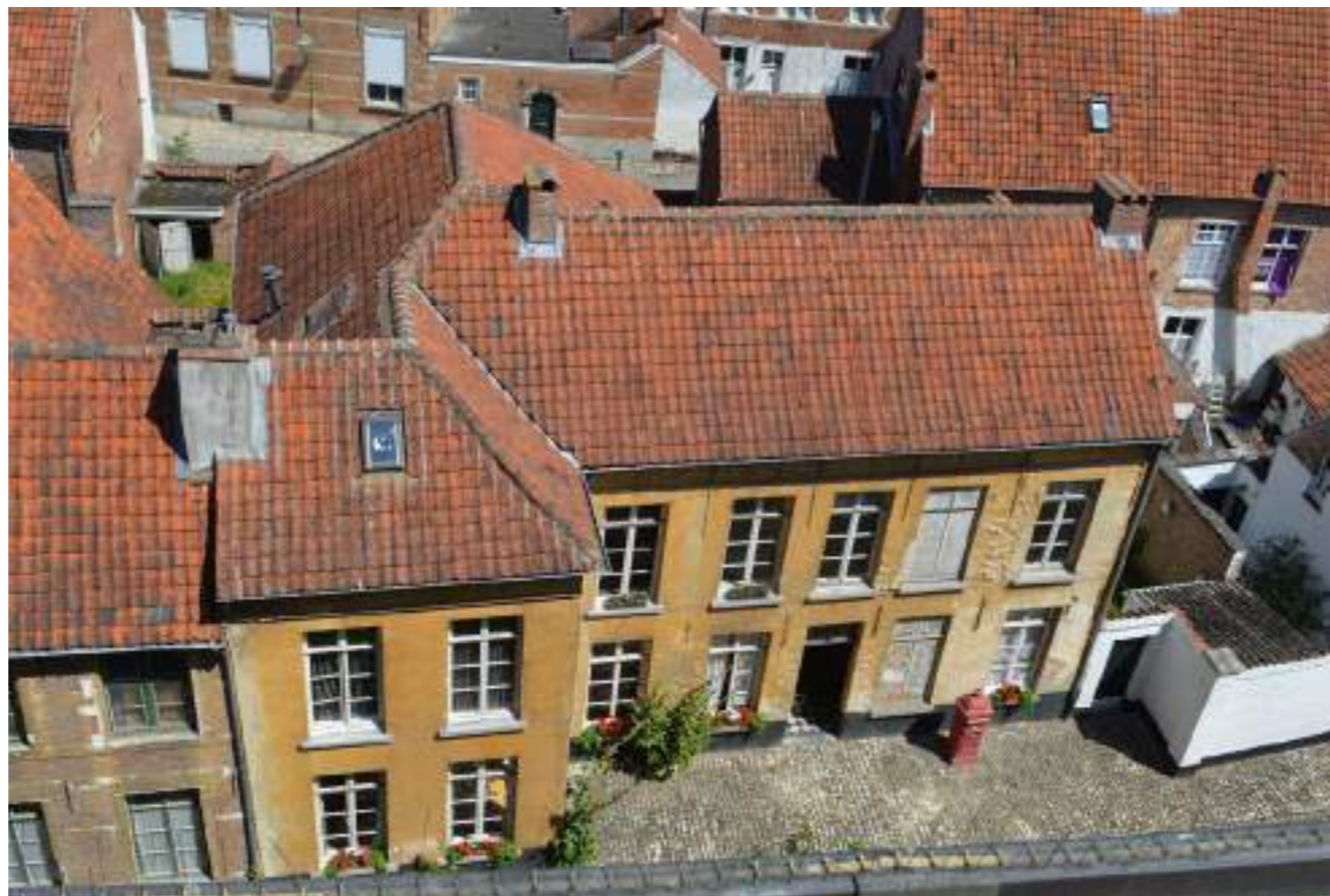
Fig.01. Voorgevel vanuit dakruimte St.-Margaretakerk
