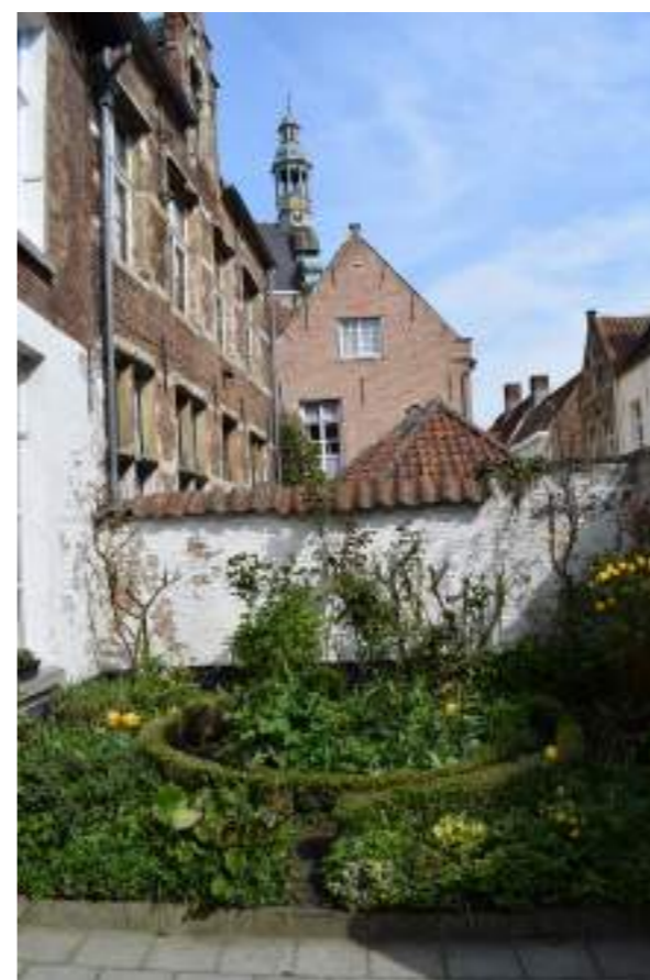
Fig.04. Binnenkoer met zicht op achtergevel OK01
