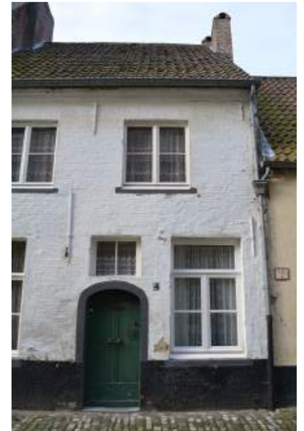
Fig.02. Voorgevel met houten voordeur
