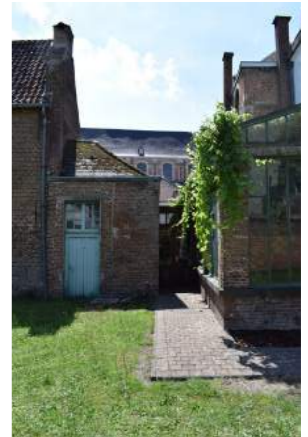
Fig.02. Achtergevel met houten schrijnwerk
