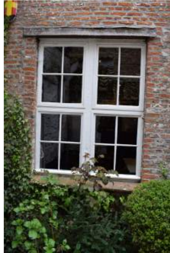
Fig.06. Detail houten schrijnwerk met houten latei
