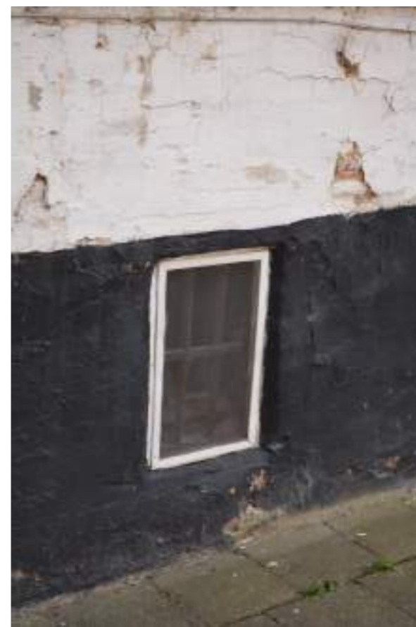
Fig.05. Detail opening naar kelderverdieping
