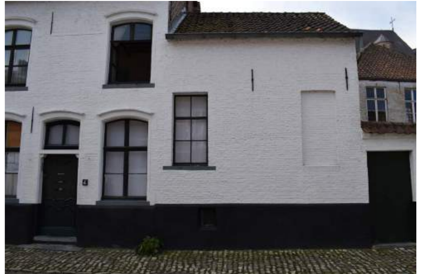
Fig.03. Voorgevel in wit gekalkte baksteen, zichtbare muurankers
