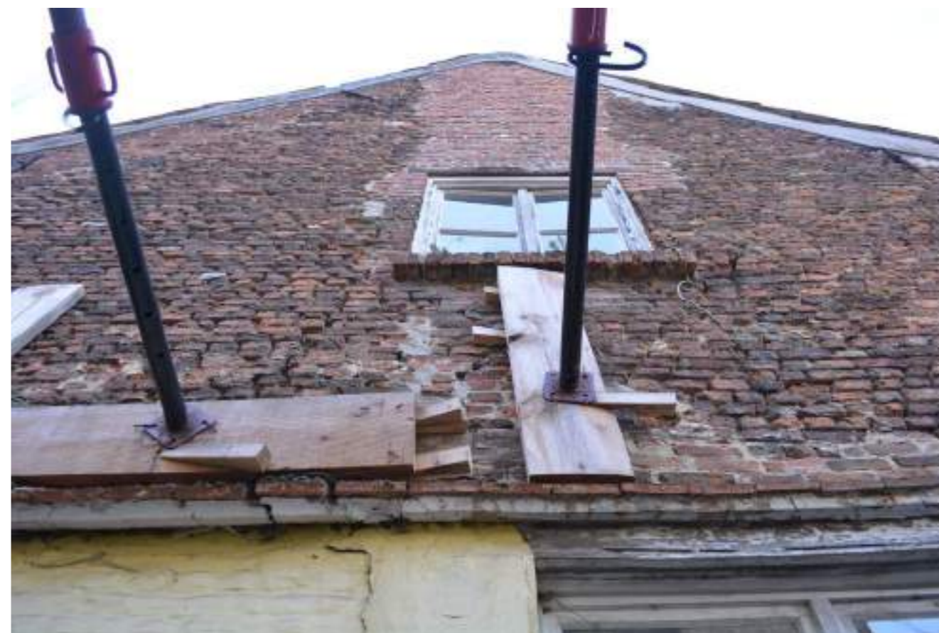
Fig.05. Achtergevel in metselwerk
