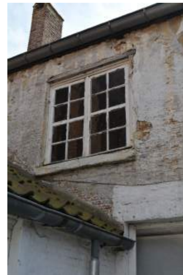
Fig.06. Detail houten schrijnwerk in achtergevel
