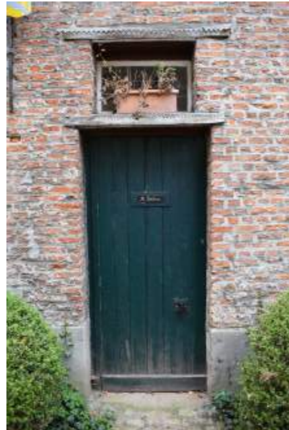
Fig.08. Houten voordeur met houten latei en loodslabben
