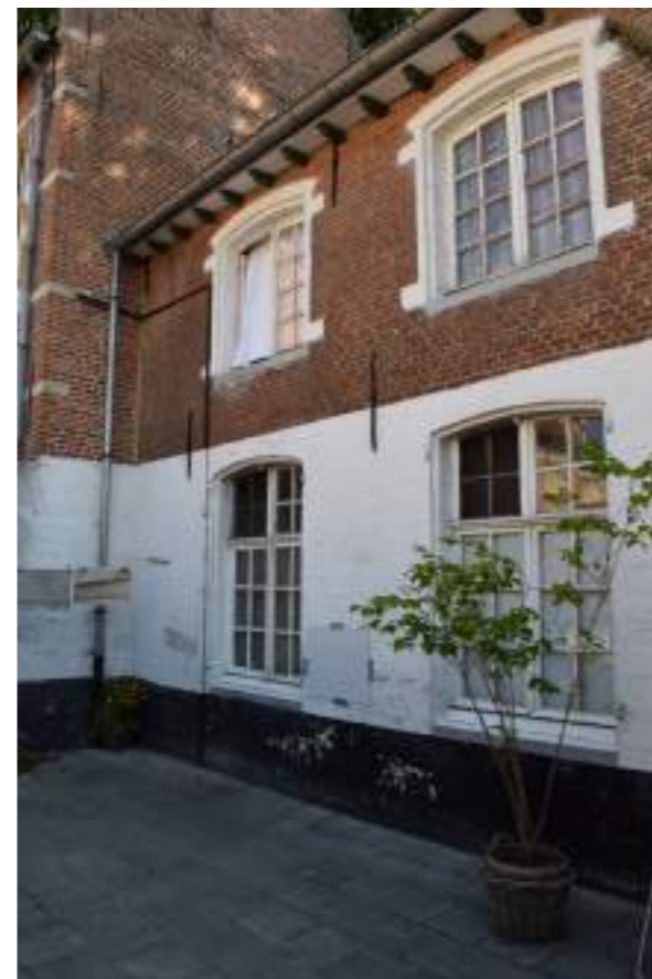
Fig.02. Voorgevel met muurankers en kroonlijst
