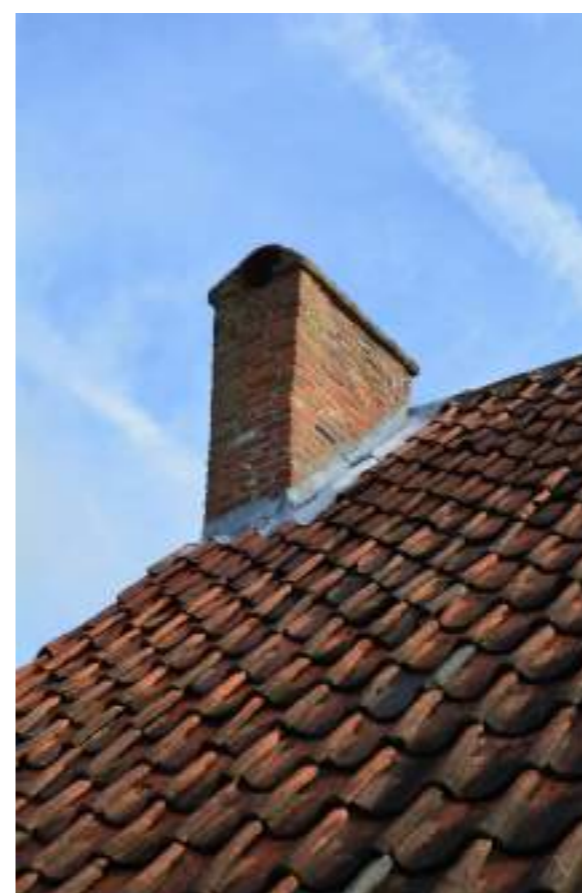
Fig.09. Detail dak met schouw in metselwerk
