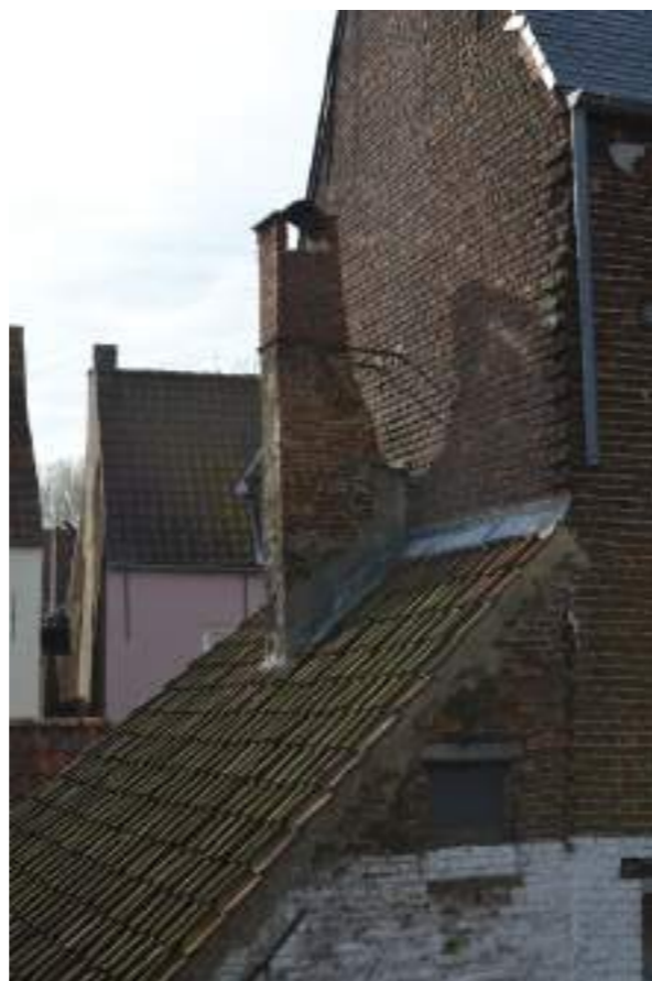
Fig.02. Schouw in metselwerk, verankerd aan zijgevel: SM06
