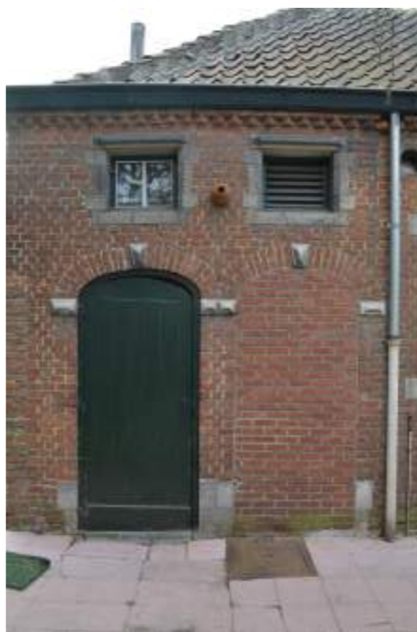
Fig.03. Detail bijgebouw: deur naar keuken
