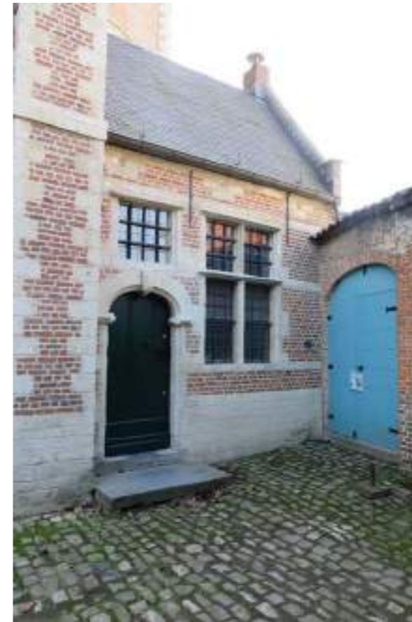
Fig.08. Poort aansluitend bij Begijnhofstraat
