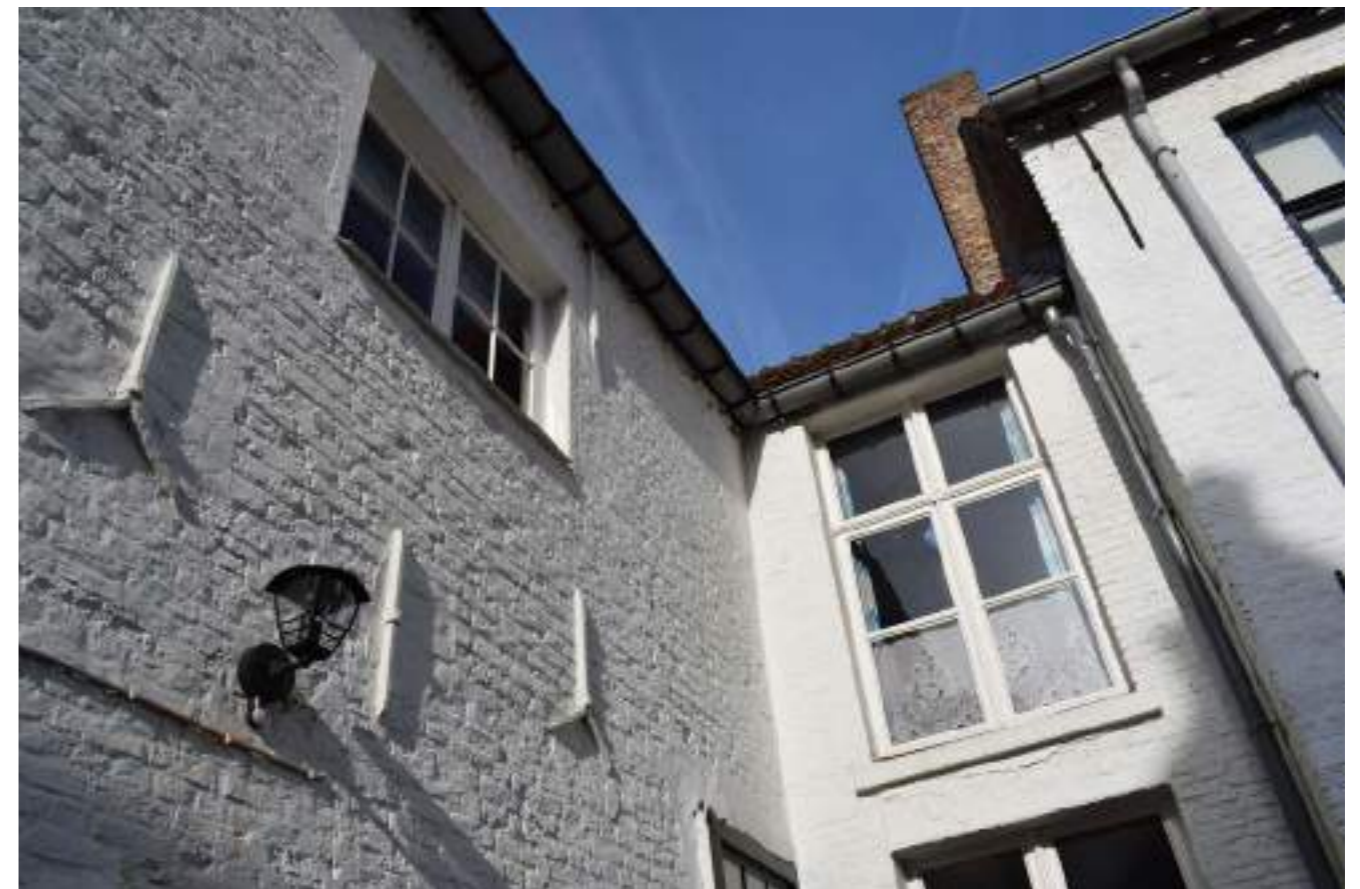
Fig.03. Detail van zijgevel en hoek met muurankers
