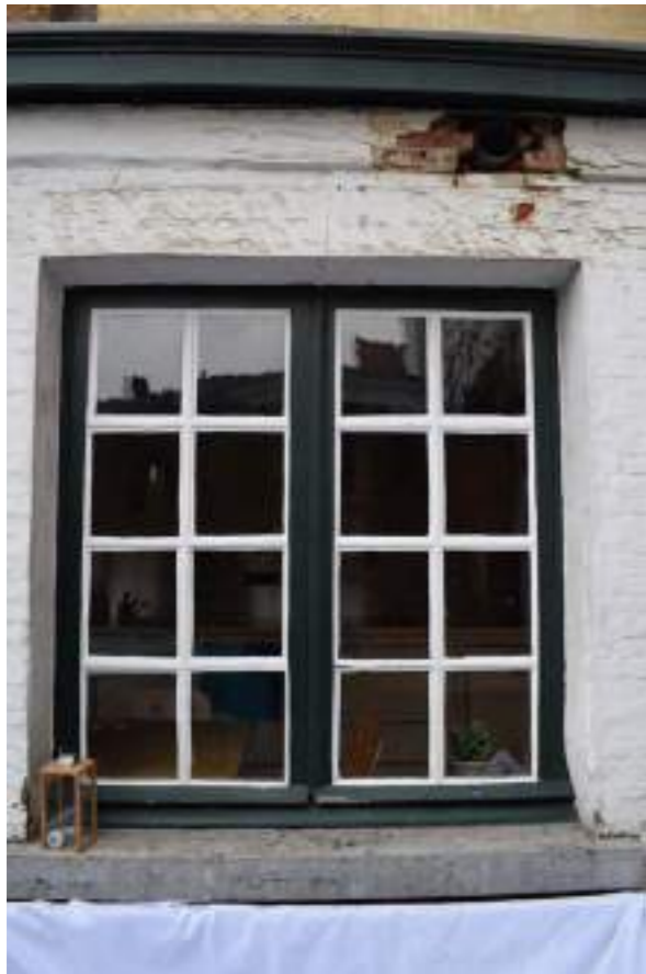
Fig.04. Detail aanbouw: schrijnwerk in hout
