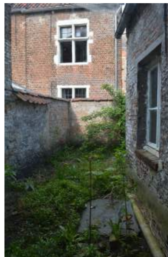
Fig.09. Tuin met aanbouw en zicht op achtergevel WE02
