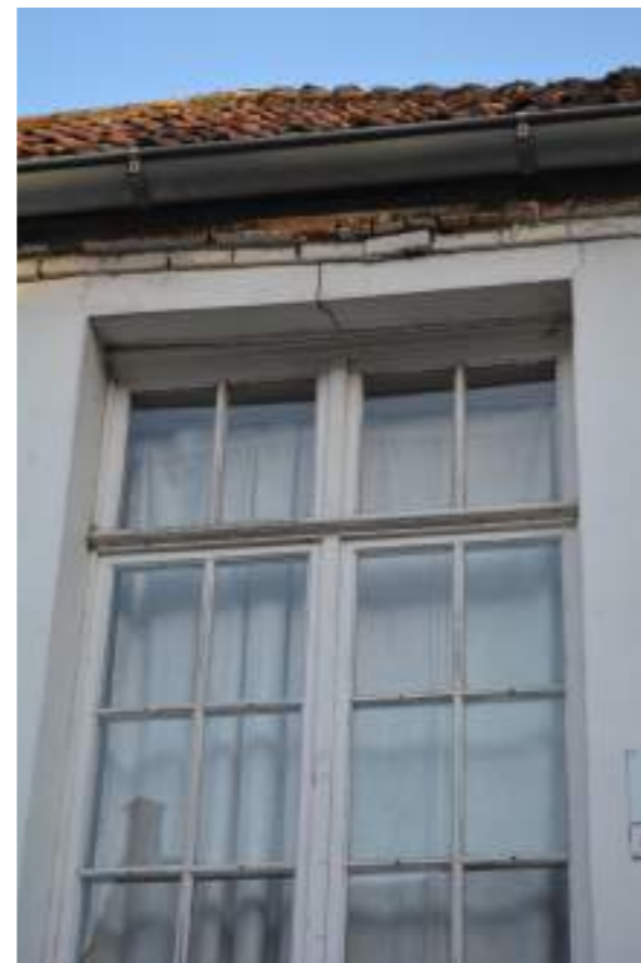
Fig.02. Detail houten schrijnwerk eerste verdieping
