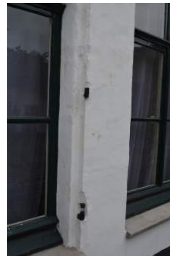
Fig.04. Detail metalen scharnieren achtergevel
