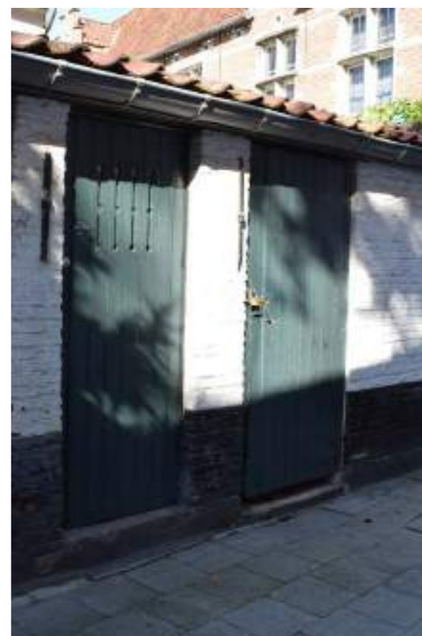
Fig.05. Houten deuren in aanbouw
