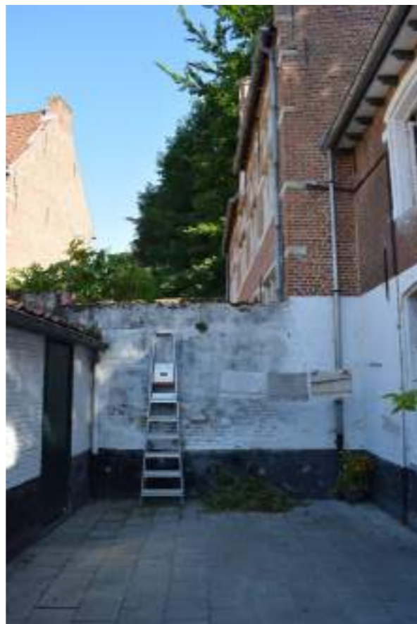
Fig.01. Binnenkoer, zicht op voorgevel GR15
