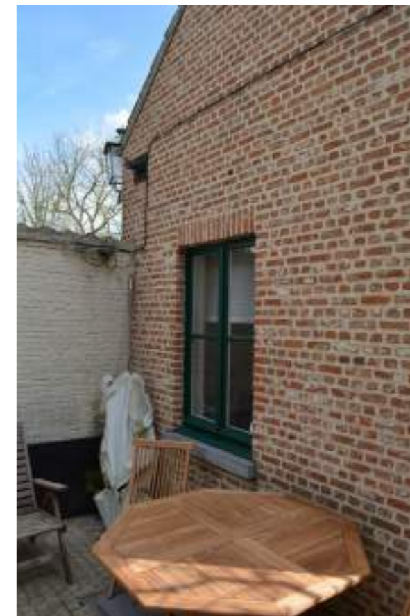
Fig.03. Houten schrijnwerk in vernieuwde achtergevel (1998)
