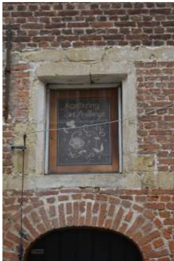
Fig.01. Detail stenen kozijn en houten schrijnwerk
