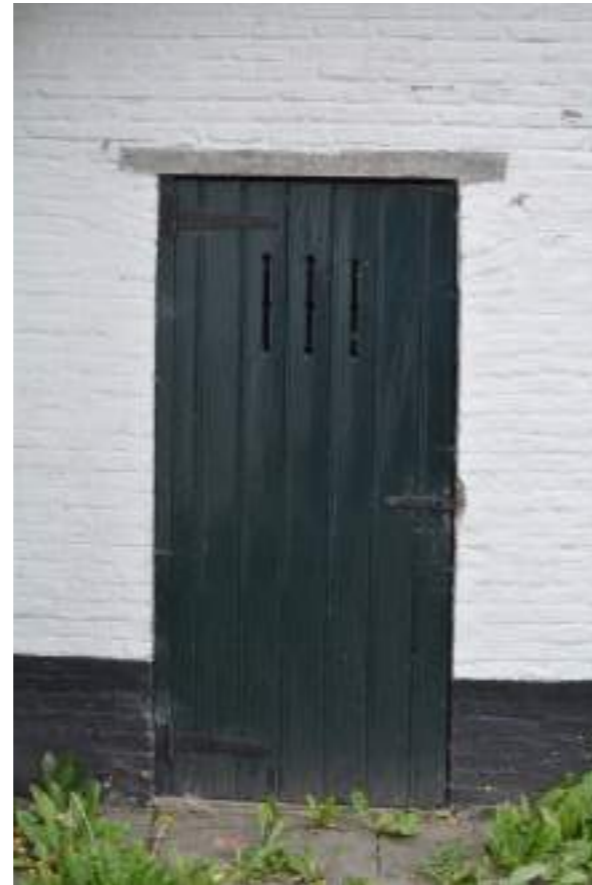
Fig.08. Detail houten deur met metalen beslag aan tuinberging
