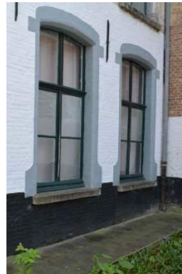
Fig.03. Houten schrijnwerk in voorgevel
