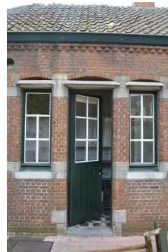
Fig.02. Detail bijgebouw: deur naar keuken
