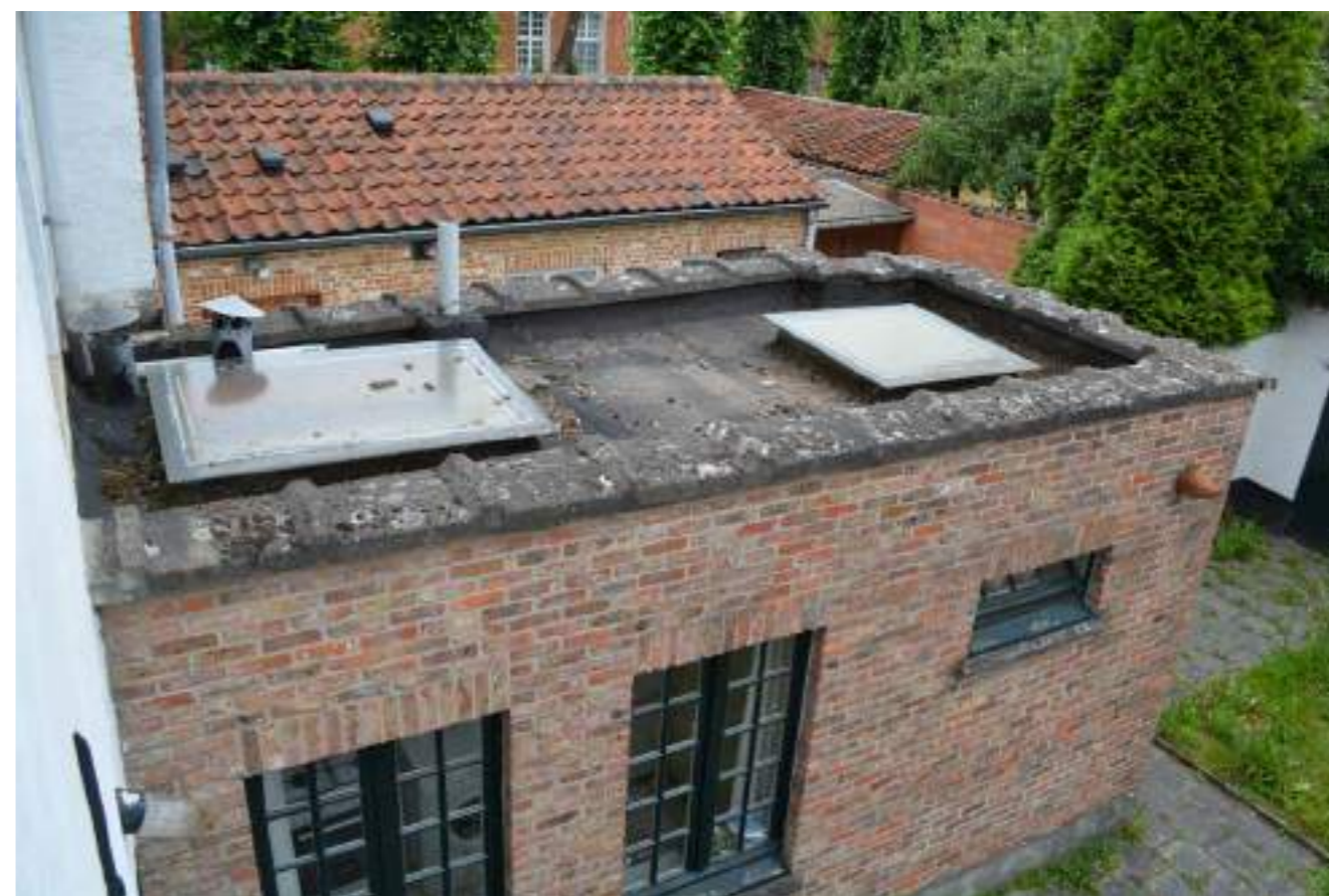
Fig.05. Zicht op plat dak aanbouw met lichtkoepels
