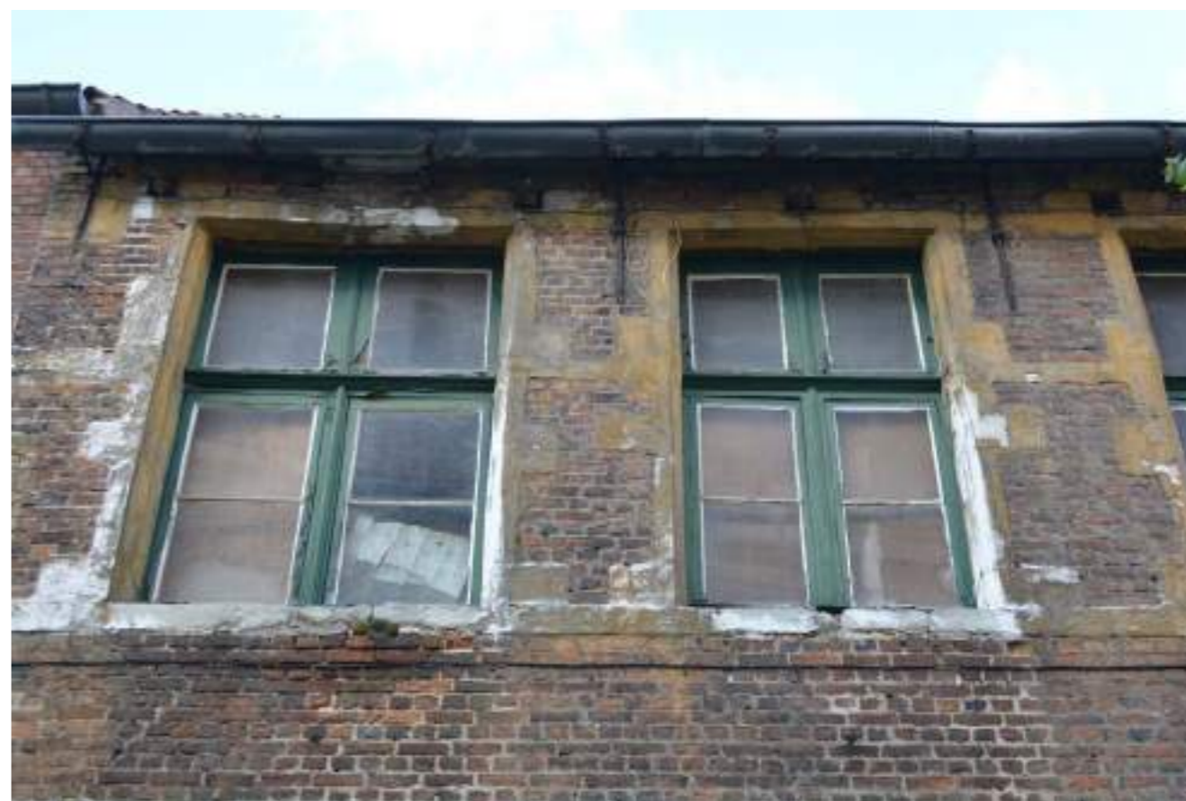
Fig.04. Detail houten schrijnwerk eerste verdieping voorgevel
