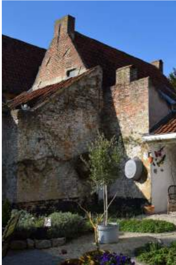
Fig.05. Zicht op tuinmuur en zijgevel SYM 09
