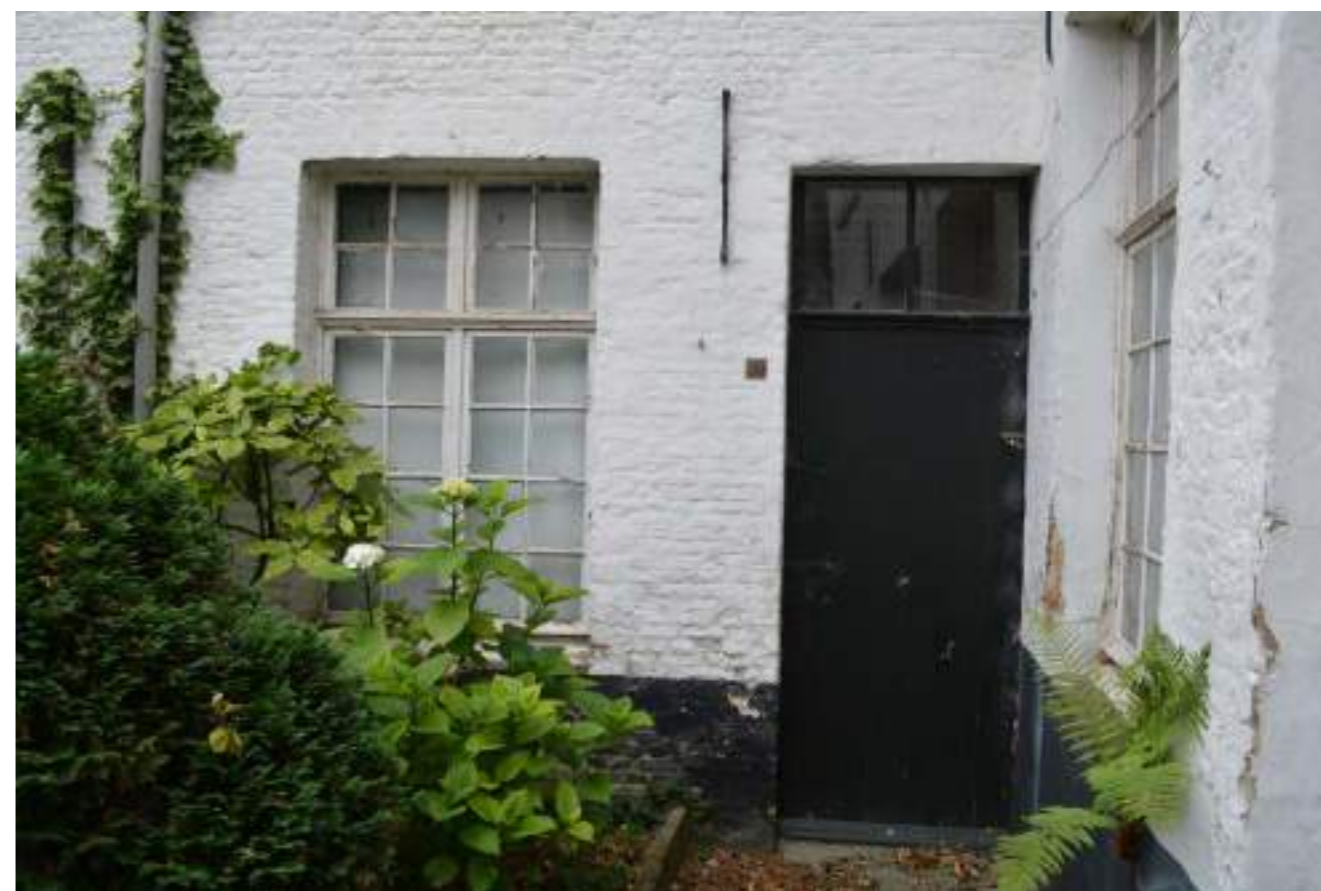
Fig.04. Voorgevel met houten voordeur
