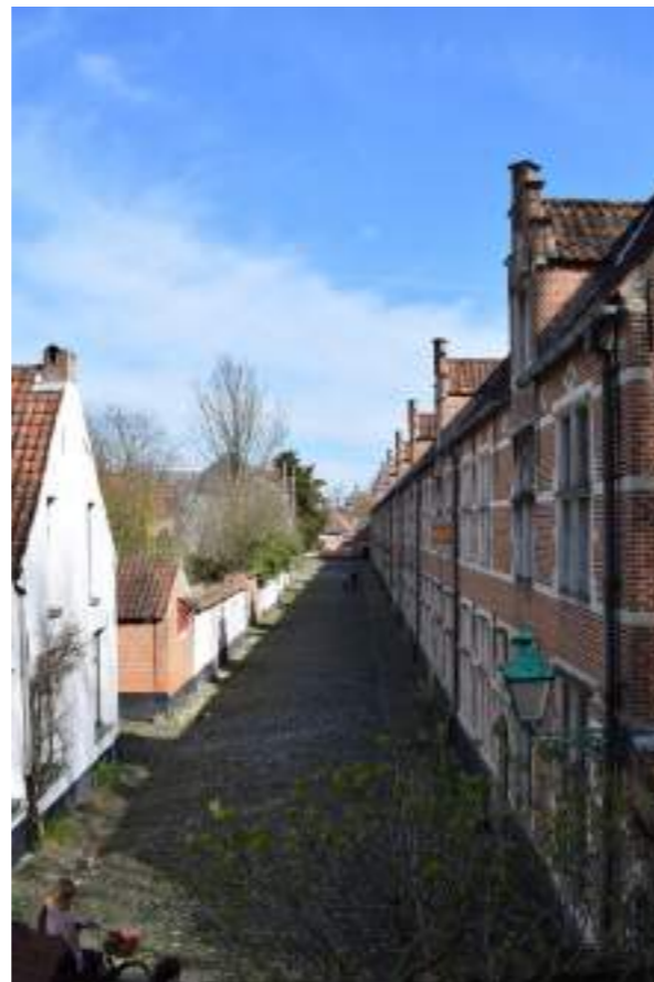
Fig. 1 Zichtas Grachtkant richting Schapenkoppenstraat
