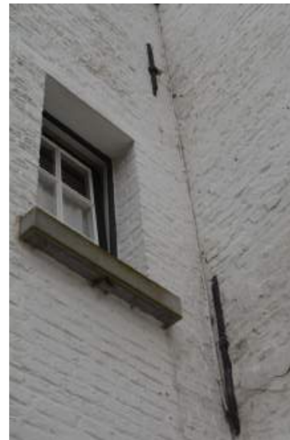
Fig.07. Detail muurankers in zijgevel
