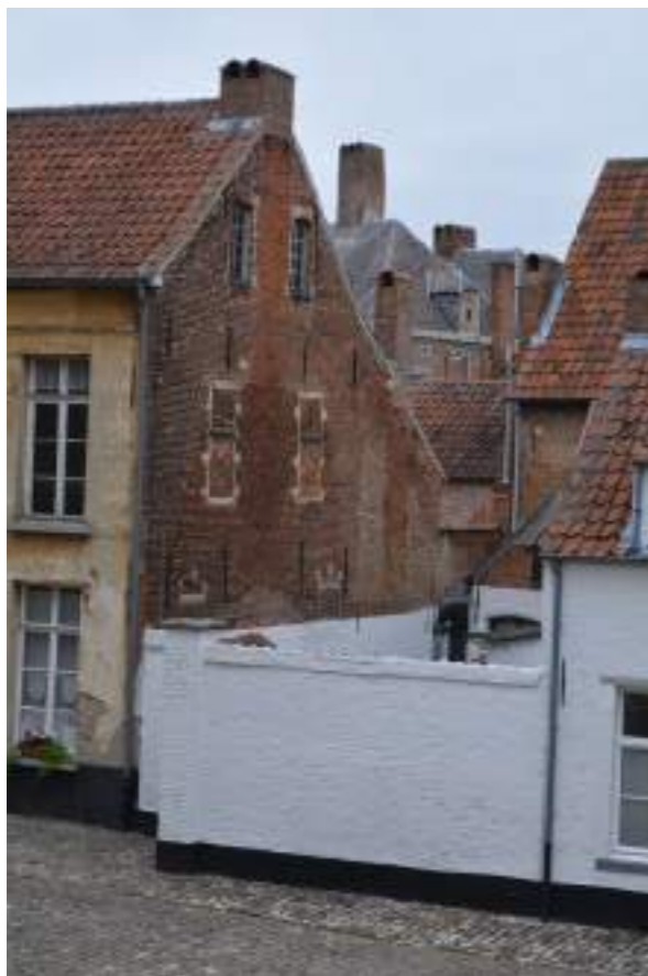
Fig.06. Zijgevel in metselwerk
