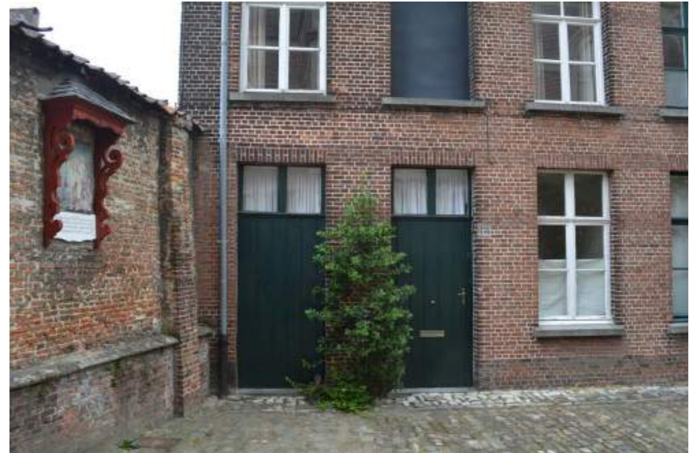
Fig.04. Voorgevel en ommuring begijnhof in metselwerk
