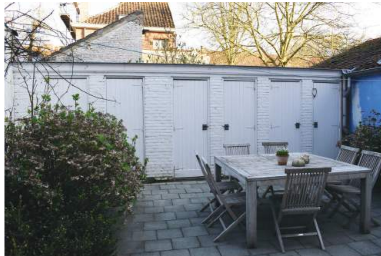
Fig.02. Koer met aanbouw in metselwerk, houten schrijnwerk met metalen beslag
