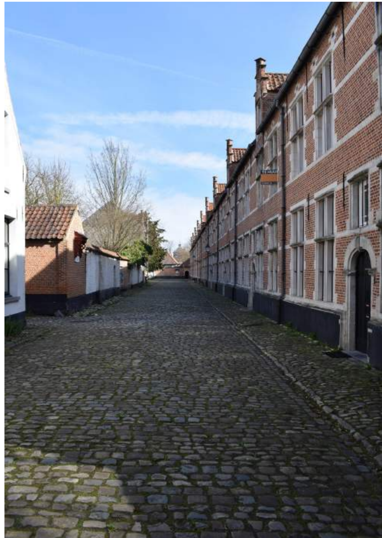
Fig. 3 Zichtas Grachtkant richting Schapenkoppenstraat
