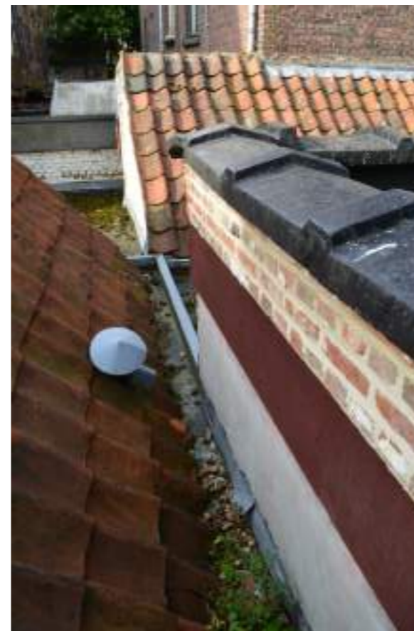
Fig.06. Aansluiting aanbouw OK03 op dakopstand aanbouw
