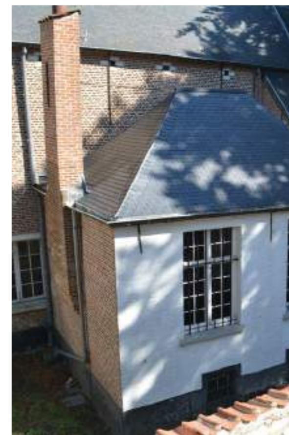
Fig.07. Bijgebouw aan achtergevel
