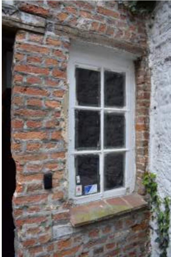
Fig.05. Detail houten schrijnwerk met houten latei
