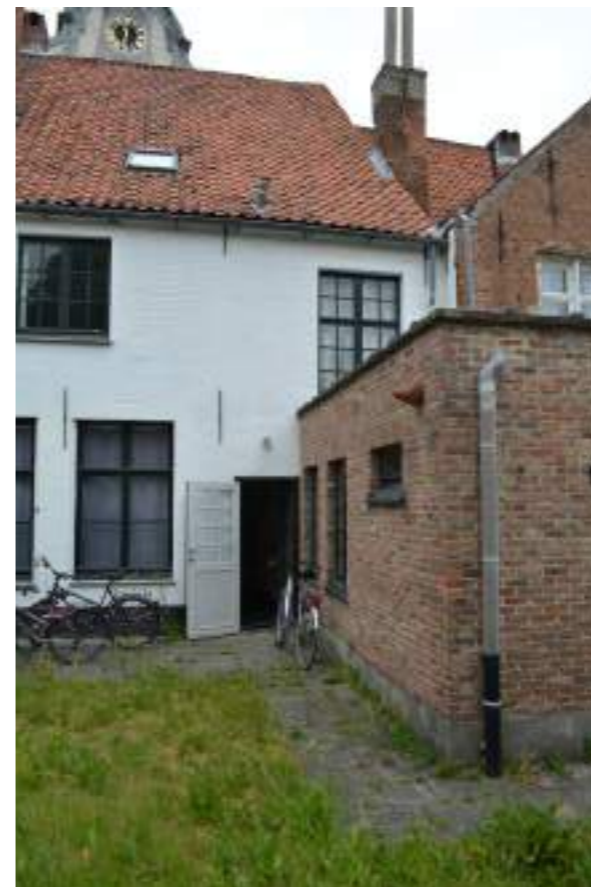
Fig.02. Aanbouw in metselwerk
