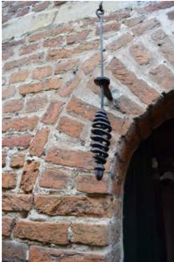
Fig.08. Detail boogmetselwerk en smeedwerk voordeur
