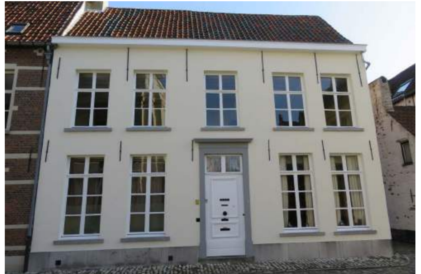
Fig.01. Voorgevel met muurankers zichtbaar
