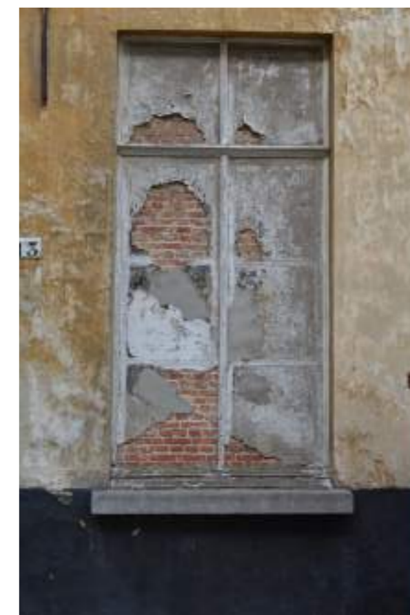
Fig.05. Detail afgesloten raamopening in metselwerk
