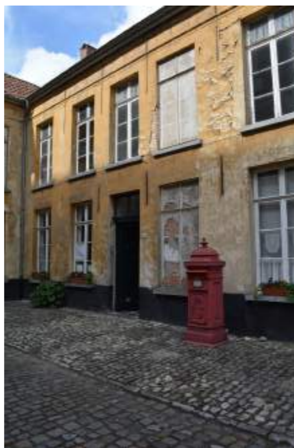
Fig.03. Voorgevel met muurankers zichtbaar
