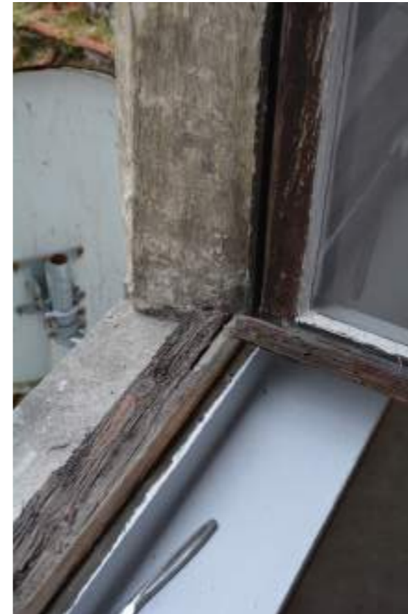
Fig.03. Detail houten schrijnwerk
