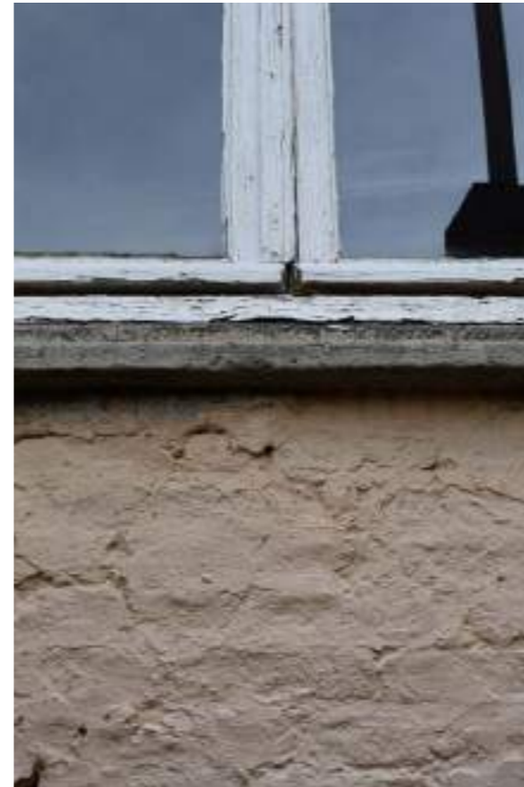
Fig.09. Detail houten schrijnwerk in achtergevel
