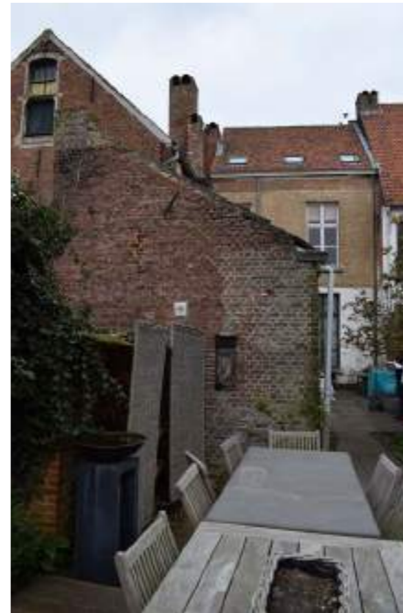
Fig.01. Zicht op achterkant aanbouw
