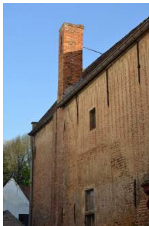
Fig.05. Detail zijgevel: zichtbare verankeringen
