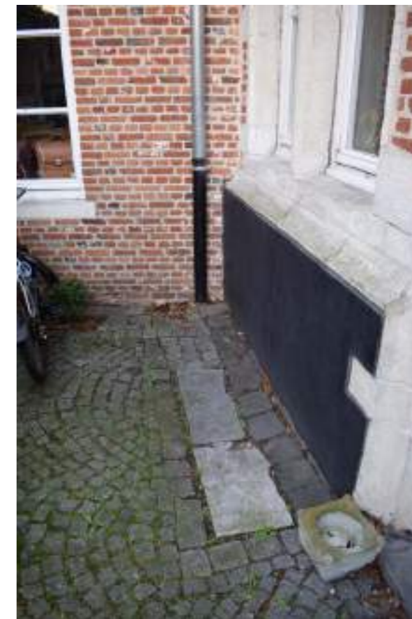
Fig.03. Detail hoge plint in natuursteen
