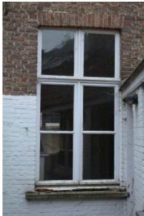
Fig.06. Detail houten schrijnwerk in achtergevel
