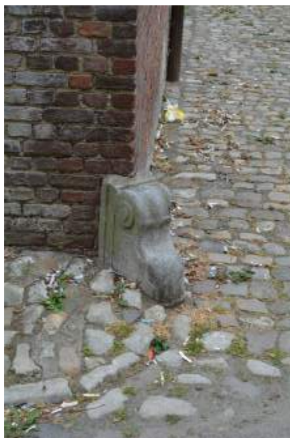
Fig.03. Detail schampsteen
