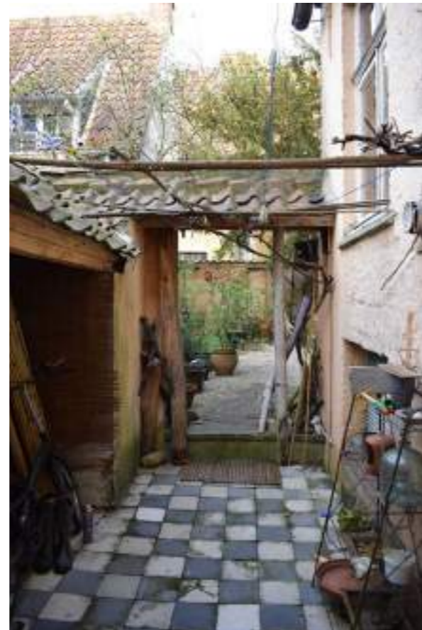
Fig.06. Berging met dakconstructie
