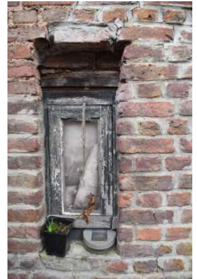
Fig.02. Detail aanbouw: terugliggend raam en latei in hout
