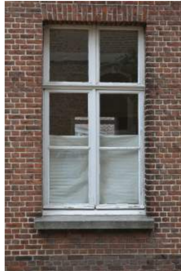
Fig.03. Detail houten schrijnwerk voorgevel
