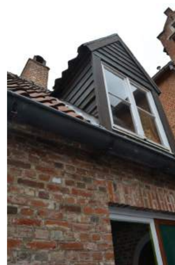
Fig.05. Detail dakkapel met houten afwerking
