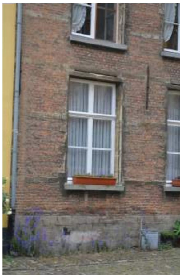
Fig.03. Houten schrijnwerk, muuranker zichtbaar
