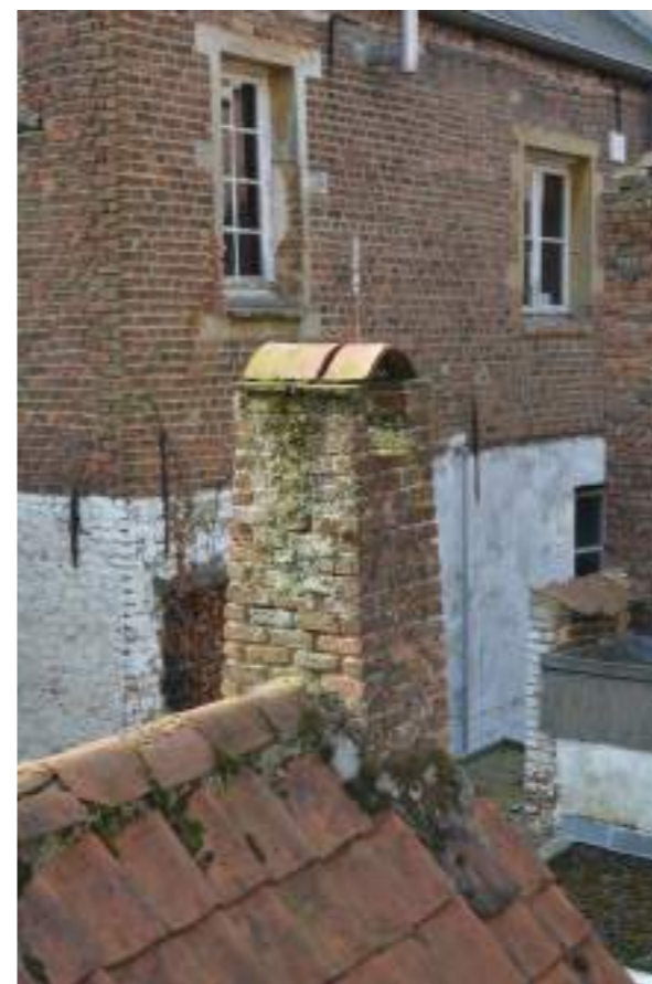
Fig.03. Schouw in metselwerk: aanbouw OK03
