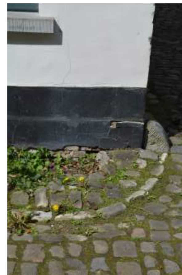
Fig.05. Detail aansluiting gevel op kasseiweg
