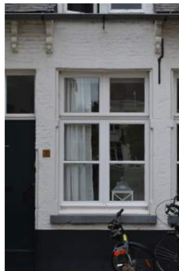
Fig.04. Detail houten schrijnwerk voorgevel
