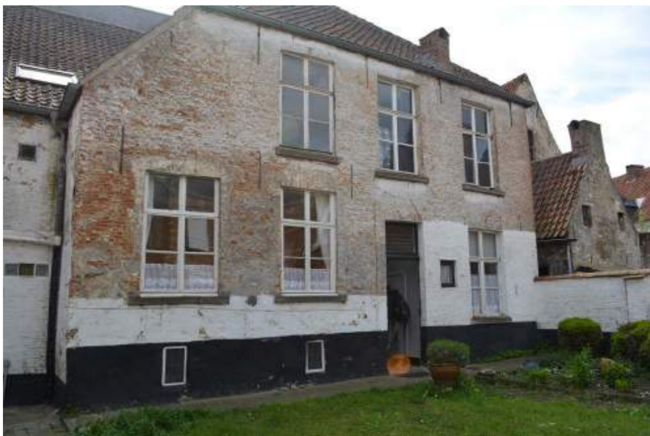
Fig.09. Achtergevel met houten schrijnwerk en zichtbare muurankers
