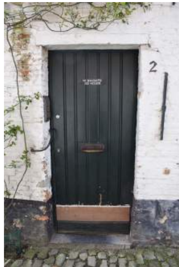
Fig. 08. Houten toegansdeur naar koer Pompstraat
