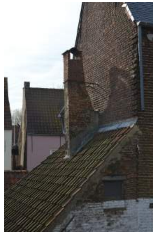
Fig.10. Verankerde schouw in metselwerk aan achterbouw
