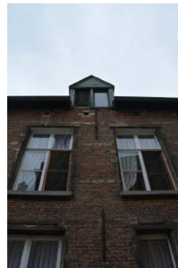
Fig.05. Voorgevel met houten schrijnwerk
