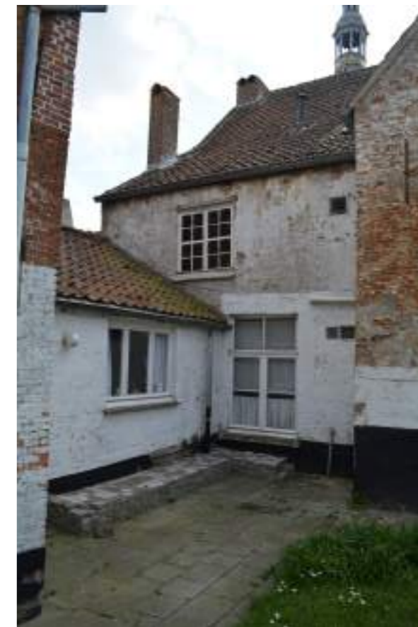
Fig.03. Hoek bijgebouw aan achtergevel
