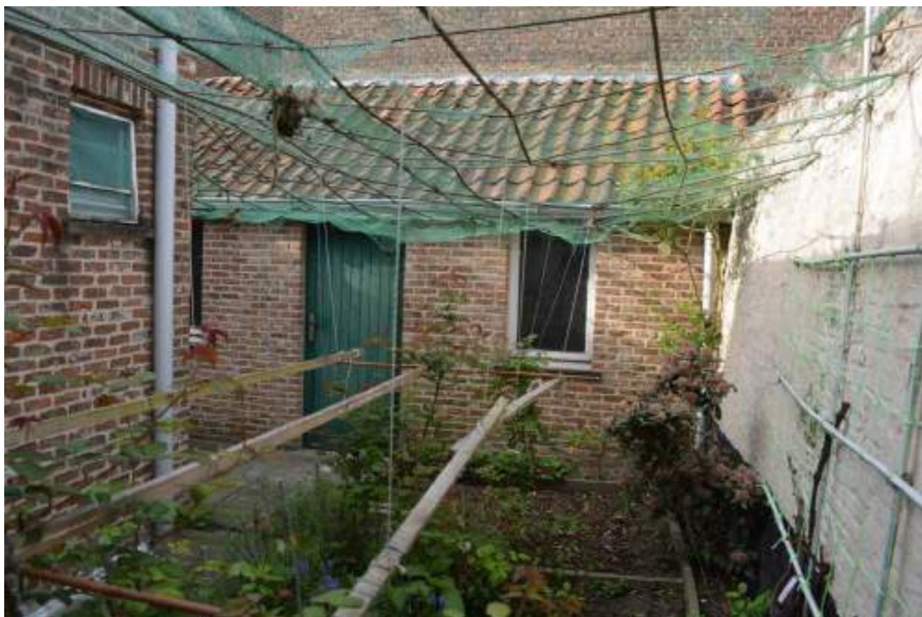
Fig.05. Koer met aanbouw en tuinberging
