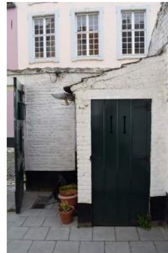
Fig.03. Houten deur in berging voorgevel
