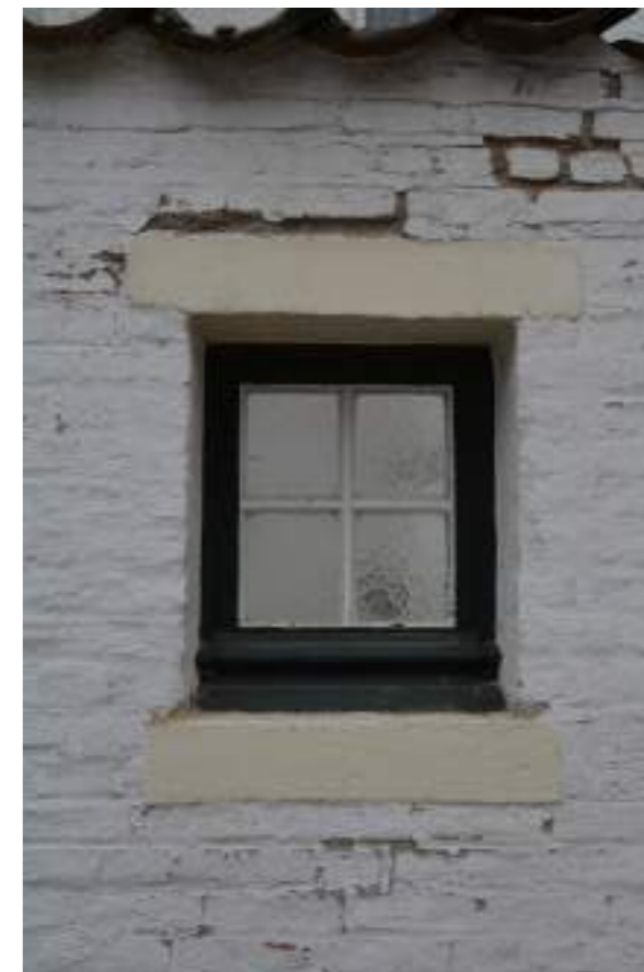
Fig.03. Houten schrijnwerk voorgevel
