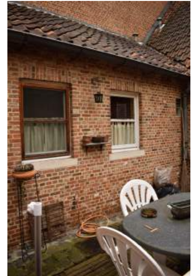
Fig.04. Achtergevel met houten schrijnwerk
