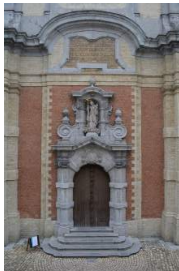
Fig.05. Zicht op deur hoofdingang vanuit SM05
