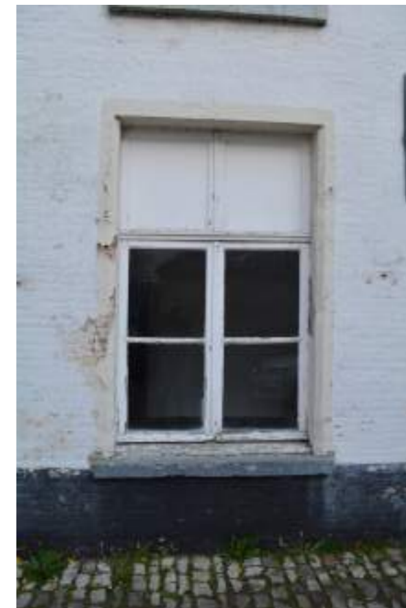
Fig.03. Detail straatgevel: houten schrijnwerk
