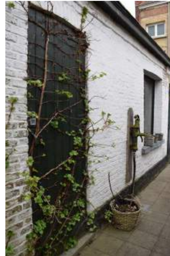
Fig.08. Detail aanbouw: deur naar badkamer
