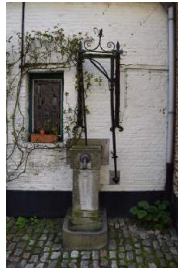
Fig.03. Waterpomp in arduin en smeedwerk aan voorgevel
