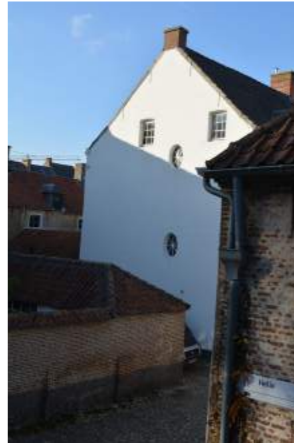
Fig.02. Zijgevel vanuit eerste verdieping HE02
