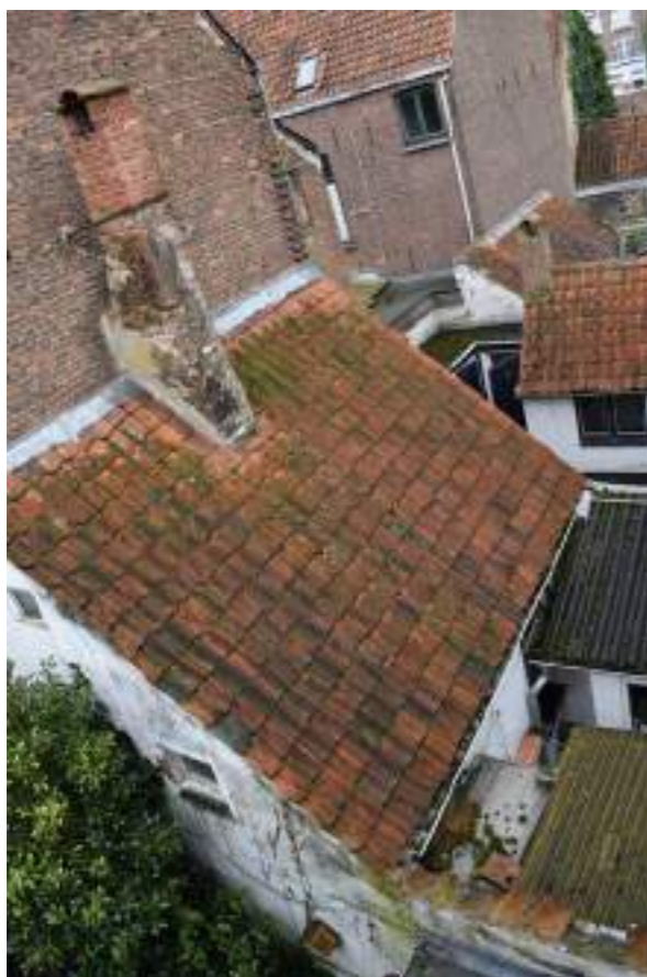
Fig.08. Zicht op achterbouw aan SM06 vanuit OK01
