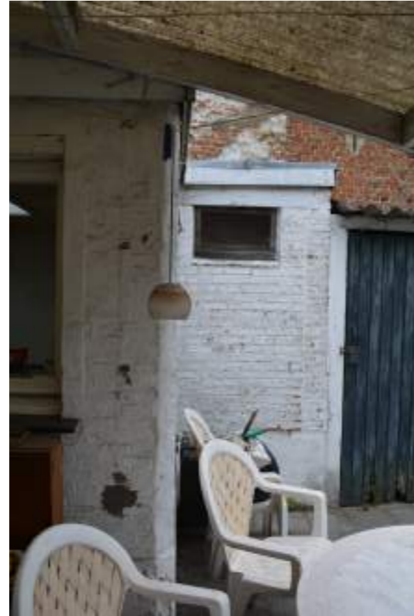
Fig.05. Zicht op bijgebouw in metselwerk
