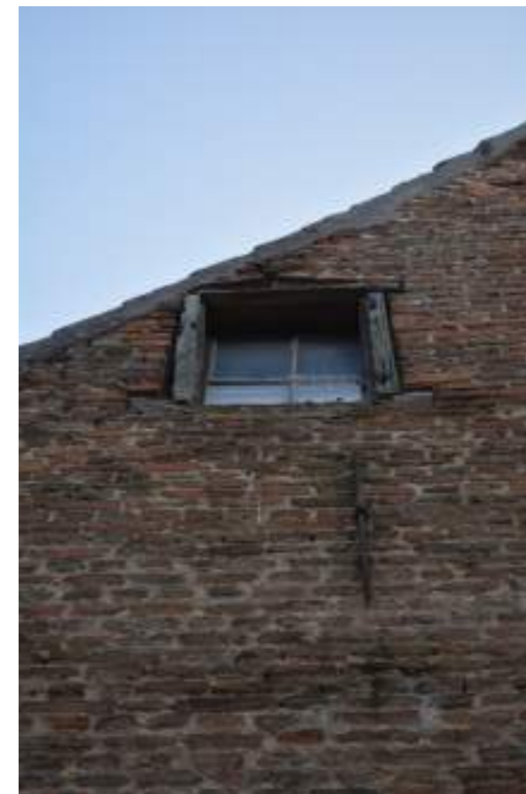
Fig.03. Detail houten schrijnwerk in straatgevel
