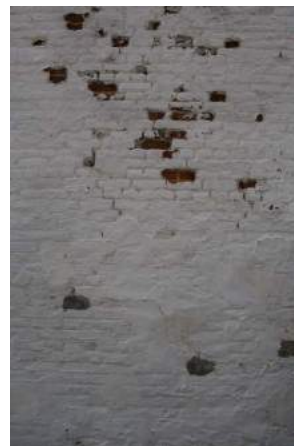
Fig.06. Detail witgekalkte baksteen muur aan zijgevel
