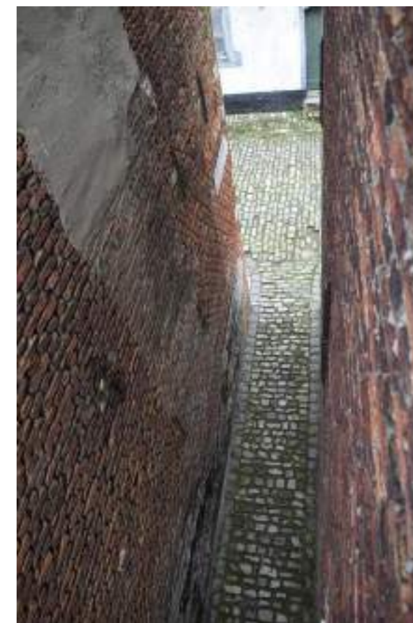
Fig.05. Zicht op Hemdsmouwken vanuit verdieping
