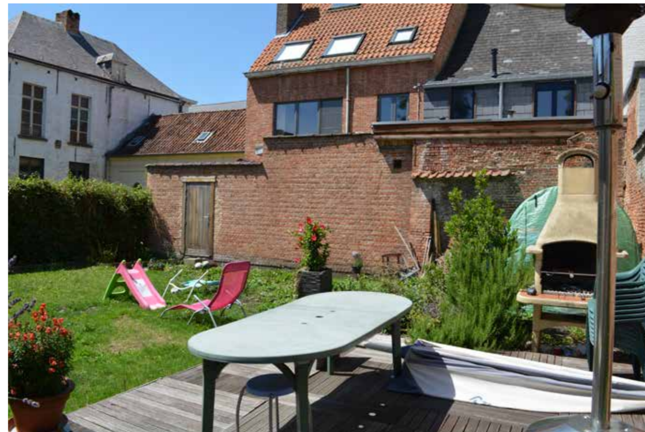
Fig.05. Zicht achtergevel BE21 & BE23
