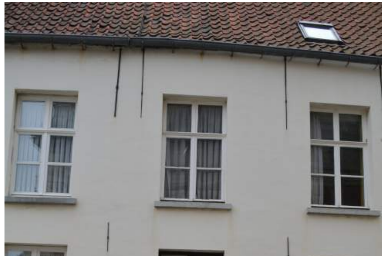
Fig.02. Detail voorgevel met zichtbare muurankers, schrijnwerk eerste verdieping,
