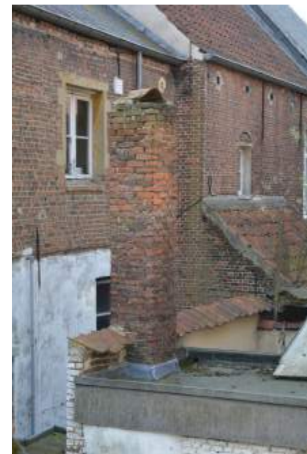
Fig.04. Schouw in metselwerk: SYM03
