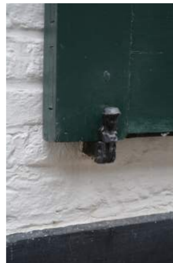
Fig.05. Detail smeedwerk houten luik
