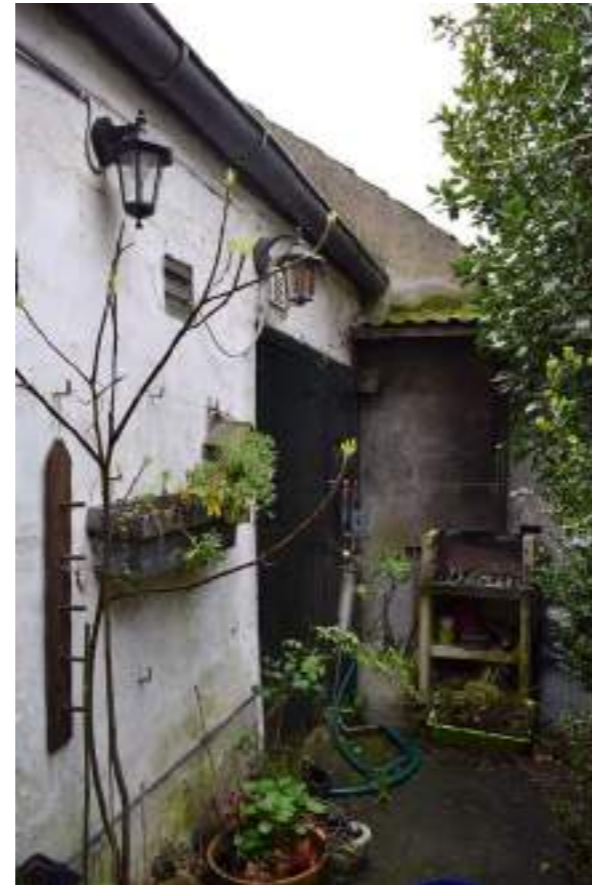
Fig.03. Koer met keuken en berging in aanbouw
