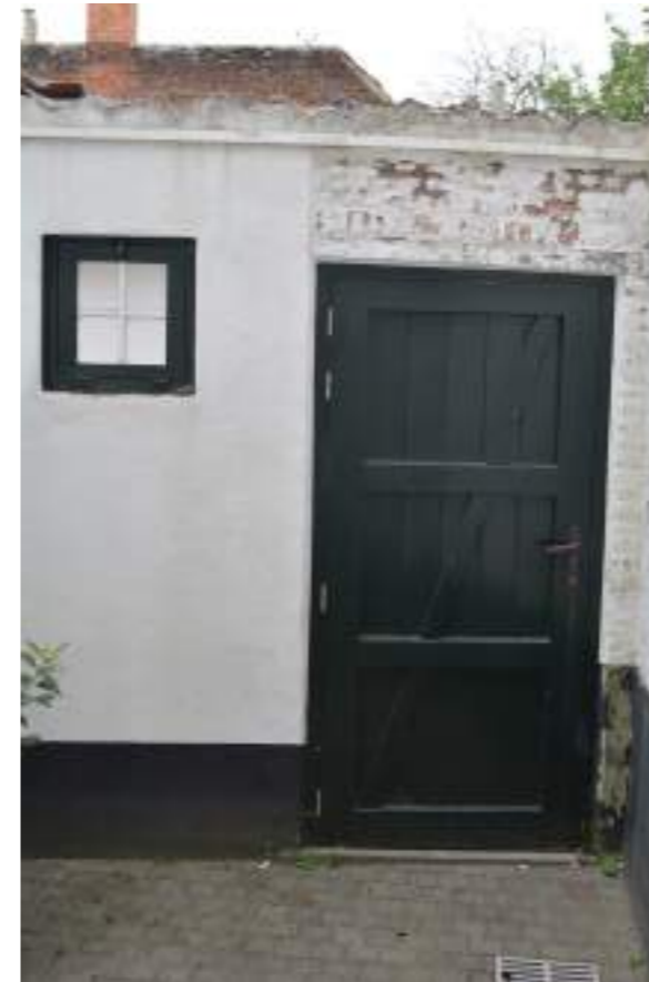
Fig.10. Deur binnenkoer uitgevend op pompstraat
