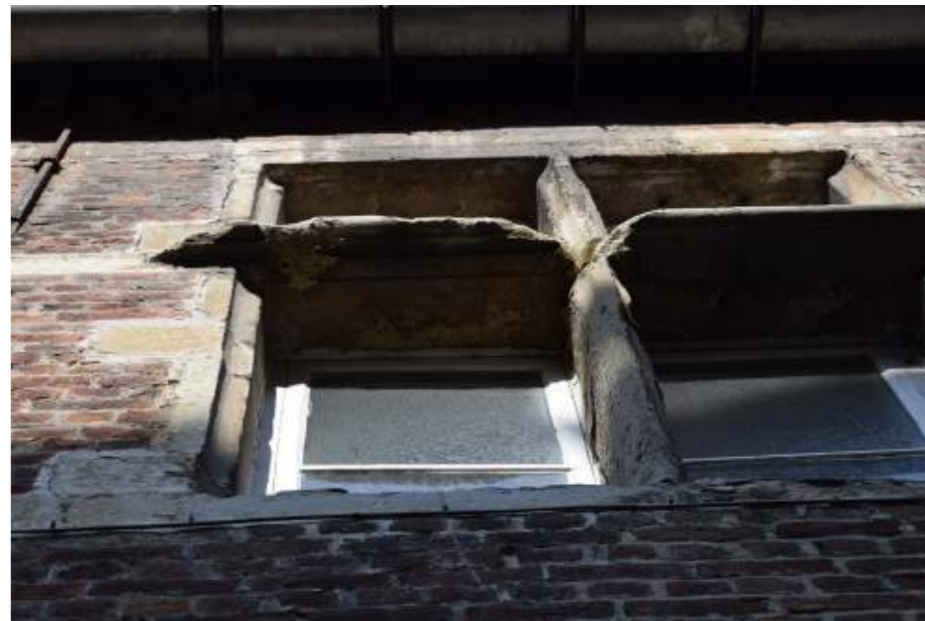
Fig.02. Detail stenen kozijn met houten schrijnwerk
