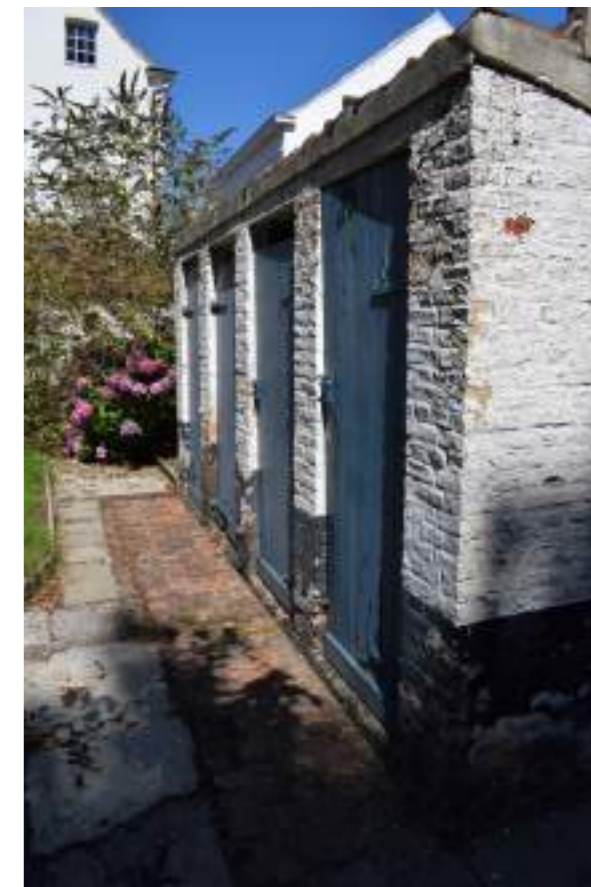
Fig.03. Berging in metselwerk met houten deuren
