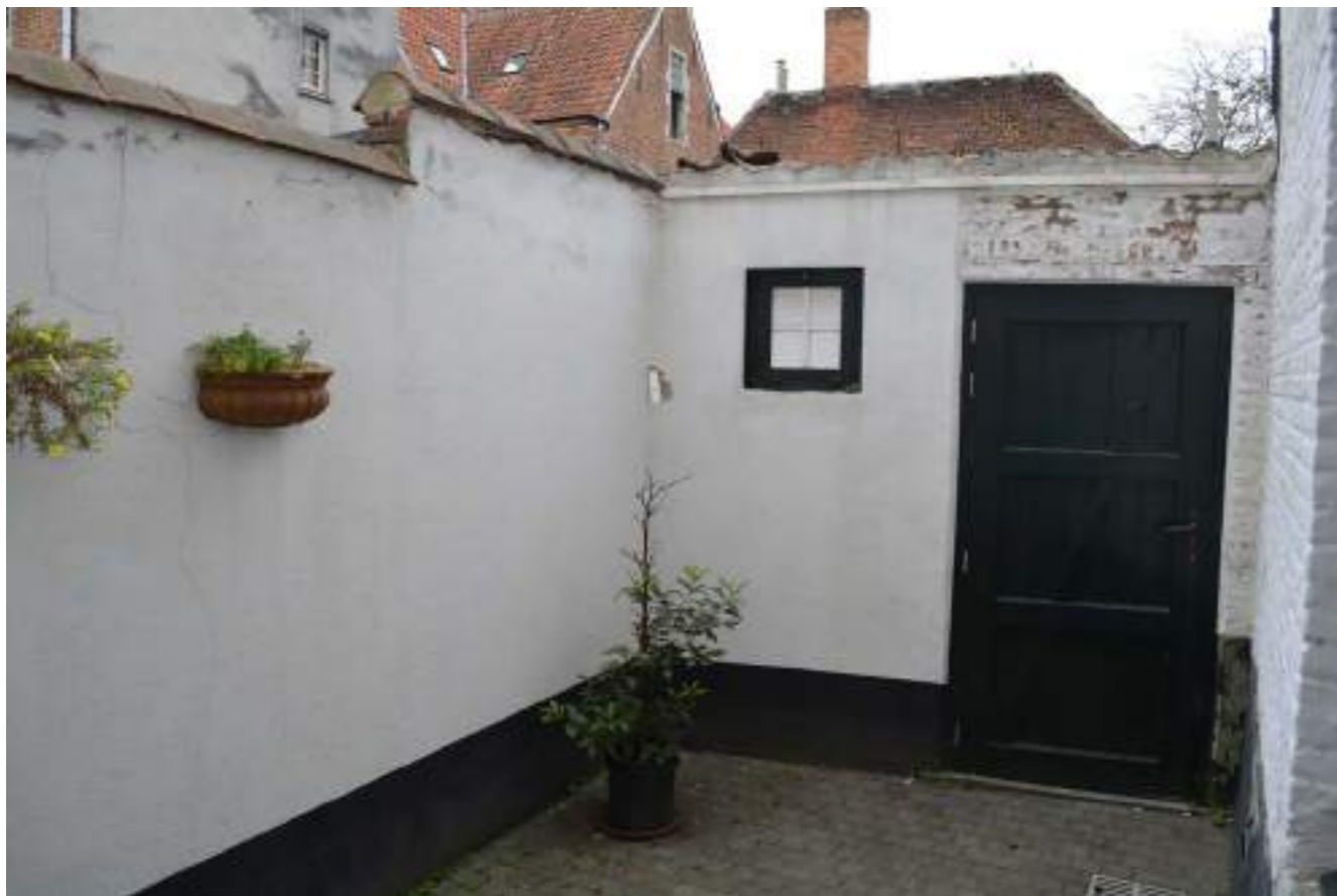
Fig.06. Deur binnenkoer uitgevend op Pompstraat
