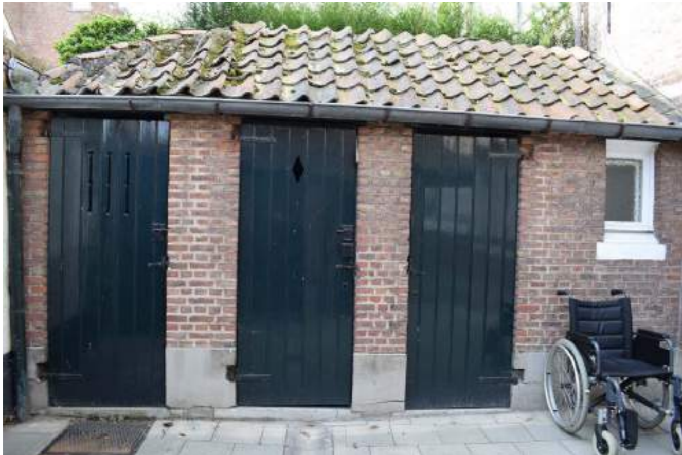
Fig.07. Aanbouw in metselwerk, houten schrijnwerk met metalen beslag
