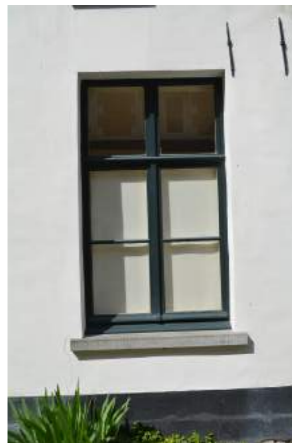
Fig.04. Detail houten schrijnwerk en muurankers zijgevel
