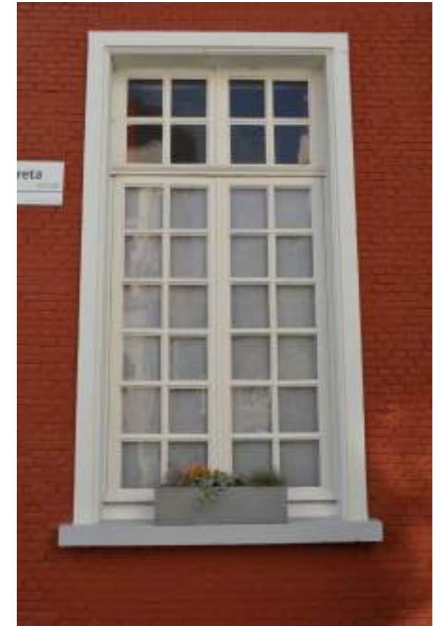
Fig.03. Detail raam links in voorgevel
