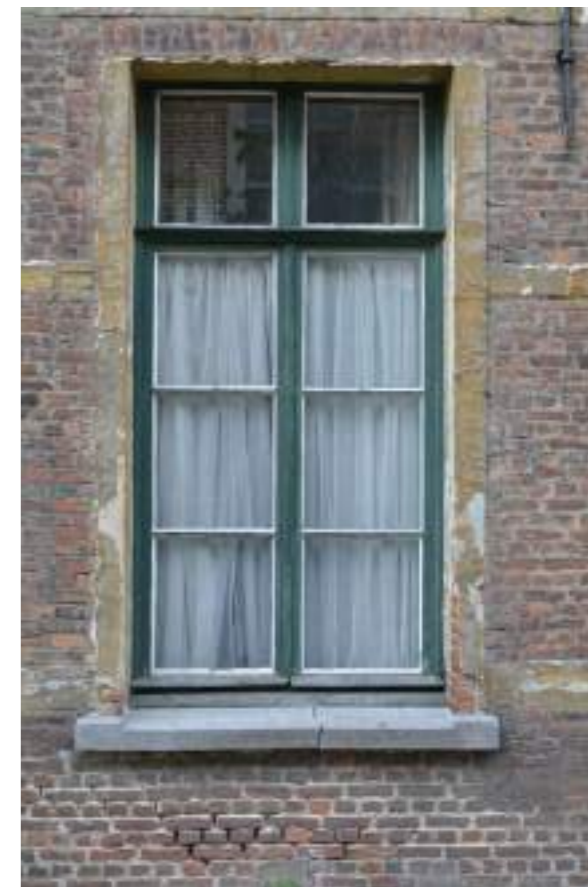
Fig.03. Detail houten schrijnwerk voorgevel
