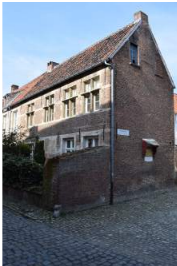
Fig.01. Zicht op voor- en zijgevel vanuit Infirmierie
