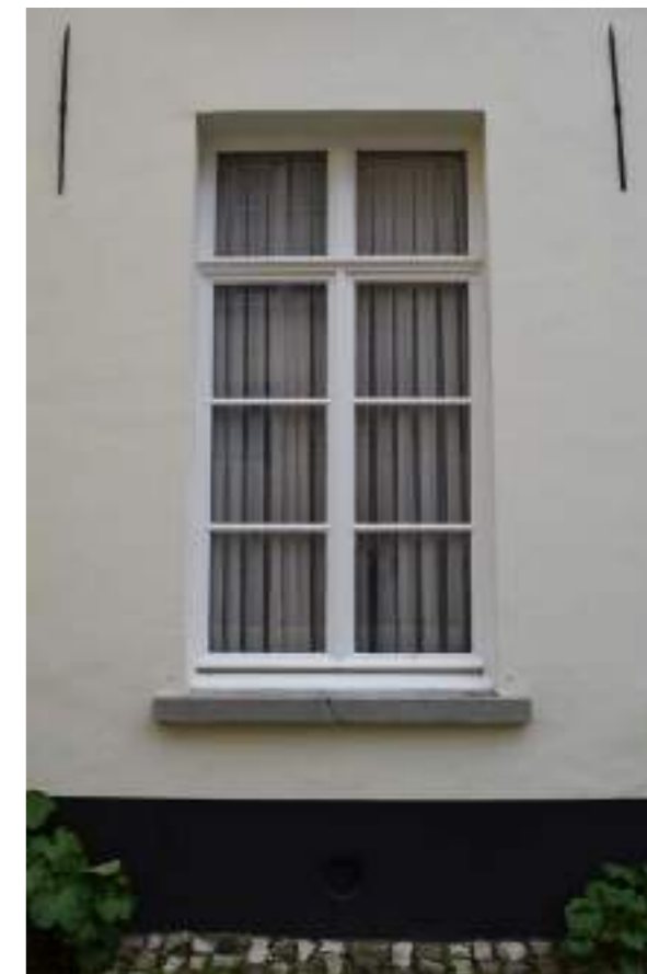
Fig.03. Detail raam en muurankers in voorgevel
