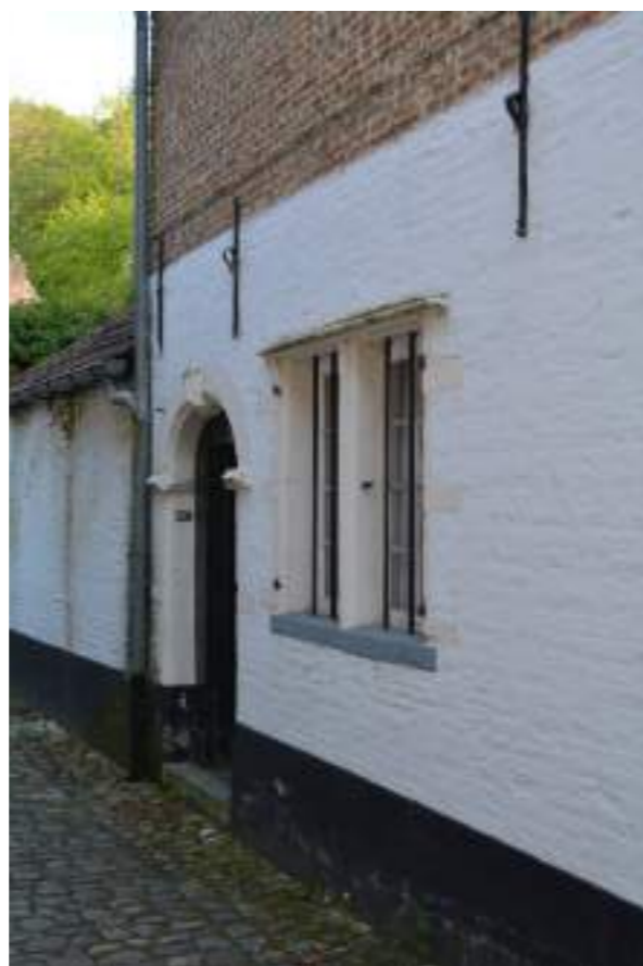
Fig.04. Voorgevel kant Hellestraat
