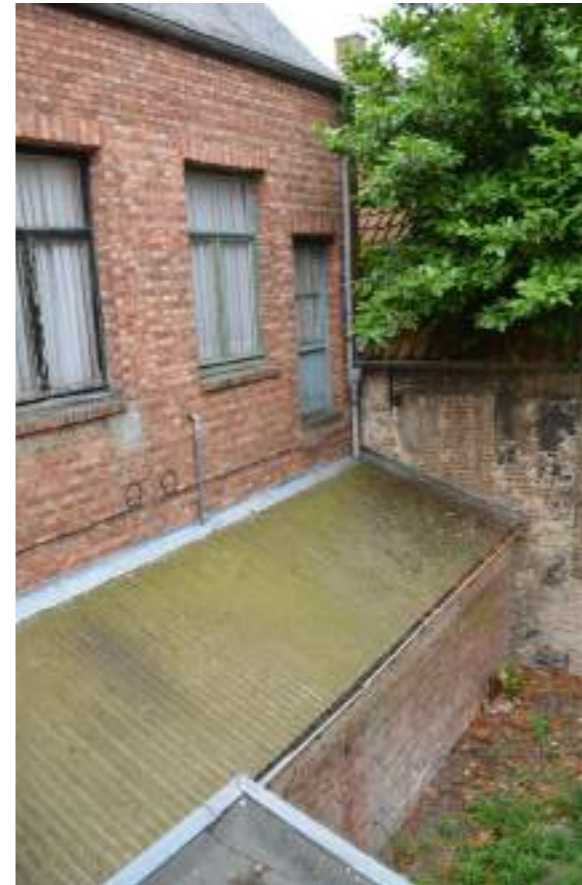
Fig.08. Zicht op golfplaten dak van aanbouw
