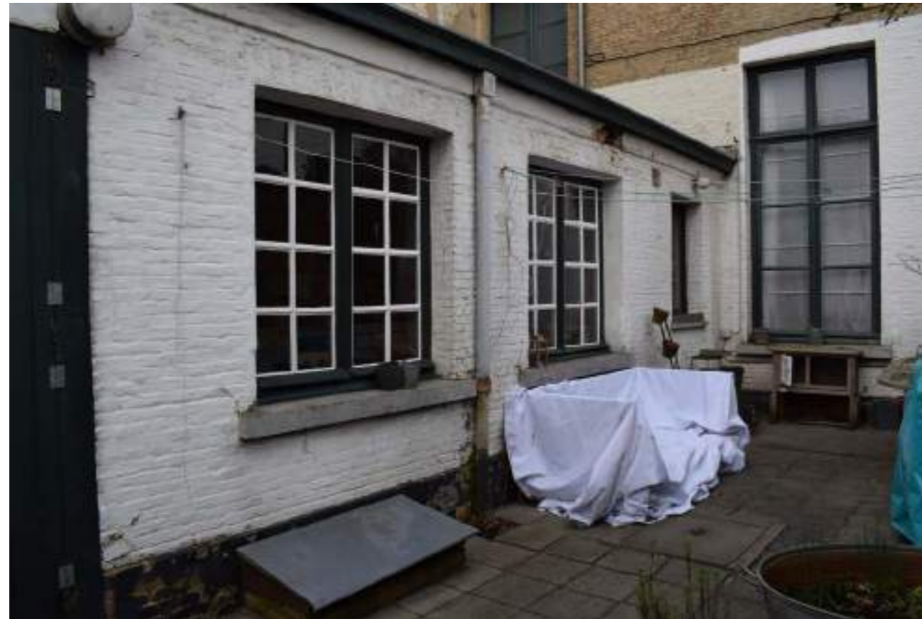
Fig.06. Aansluiting aanbouw op achtergevel
