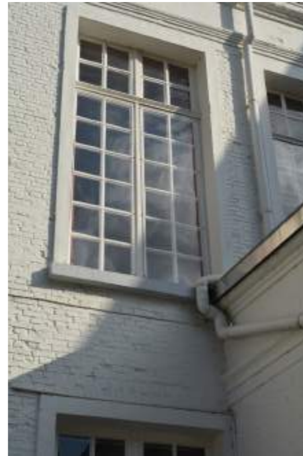
Fig.06. Detail aansluiting aanbouw en raam in achtergevel
