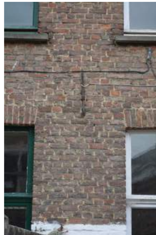
Fig.07. Detail achtergevel met muuranker
