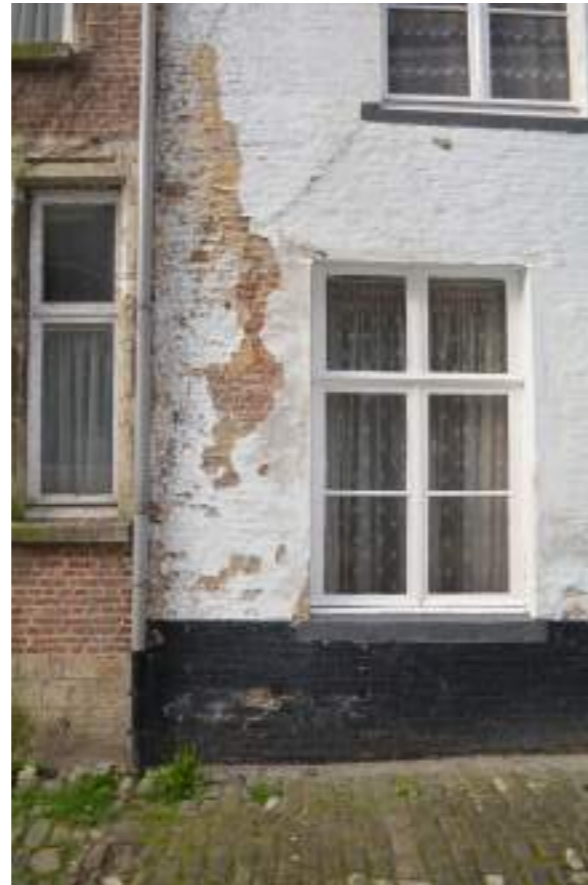
Fig.03. Detail voorgevel met wit gekalkte metselwerk
