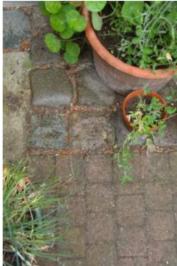
Fig.08. Detail tegelvloer en kasseien binnenkoer
