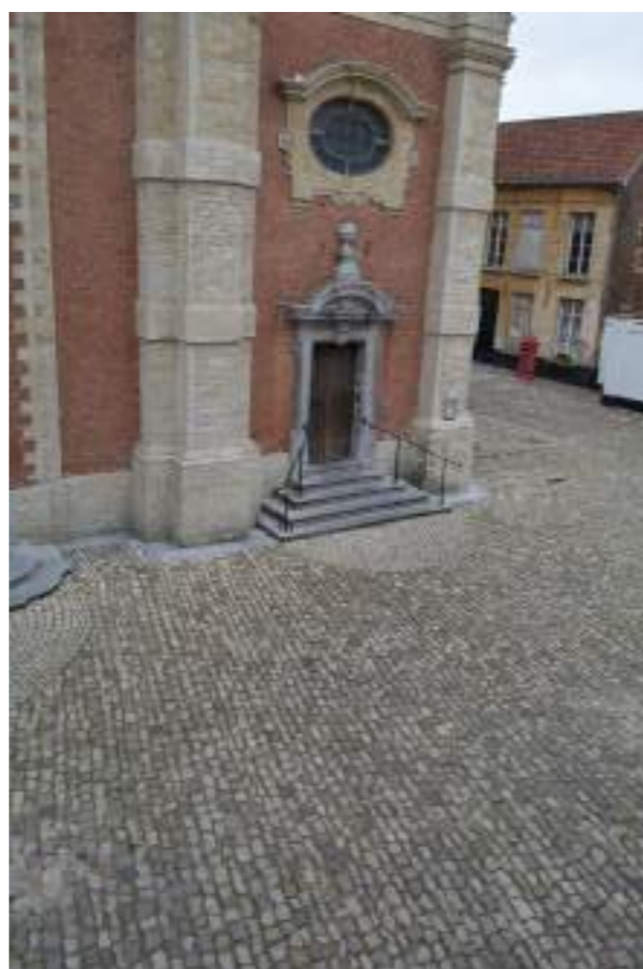
Fig.04. Zicht op deur zij-ingang vanuit SM05
