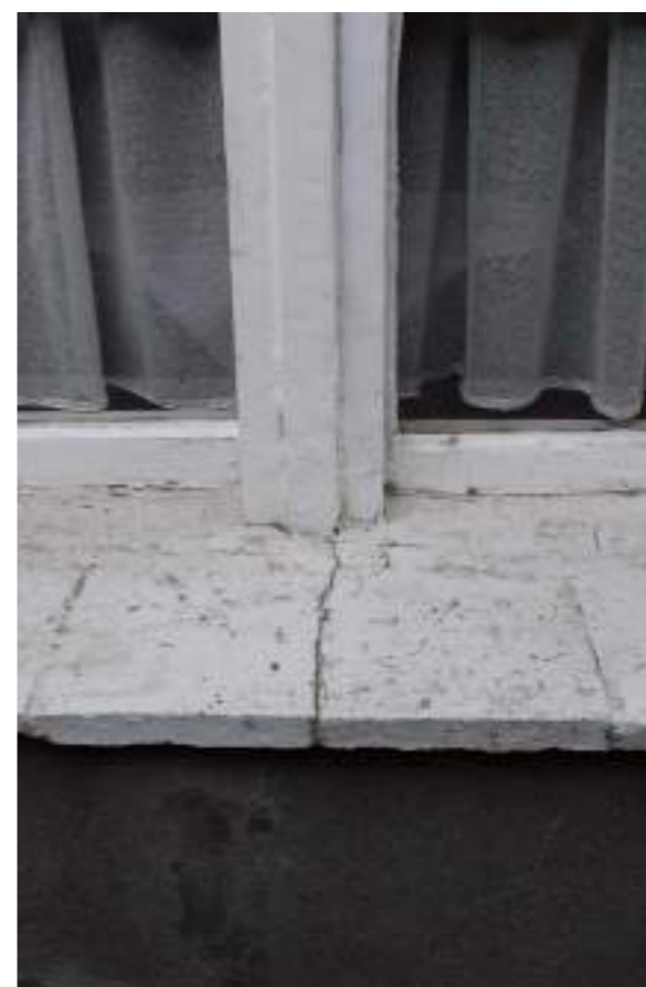
Fig.04. Detail raamdorpel met tegels
