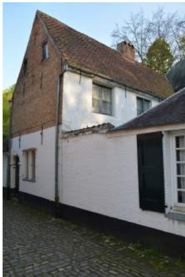
Fig.01. Voorgevel kant Hellestraat
