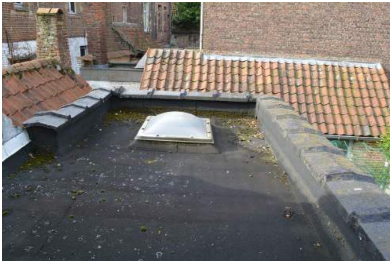
Fig.05. Plat dak aanbouw met dakkoepel
