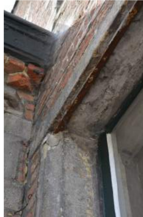
Fig.07. Detail achtergevel: lateiconstructie raamopening
