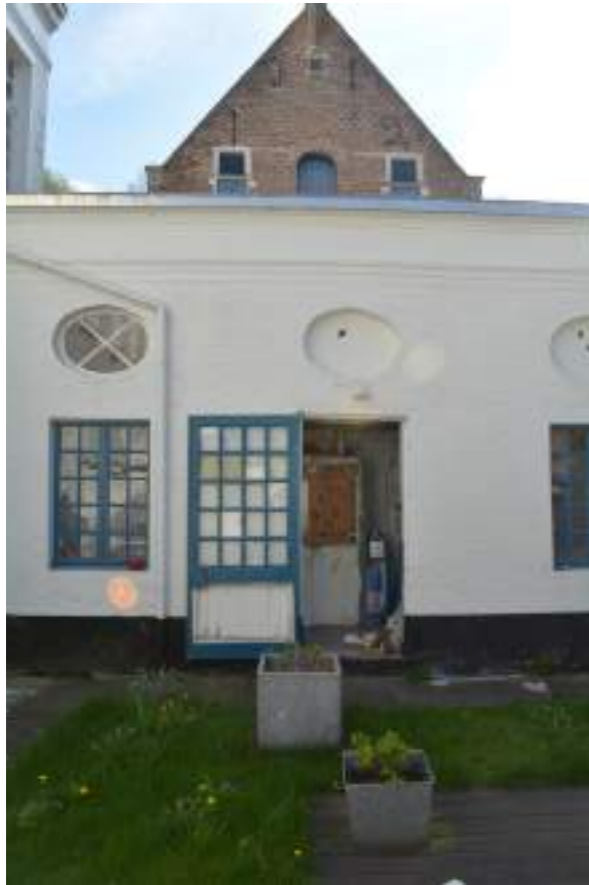
Fig.07. Gevel aanbouw, zicht op straatgevel MA20a
