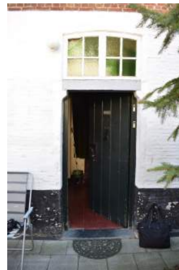
Fig.06. Voorgevel met houten voordeur en schrijnwerk
