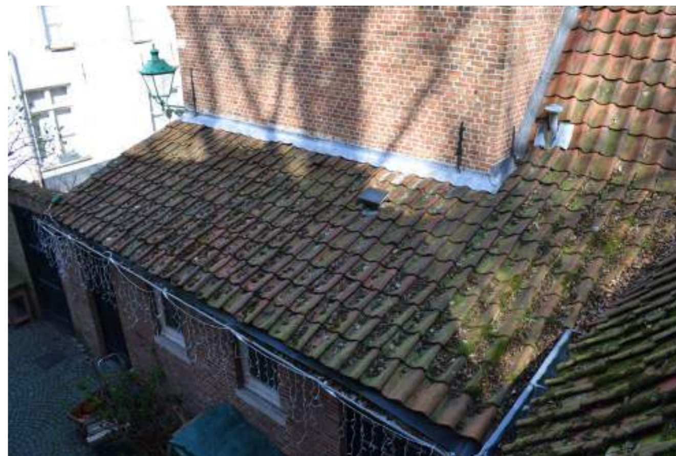
Fig.05. Zicht op dak GR14 en zijgevel GR13
