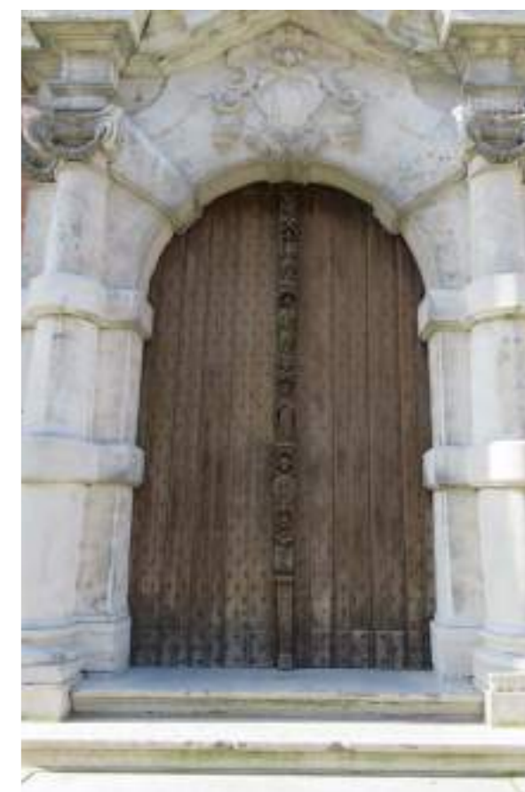
Fig.06. Detail deur hoofdingang
